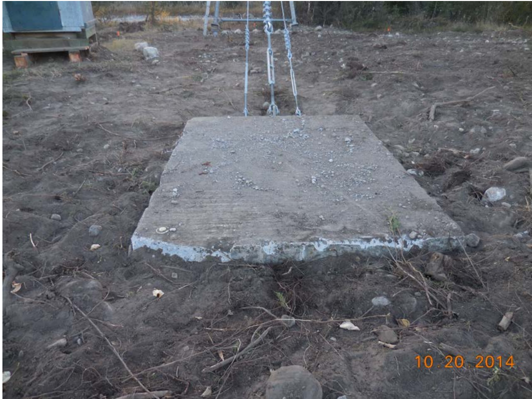
Photographie 5 : Dalle d'ancrage en béton typique avec connexions en U
