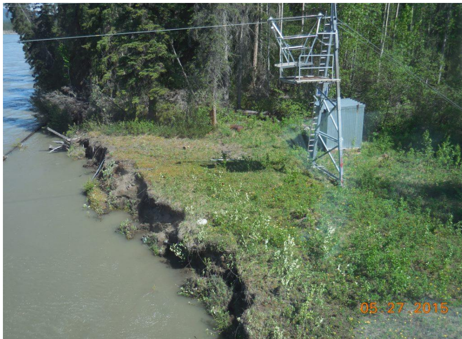
Photographie 2 : Pylône en A et plateforme typiques
