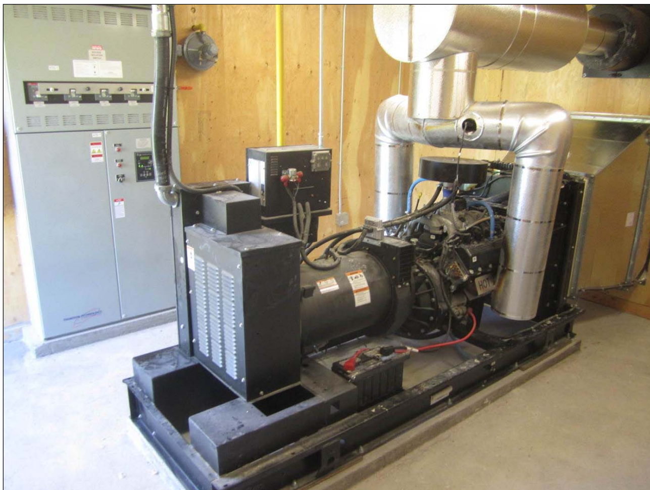
Figure 3 : Groupe électrogène à gaz naturel au barrage Témiscamingue. Ce matériel a été installé en 2012.
