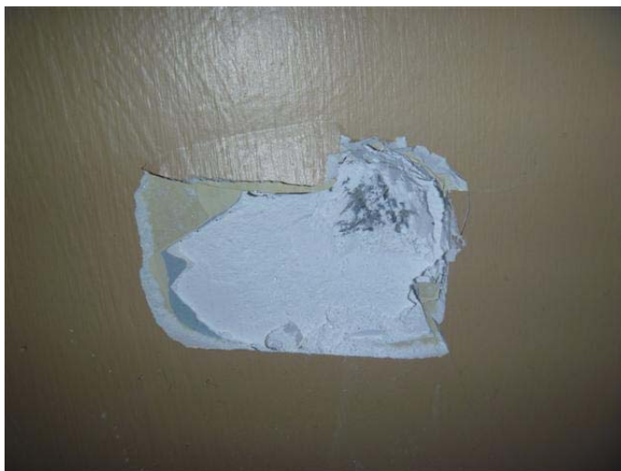
Photo 16 – Plâtre de finition présent sur les murs du niveau 0, sans amiante
