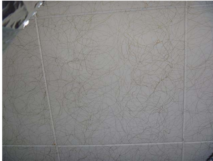
Photo 5 – Carreau de plancher collé de 1 pi 2 blanc ligné présent au rez-de-chaussée, sans amiante
