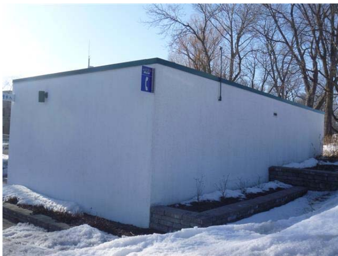
Photo 1 – Crépi cimentaire gris et blanc présent sur les murs extérieurs, sans amiante
