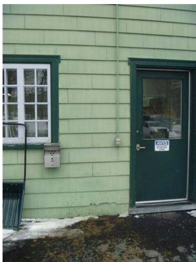
Photo 5 – Panneau de fibrociment présent sur les revêtements des murs extérieurs, contient de l'amiante
