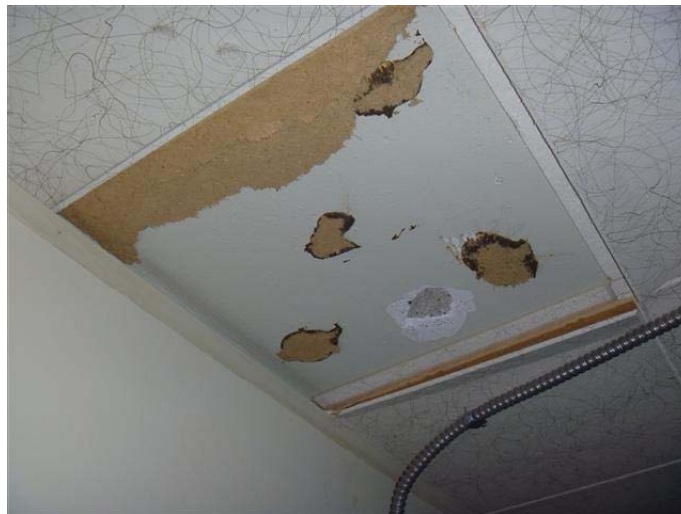
Photo 6 – Colle située sous le carreau de 1 pi 2 blanc ligné présent au rez-de-chaussée, sans amiante
