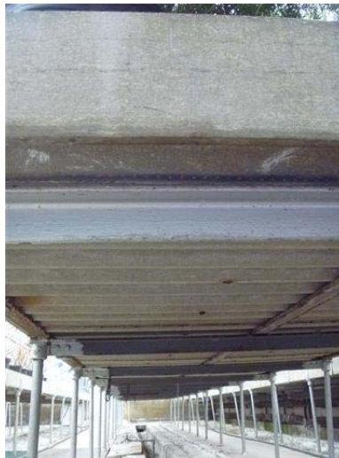
Photo 6 – Panneau de fibrociment de 1/2 po ondulé présent dans le fond des tables de la grande serre du rez-de-chaussée, contient de l’amiante
