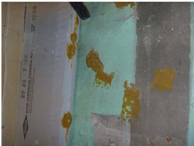
Photo 5 – Colle orange-brun appliquée sur les murs du sous-sol, sous les panneaux isolants rigides, sans amiante
