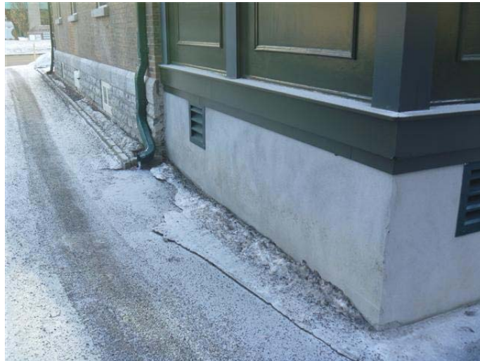
Photo 13 – Crépi cimentaire gris présent sur les murs de fondation extérieurs, sans amiante
