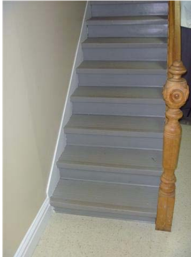
Photo 3 – Revêtement de plastique gris présent sur les escaliers du sous-sol, sans amiante
