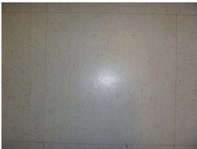
Photo 2 – Carreau de plancher de 1 pi 2 beige tacheté d’orange et de gris présent au niveau 3, sans amiante
