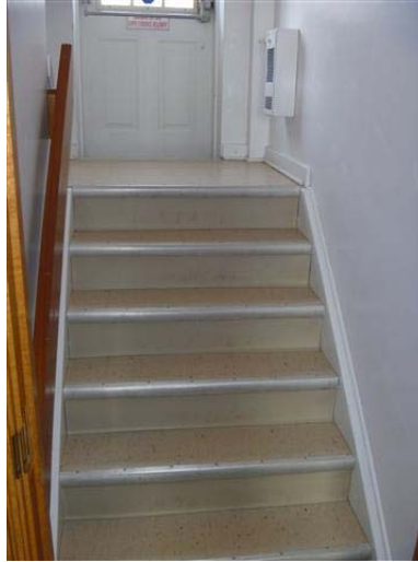
Photo 7 – Carreau de plancher de 1 pi 2 beige tacheté de bourgogne et de jaune présent dans l'escalier du premier étage, sans amiante
