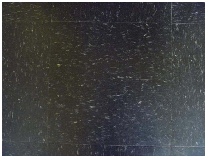
Photo 8 – Carreau de plancher de 1 pi 2 noir tacheté de blanc présent au rez-de-chaussée, sans amiante
