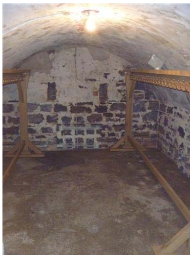
Photo 1 – Crépi cimentaire gris présent sur les murs et les plafonds de la voûte de la poudrière située au sous-sol, sans amiante
