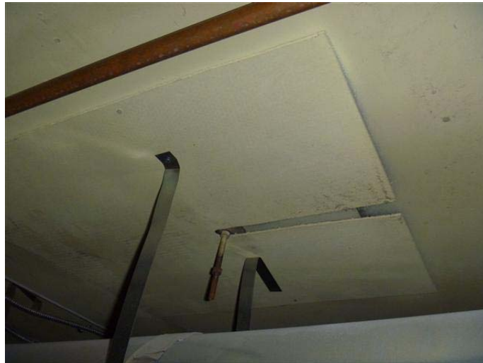
Photo 10 – Panneau de fibrociment mince présent au plafond du sous-sol, contient de l’amiante
