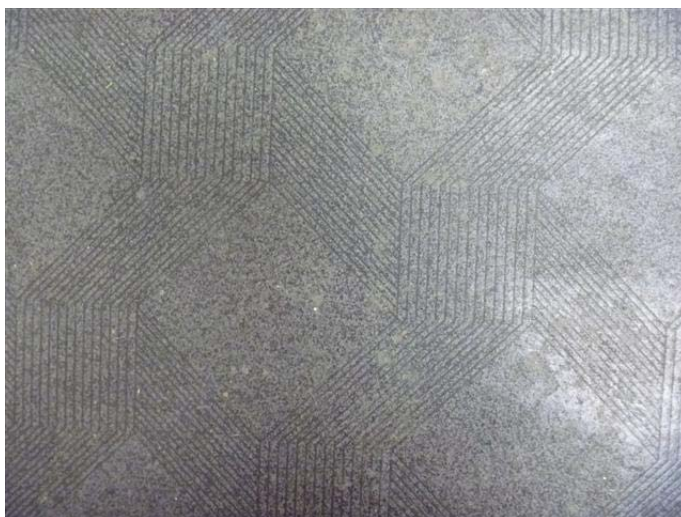
Photo 1 – Linoléum noir ligné de motifs de losanges présent au plancher du rez-de-chaussée, sans amiante
