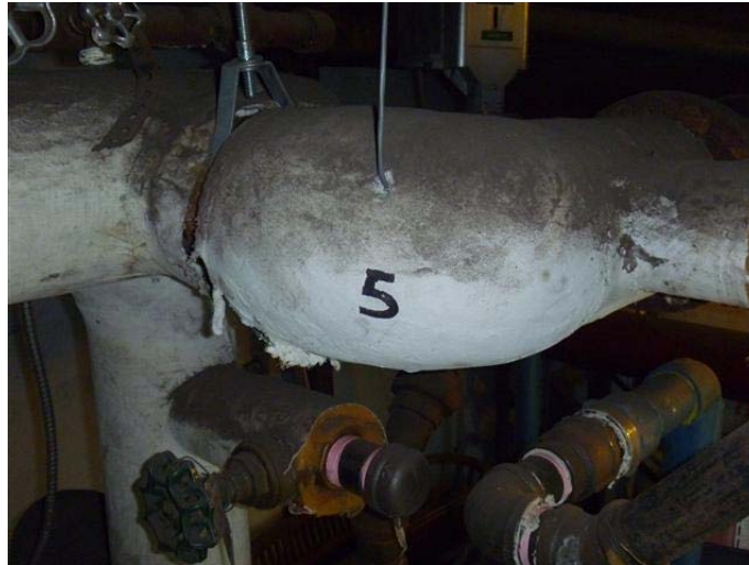
Photo 11 – Pâte cimentaire grise sur laine de verre présente sur les sections irrégulières de la tuyauterie de chauffage du sous-sol, contient de l'amiante
