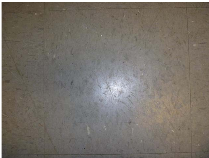
Photo 4 – Carreau de plancher de 1 pi 2 gris tacheté de gris et de blanc présent au niveau 3, sans amiante
