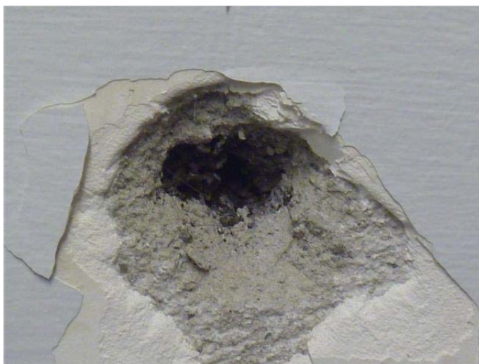
Photo 2 – Plâtre sur panneau de liège goudronné présent sur les murs et les plafonds de la voûte du sous-sol, contient de l'amiante
