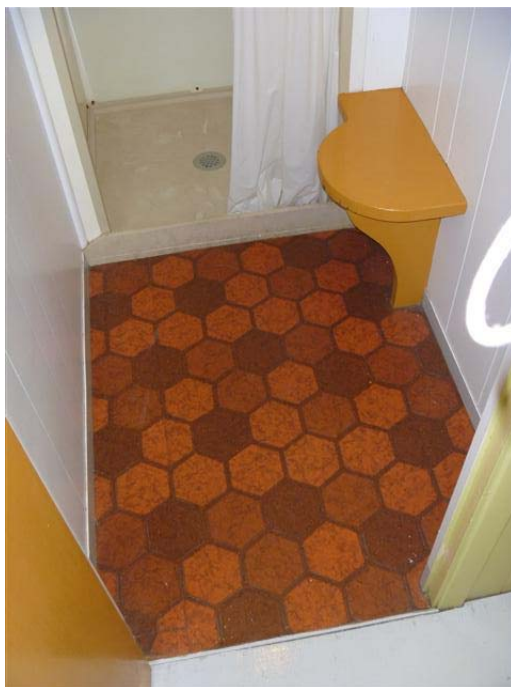
Photo 1 – Linoléum rouge vagué de bourgogne avec des motifs hexagones présent au rez-de-chaussée, contient de l’amiante
