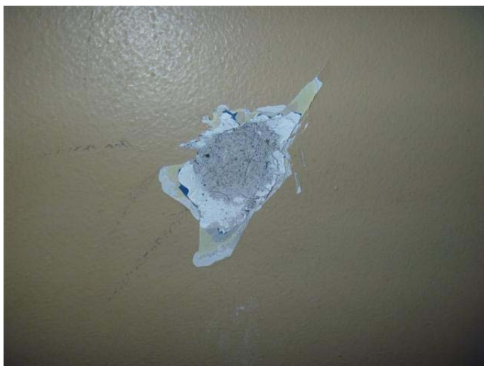
Photo 17 – Plâtre appliqué sur les murs du niveau 0, contient de l’amiante
