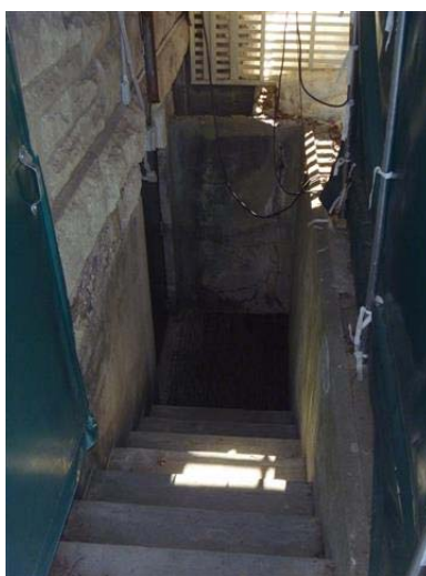
Photo 9 – Crépi cimentaire gris présent sur les murs de fondation extérieurs, sans amiante
