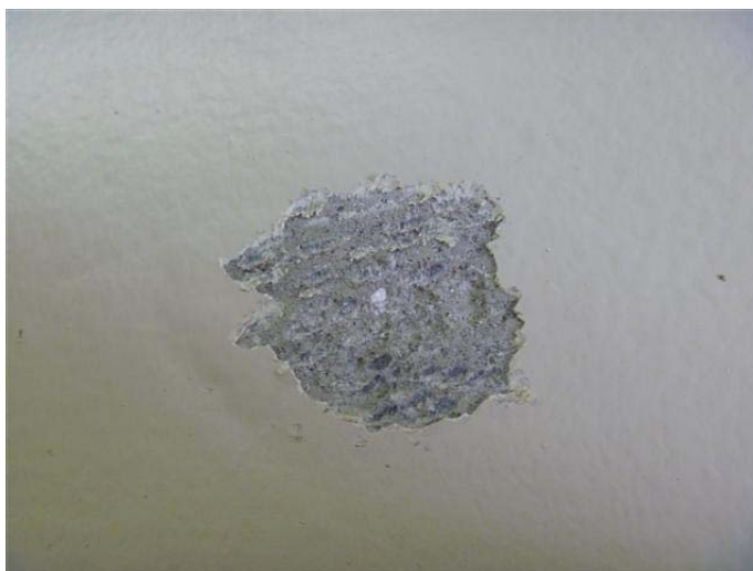
Photo 1 – Crépi cimentaire gris appliqué sur les murs du rez-de-chaussée, sans amiante
