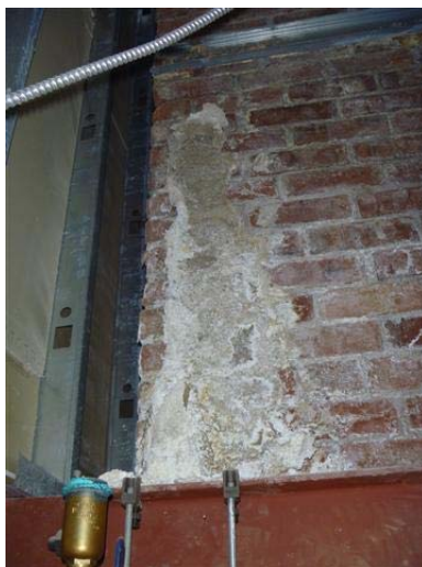
Photo 5 – Plâtre sur briques présent sur les murs du local 310, sans amiante
