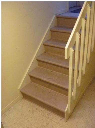
Photo 4 – Revêtement de plastique saumon présent sur les escaliers du sous-sol, sans amiante
