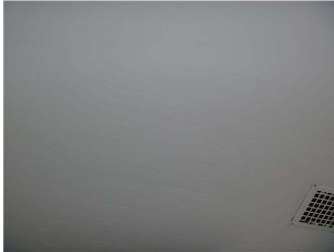
Photo 3 – Matériau cimentaire présent sur les plafonds du rez-de-chaussée, sans amiante
