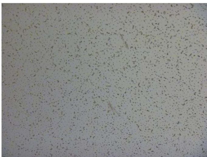
Photo 8 – Carreau de plafond suspendu de 2 pi sur 4 pi blanc troué en cercle et picoté présent au niveau 3, sans amiante
