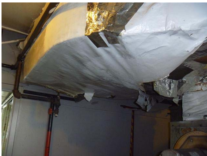
Photo 4 – Papier goudronné sur laine de verre présent sur le conduit de ventilation de la fournaise du rez-de-chaussée, sans amiante
