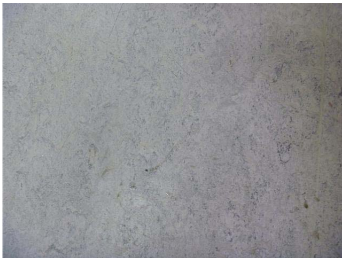
Photo 1 – Linoléum beige tacheté de bleu et de gris présent au rez-de-chaussée, sans amiante
