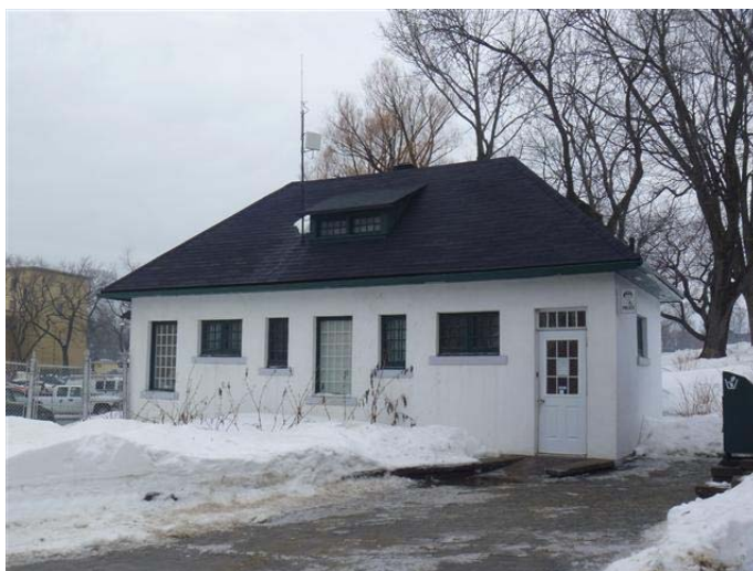
Photo 7 – Crépi cimentaire gris et blanc présent sur les murs extérieurs du bâtiment, sans amiante
