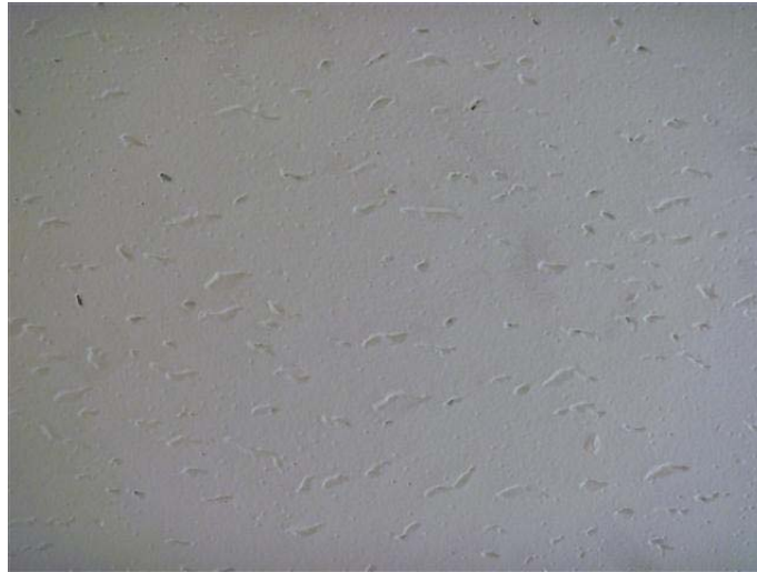
Photo 5 – Carreau de plafond suspendu en carton de 2 pi sur 2 pi blanc troué en ligne présent au plafond du rez-de-chaussée, sans amiante
