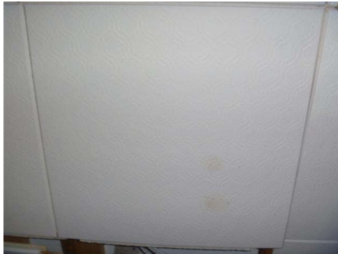
Photo 4 – Carreau embouté de 1 pi 2 blanc texturé de motifs losanges présent au rez-de-chaussée, sans amiante
