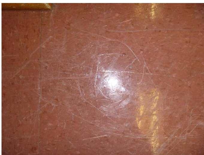
Photo 10 – Carreau de plancher de 1 pi 2 rouge tacheté d'orange et de bourgogne présent au niveau 2, sans amiante
