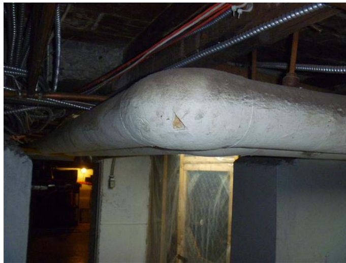
Photo 12 – Pâte cimentaire grise sur laine de verre présente sur les sections irrégulières de la tuyauterie de chauffage du sous-sol, sans amiante
