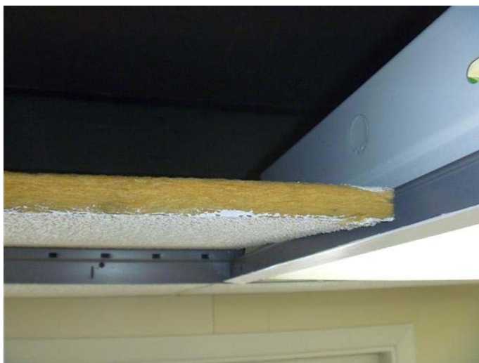
Photo 3 – Carreau de plafond suspendu en laine de verre de 2 pi sur 4 pi blanc texturé présent au rez-de-chaussée, sans amiante
