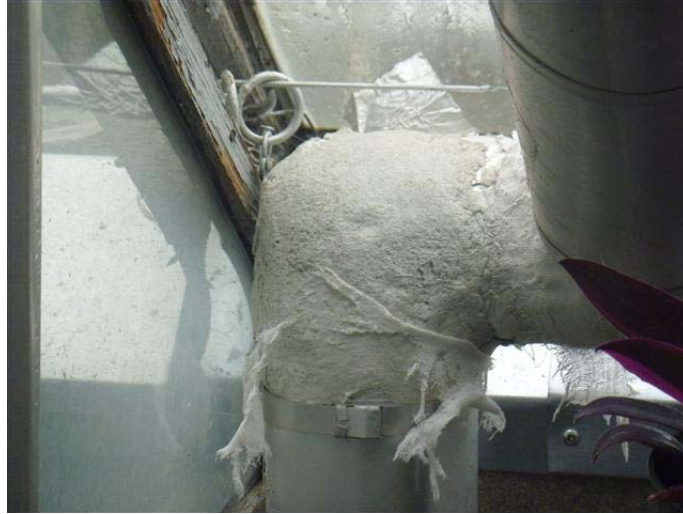
Photo 9 – Pâte cimentaire grise présente sur les sections irrégulières de la tuyauterie de chauffage de la petite et de la grande serres du rez-de-chaussée, contient de l’amiante
