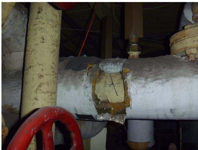
Photo 13 – Pâte cimentaire grise présente sur l'échangeur du sous-sol, contient de l'amiante
