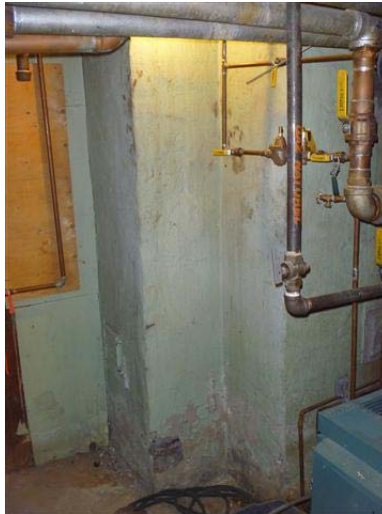
Photo 7 – Crépi cimentaire gris appliqué sur les murs de la salle mécanique du sous-sol, sans amiante
