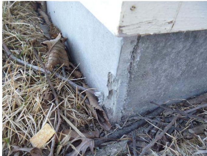
Photo 8 – Panneau de fibrociment présent sur les murs de fondation extérieurs, sans amiante
