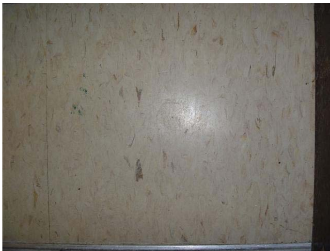
Photo 1 – Carreau de plancher de 1 pi 2 beige tacheté de bourgogne et de jaune situé dans l'escalier du sous-sol, sans amiante
