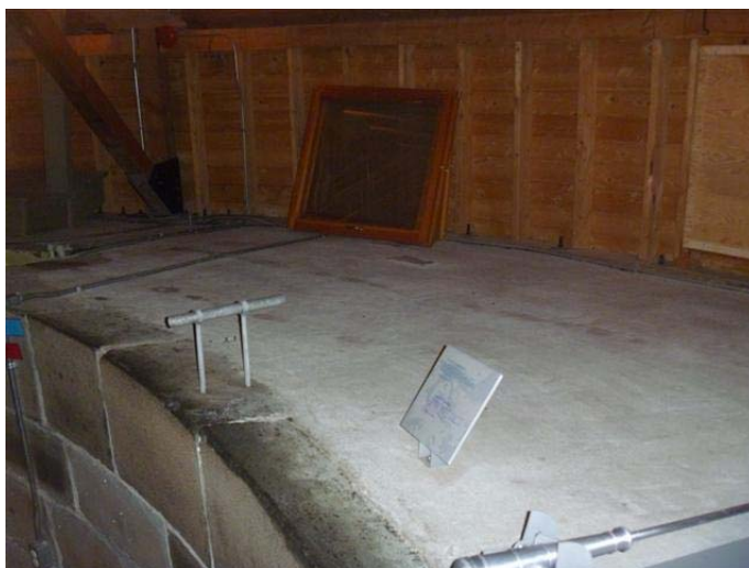
Photo 2 – Crépi cimentaire gris présent au plancher de divers locaux de l'étage, sans amiante
