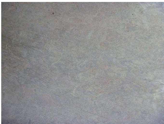
Photo 2 – Linoléum saumon vagué de gris et de beige présent au plancher du rez-de-chaussée, sans amiante
