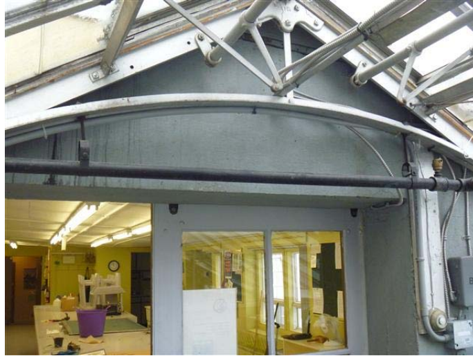
Photo 7 – Crépi cimentaire gris présent sur les murs du rez-de-chaussée, sans amiante
