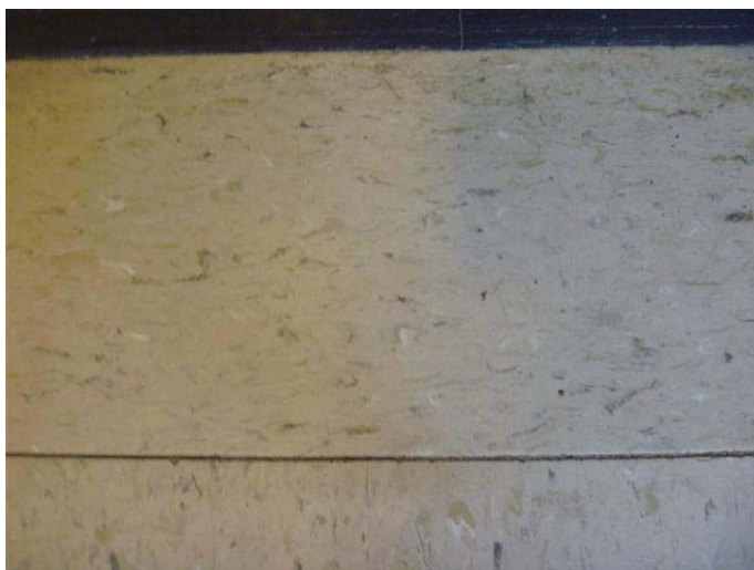
Photo 2 – Carreau de plancher de 1 pi 2 beige tacheté de blanc, de gris et de brun présent au rez-de-chaussée, sans amiante
