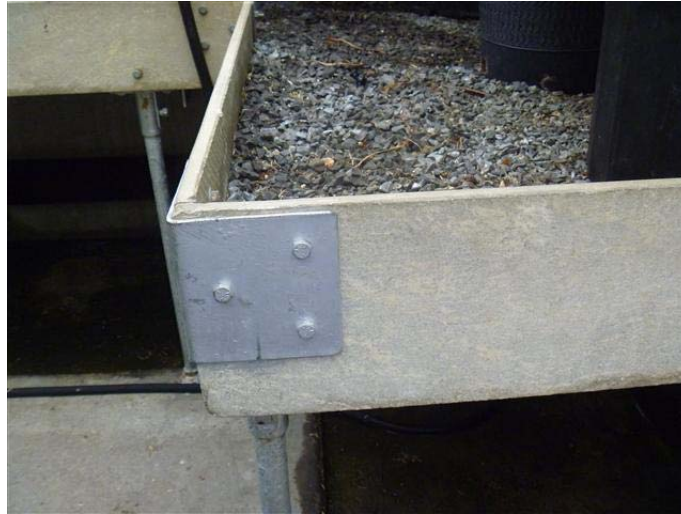
Photo 5 – Panneau de fibrociment de 1/2 po présent sur le rebord des tables de la petite et de la grande serres du rez-de-chaussée, contient de l’amiante
