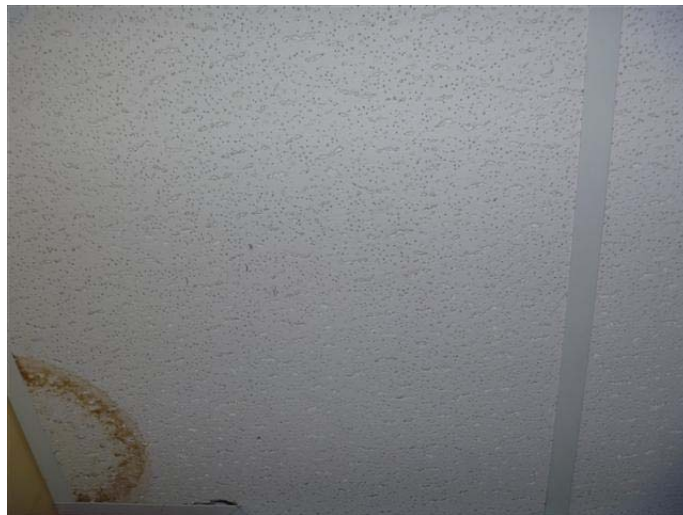
Photo 10 – Carreau de plafond suspendu de 2 pi sur 2 pi blanc troué en ligne et picoté présent au rez-de-chaussée, sans amiante
