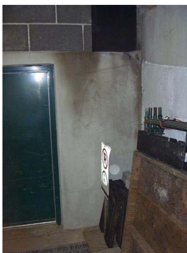
Photo 7 – Crépi cimentaire gris présent sur les murs de fondation, sans amiante
