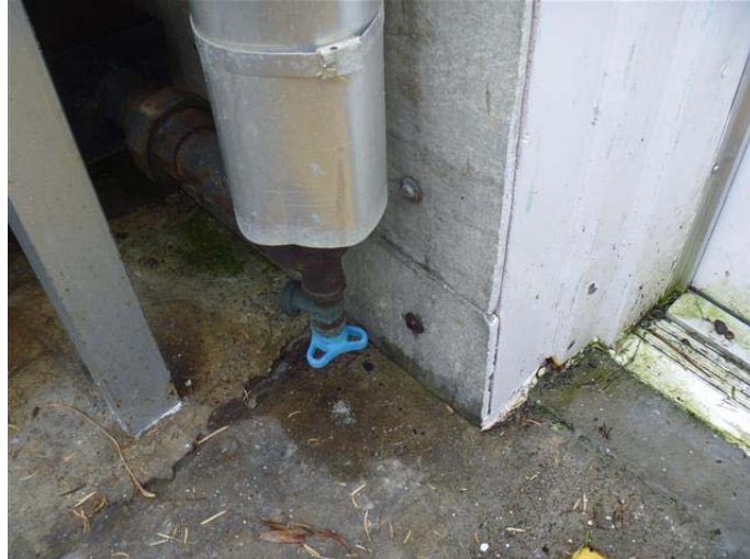
Photo 4 – Panneau de fibrociment de 1/4 po présent sur les murs de la petite et de la grande serres du rez-de-chaussée, contient de l'amiante
