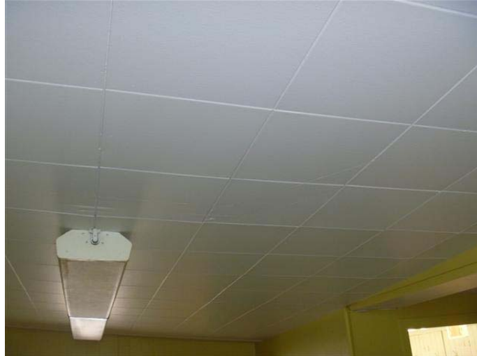
Photo 8 – Carreau embouté en carton de 1 pi 2 blanc présent au plafond du rez-de-chaussée, sans amiante
