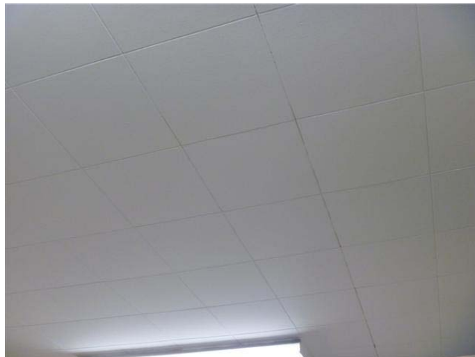
Photo 4 – Carreau embouté en carton de 1 pi 2 blanc présent au plafond du rez-de-chaussée, sans amiante
