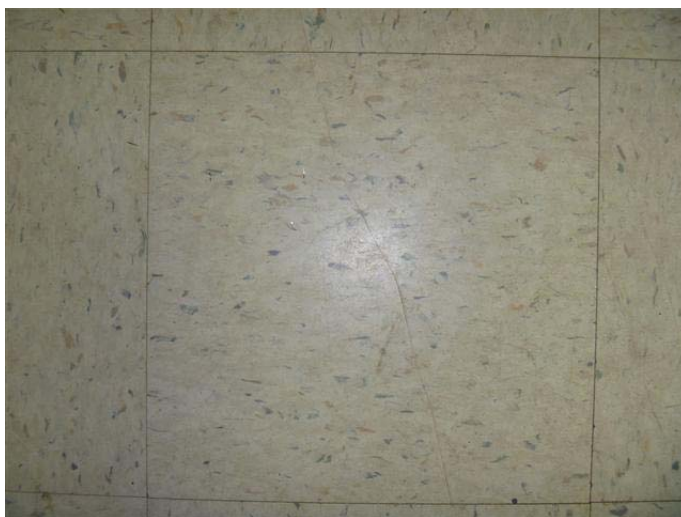
Photo 2 – Carreau de plancher de 1 pi 2 beige tacheté de gris, de saumon et de blanc présent au sous-sol, sans amiante
