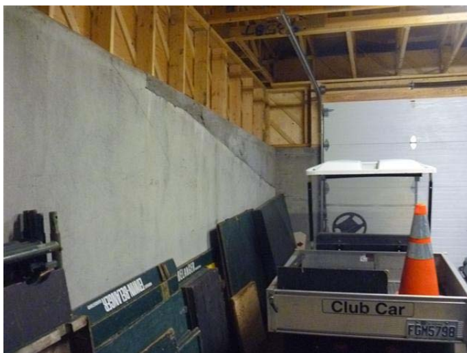
Photo 6 – Crépi cimentaire gris présent sur les murs du garage, sans amiante
