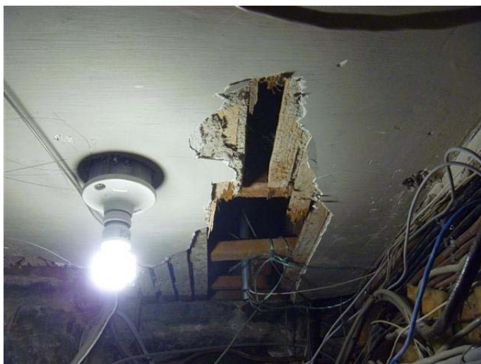
Photo 6 – Plâtre appliqué au plafond du sous-sol, contient de l'amiante
