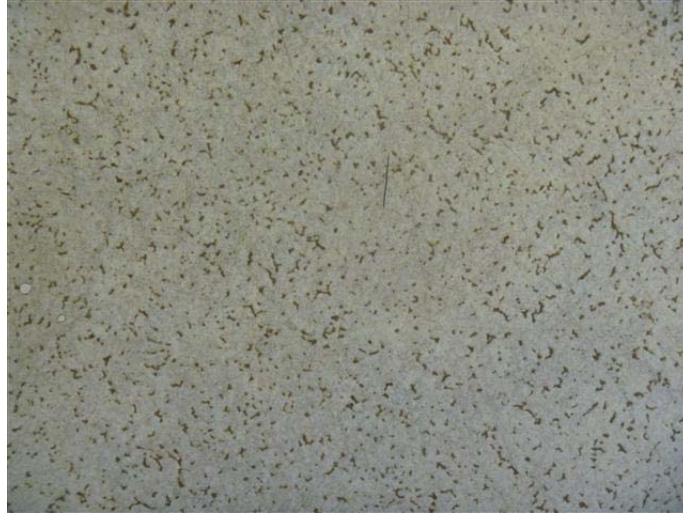
Photo 3 – Linoléum beige picoté de brun présent au rez-de-chaussée, sans amiante
