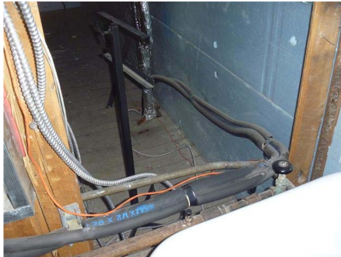
Photo 12 – Mousse noire de type « Armaflex » présente sur la tuyauterie d'eau domestique au niveau de l'attique, sans amiante
