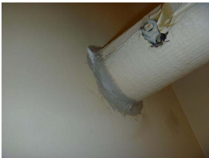
Photo 15 – Joint d'étanchéité gris présent sur les murs et la tuyauterie du niveau 1, sans amiante
