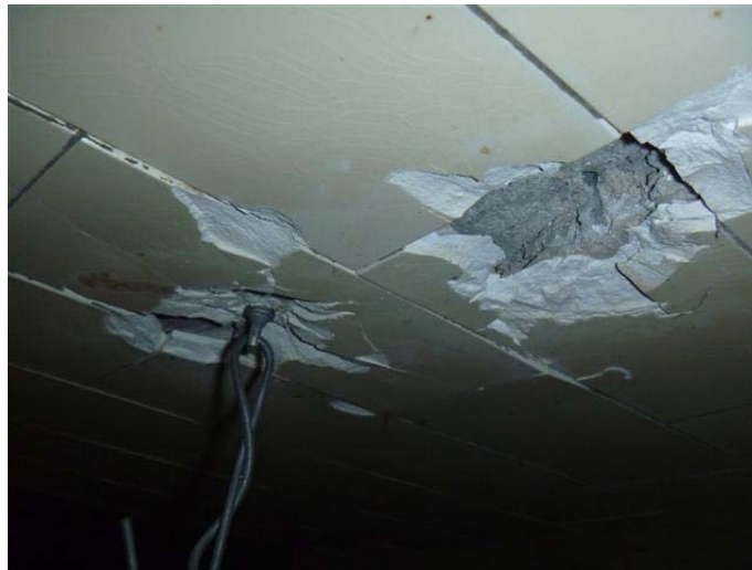
Photo 6 – Crépi cimentaire gris présent sur les plafonds du rez-de-chaussée, sans amiante
