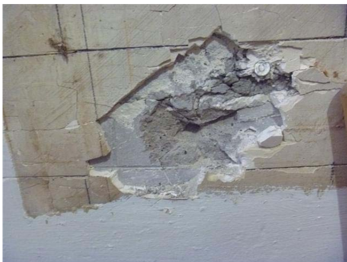
Photo 2 – Matériau cimentaire présent sur les murs de la salle de bain du rez-de-chaussée, sans amiante
