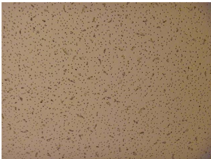
Photo 6 – Carreau de plafond suspendu de 2 pi sur 4 pi beige troué en cercle et picoté présent au niveau 3, sans amiante
