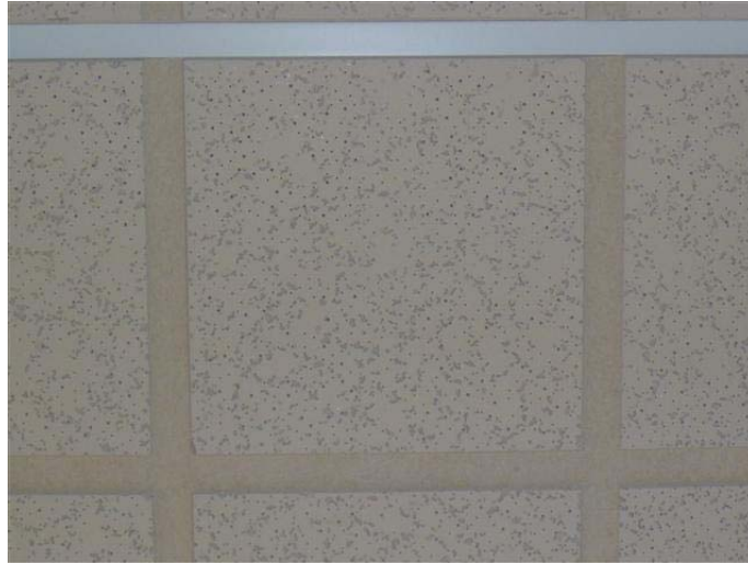
Photo 3 – Carreau de plafond de 2 pi sur 4 pi beige troué en cercle avec 8 embossés carrés présent au rez-de-chaussée, sans amiante
