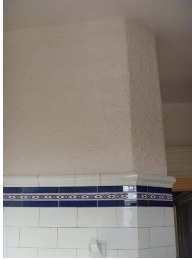
Photo 11 – Plâtre texturé présent sur les murs de la toilette du 1 er étage, contient de l'amiante
