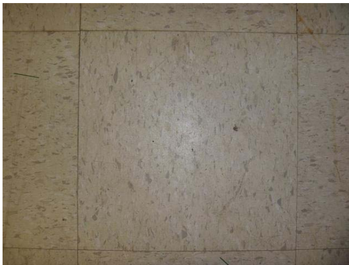
Photo 1 – Carreau de plancher de 1 pi 2 beige tacheté de gris et de blanc présent au sous-sol, sans amiante
