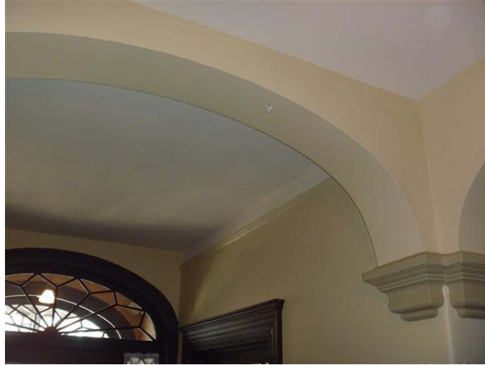
Photo 9 – Plâtre appliqué au plafond du rez-de-chaussée, contient de l'amiante
