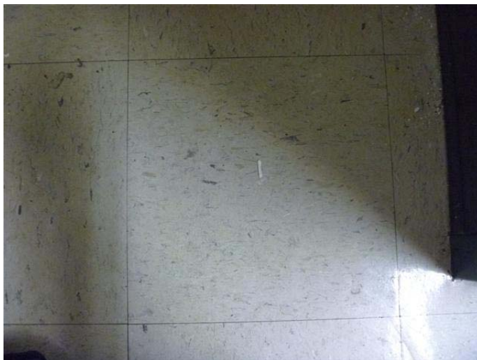
Photo 5 – Carreau de plancher de 1 pi 2 beige tacheté de blanc, de gris et de brun présent au sous-sol, sans amiante
