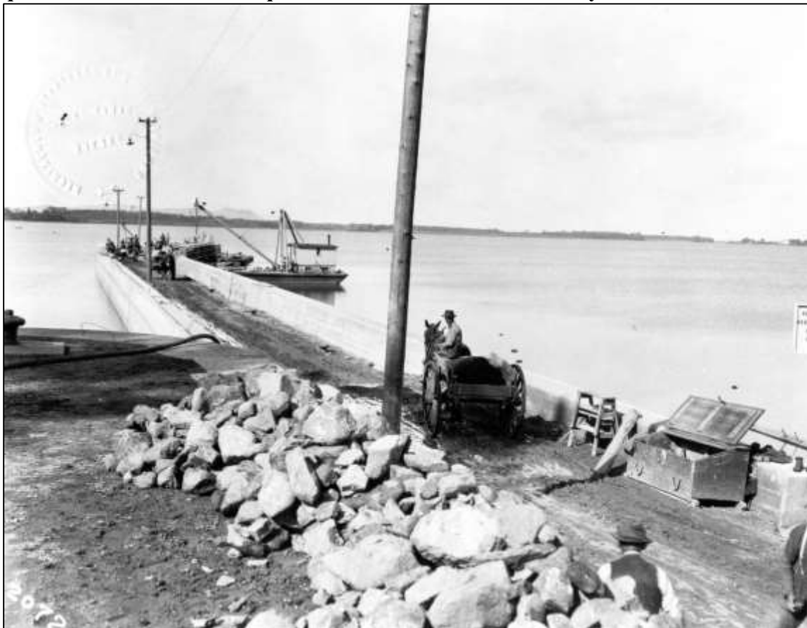
Le quai Fédéral lors de travaux en 1931 (Archives de Parcs Canada, Québec, Canaux du Québec no. n.d, 1931)
