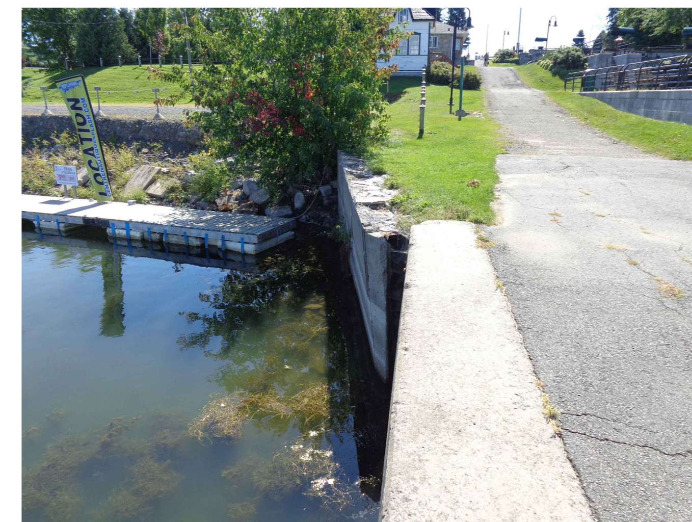
C11 MUR DE SOUTÈNEMENT CONCRETE RETAINING WALL
