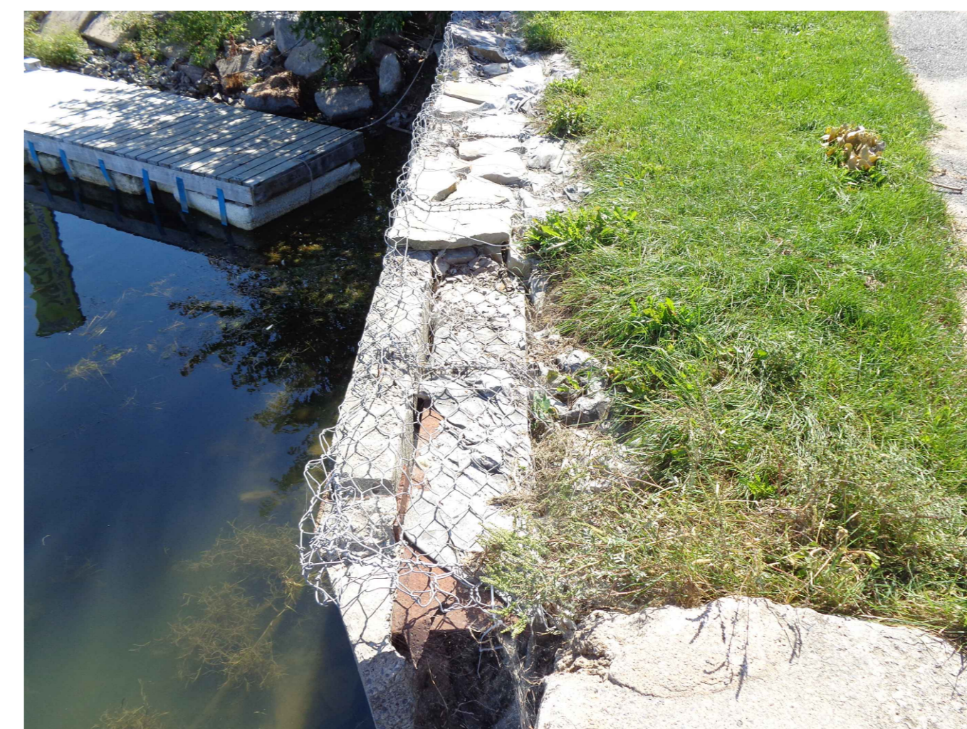
C12 MUR DE SOUTÈNEMENT CONCRETE RETAINING WALL
