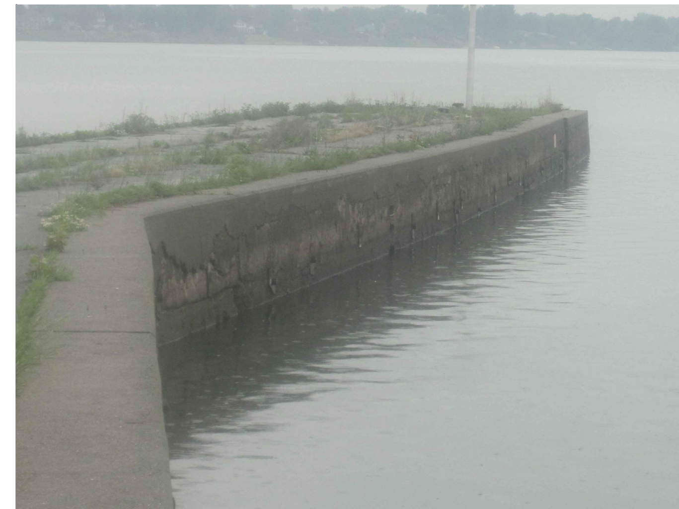
C2 MUR DU QUAI WALL OF WHARF
