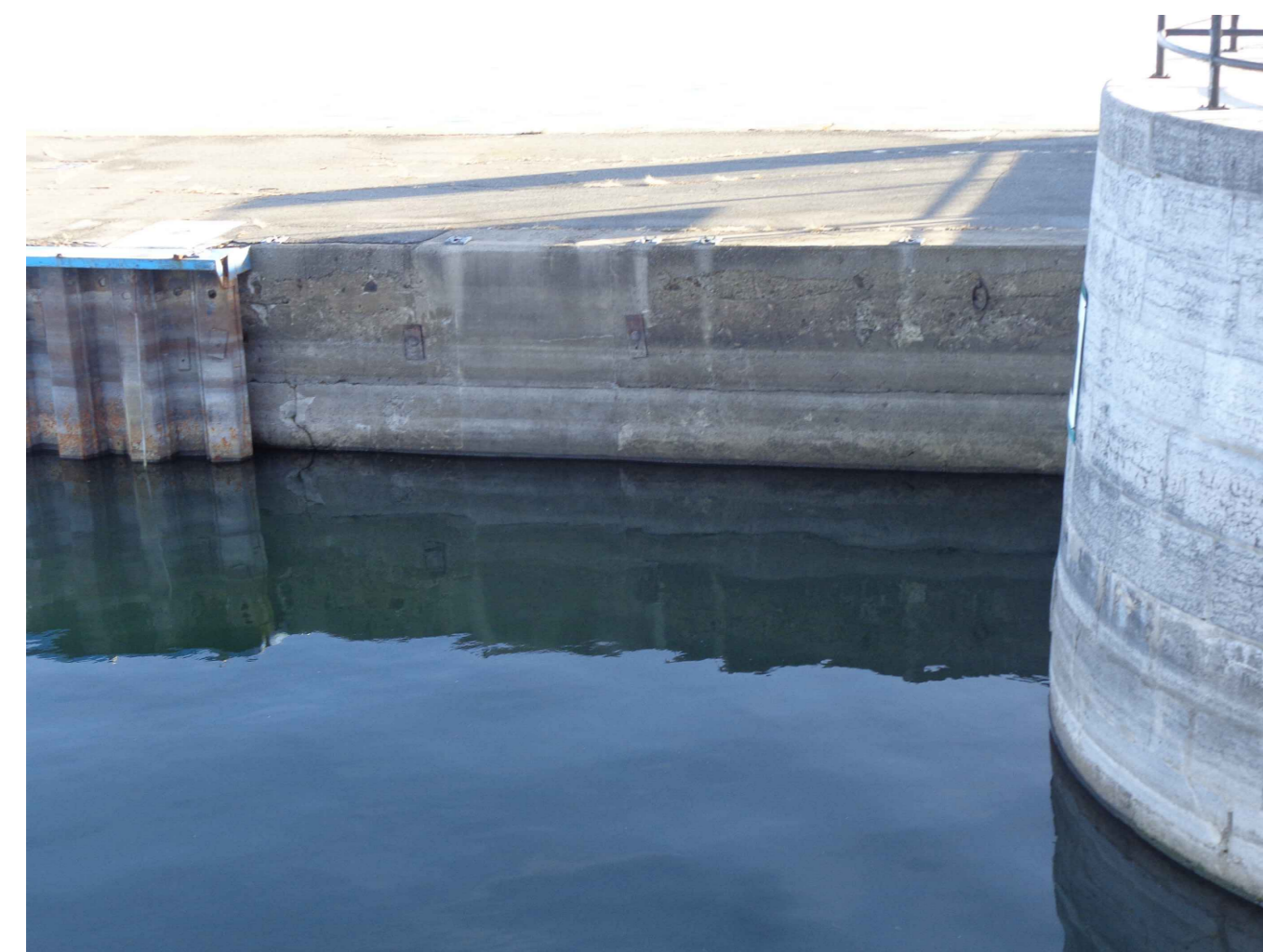
C5 DÉBUT PALPLANCHES BEGINNING SHEETPILES
