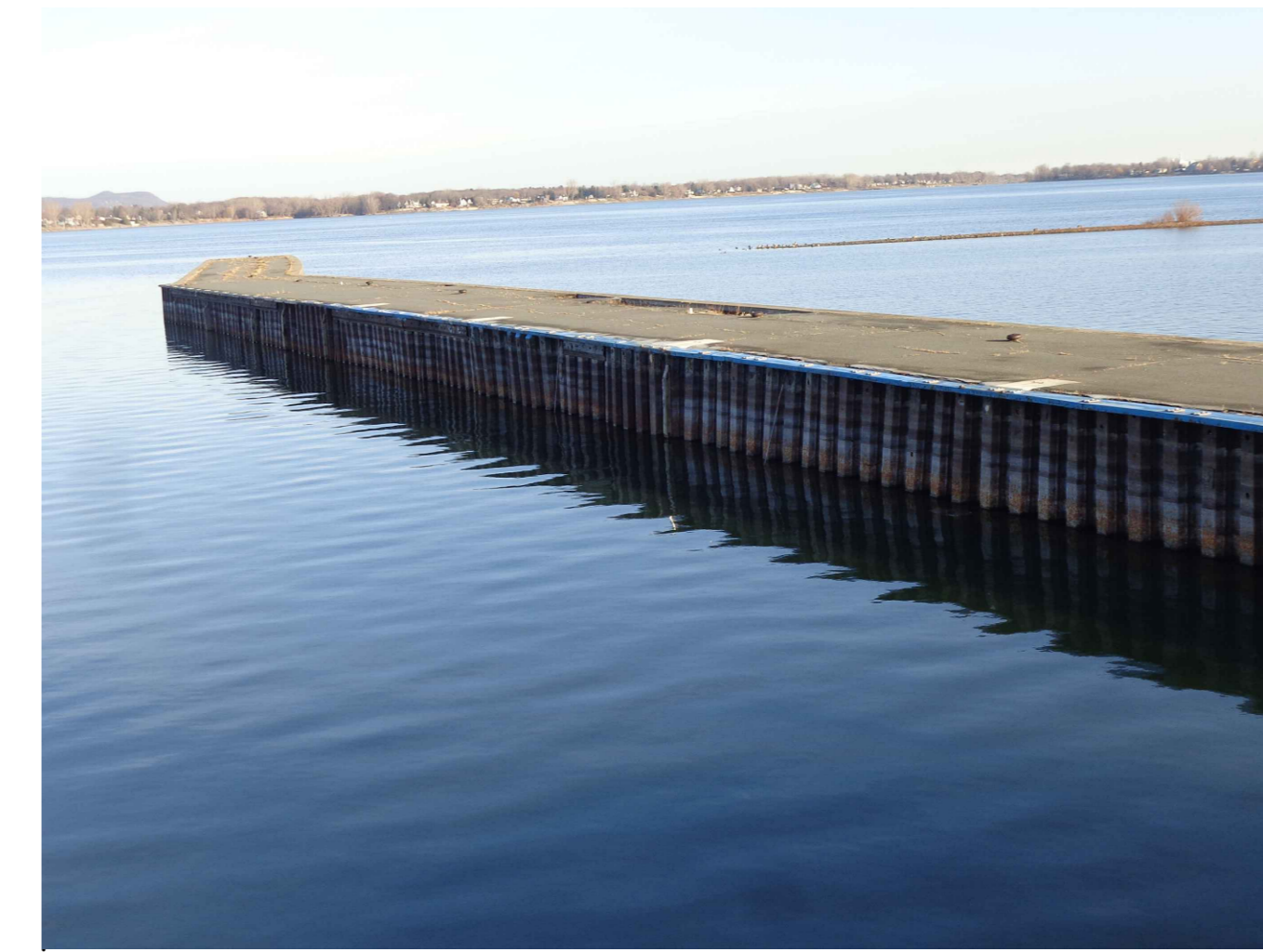
C4 COTÉ PALPLANCHES SHEET PILES SIDE
