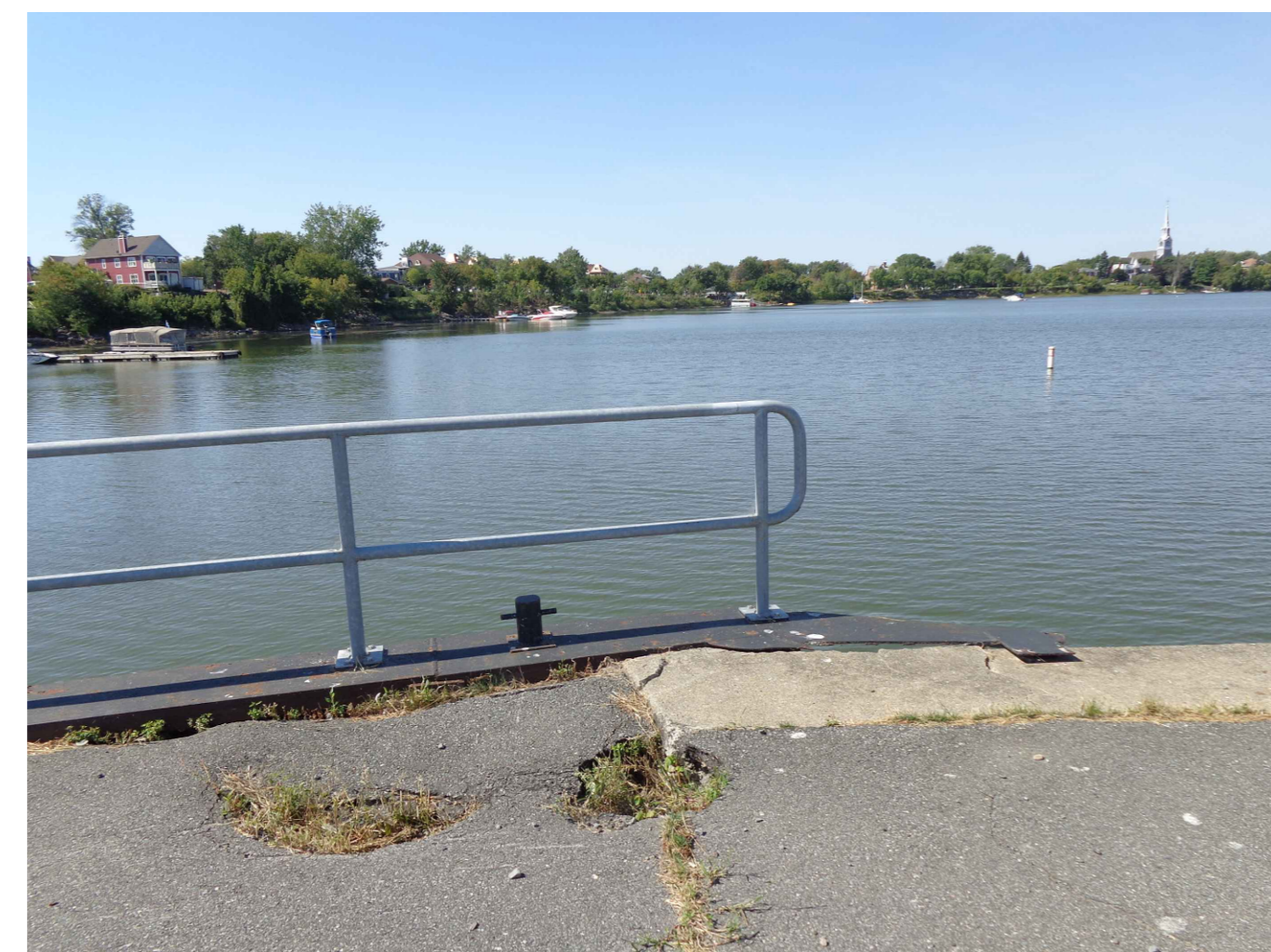
C10 FIN PALPLANCHES END OF SHEET PILES
