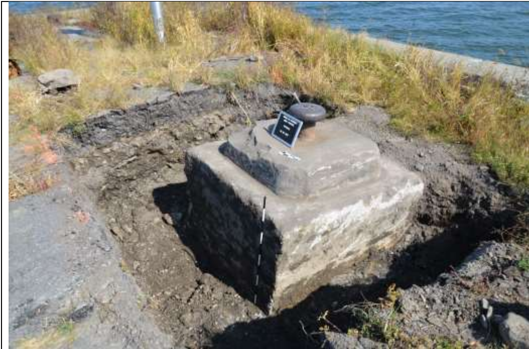
Figure 7 – Bollard et sa base de béton à deux niveaux (510G13A101) localisés à l'extrémité nord-est du quai Fédéral (Photo Matthieu Paradis, Parcs Canada).
