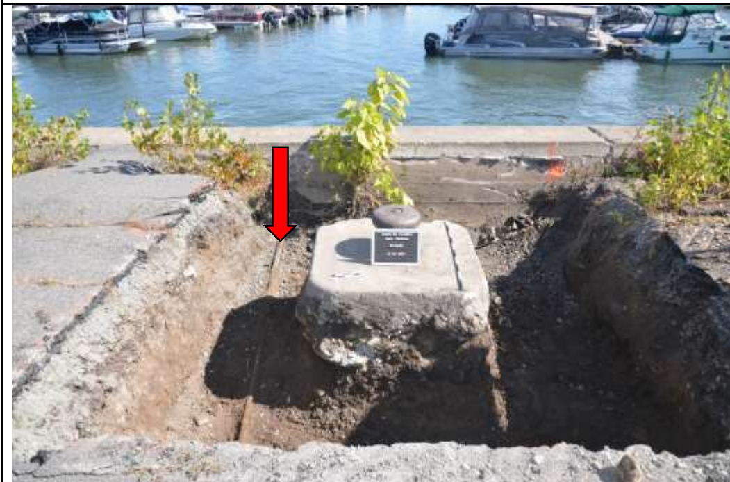
Figure 8 – Dimensions de l'excavation, bollard, base de béton massif, et tirant fixé au mur est (510G13C102) localisée dans la partie sud-est du quai Fédéral (Photo Matthieu Paradis, Parcs Canada).
