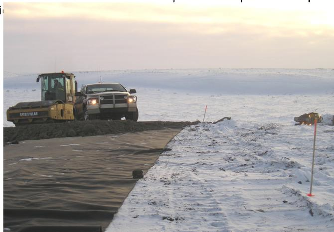
**Pose d'un géotextile pour la construction d'une route praticable par tous les temps sur le tracé
