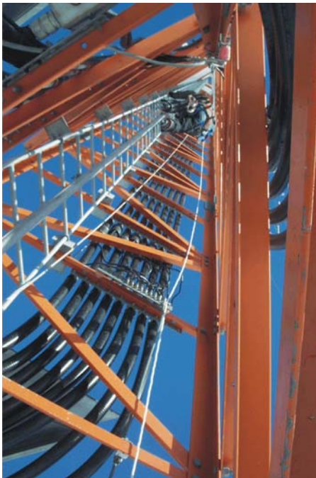
Figure 2-6 Les collecteurs de terre de la tour sont fixés près de l'entrée du couvre-câbles, où les lignes de transmission quittent la tour pour s'acheminer horizontalement vers la salle des communications en passant par le couvre-câbles.
