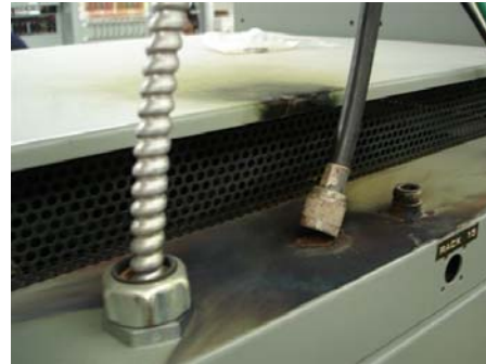
Figure 1-2 Émetteur-récepteur endommagé par la foudre, qui a voyagé le long de la ligne de transmission jusque
