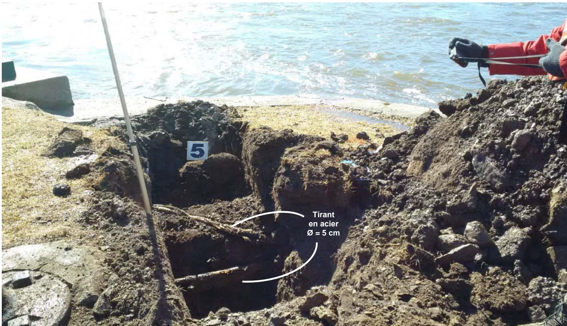
Photo 5 – Tranchée no TR-05 – Mur en béton avec tirants
