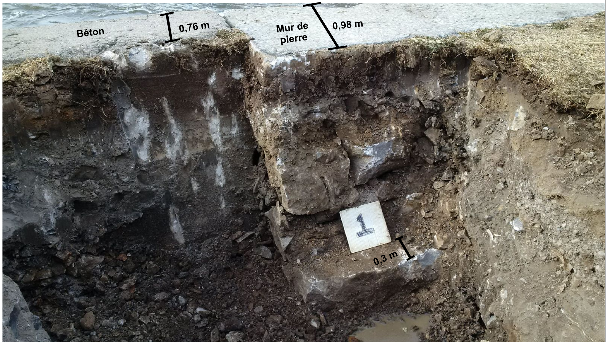
Photo 1 – Tranchée no TR-01 - Jonction du mur en béton et en blocs de pierre
