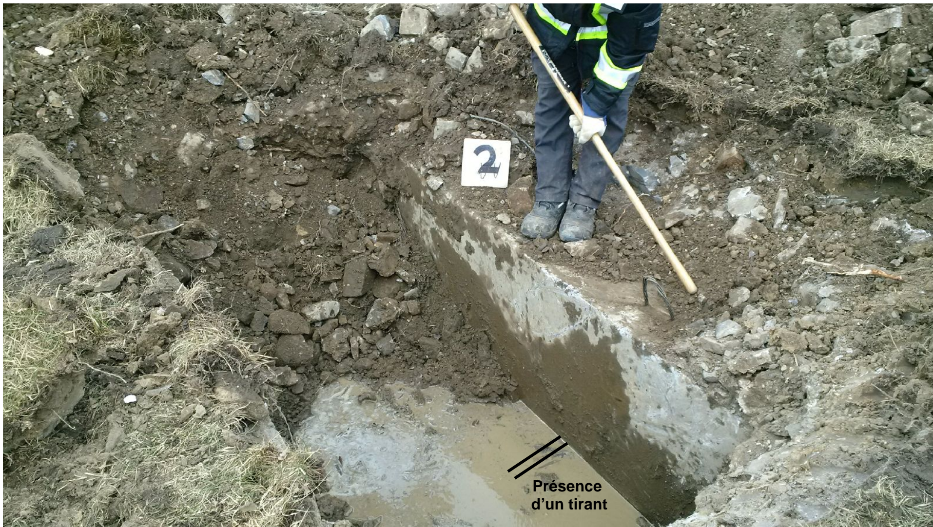
Photo 2 – Tranchée no TR-02 – Massif en béton préfabriqué avec un tirant en acier
