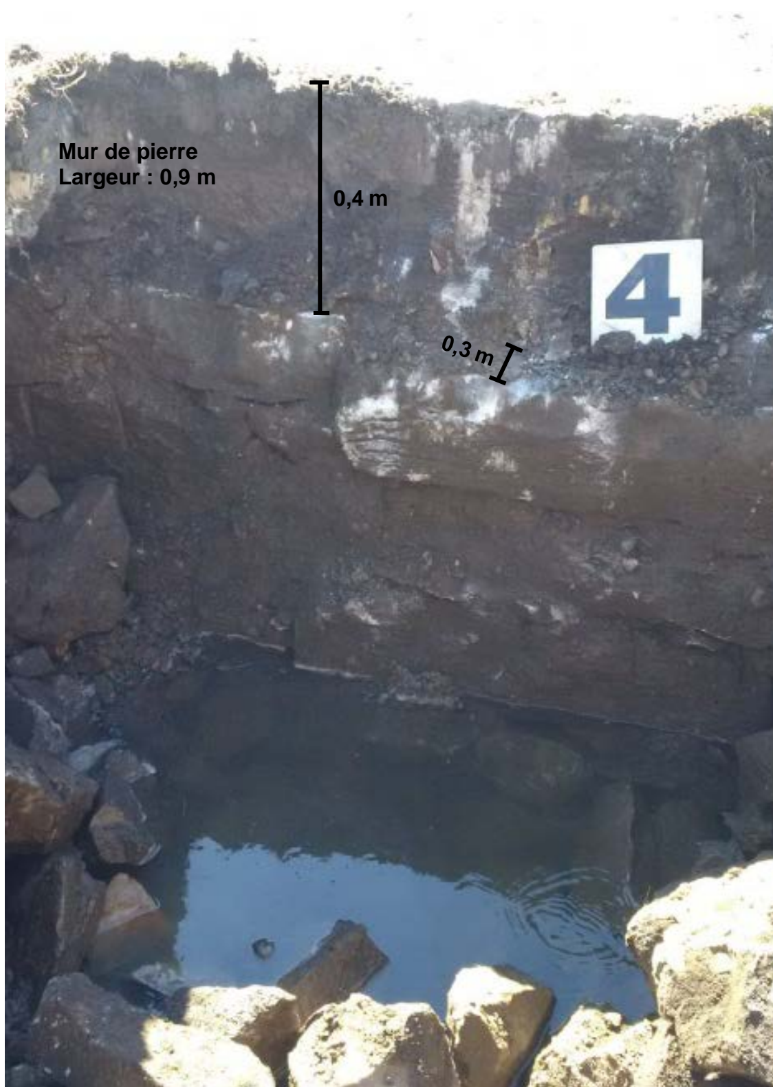
Photo 4 – Tranchée no TR-04 – Mur en blocs de pierre
