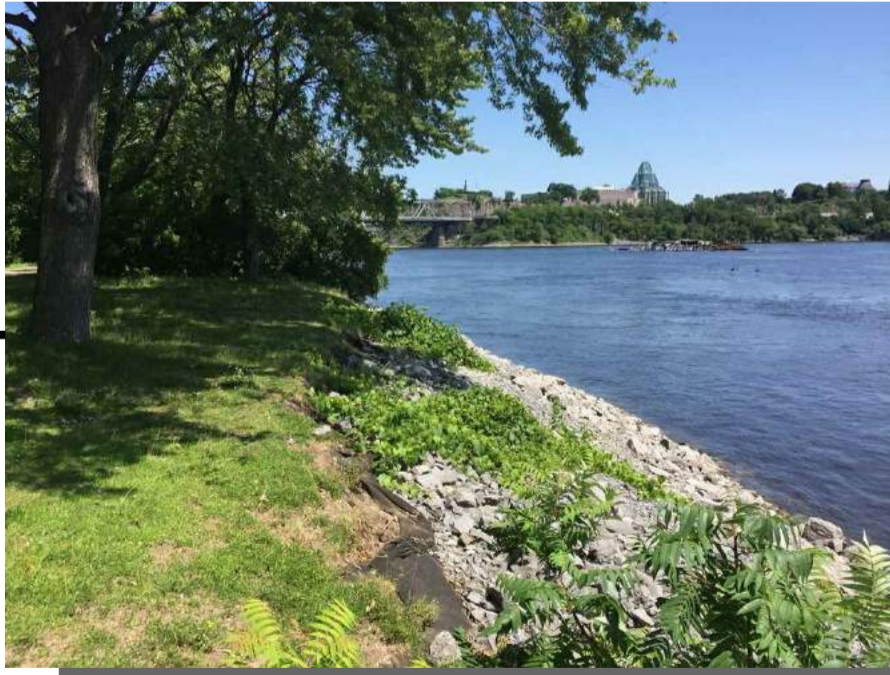
EXISTING SLOPE REQUIRING VEGETATION REMOVAL AND RIP RAP TOP UP / PENTE EXISTANTE NÉCESSITANT L'ENLEVEMENT DE LA VÉGÉTATION ET L'ENROCHEMENT ADDITIONNEL
