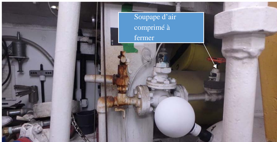
Photo no. 8 : soupape d'arrêt, avant la soupape de réduction de pression d'air de démarrage
