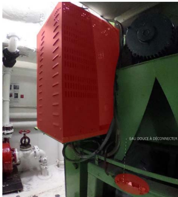
Figure 18: Humidificateur et son tuyau d'alimentation
