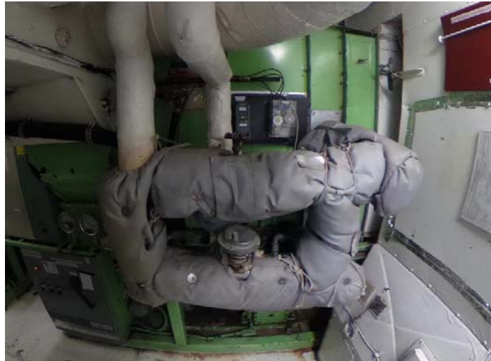
Figure 17: Vue de la tuyauterie de vapeur sur l'unité bâbord
