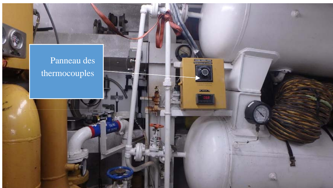
Photo no. 42 : panneau de jauges et thermomètres sur rambarde intérieure
