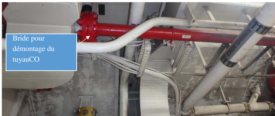
Photo no. 31 : CO2 démontage de la bride, près cloison 97
