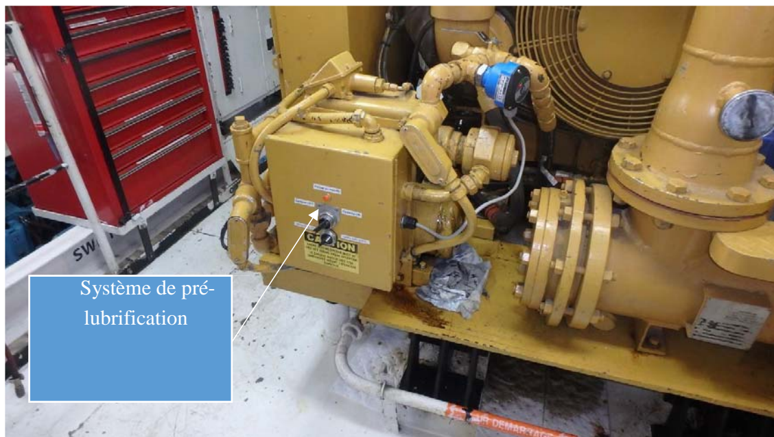
Photo no. 41 : système pré-lubrification à récupérer
