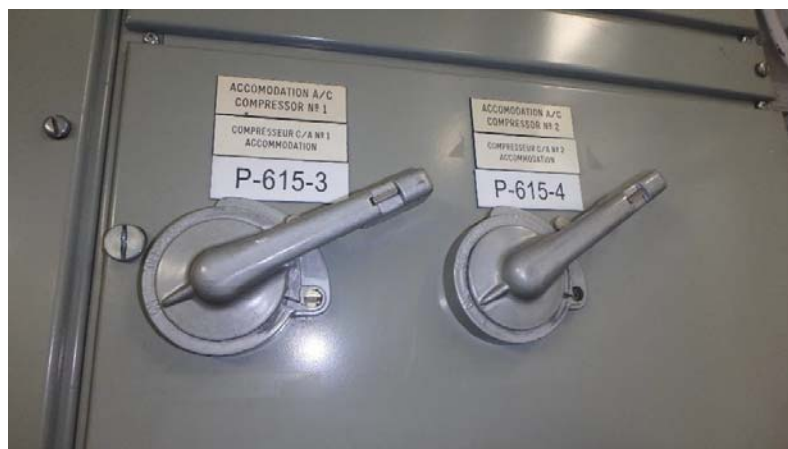
Figure 2: Disjoncteurs des compresseurs
