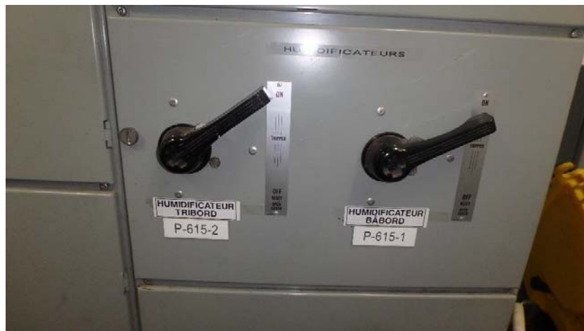
Figure 1 : Disjoncteurs des humidificateurs
