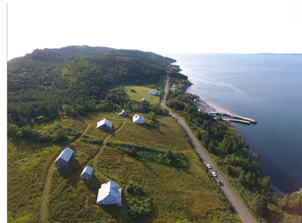
PHOTO 7 - VUE D'ENSEMBLE DU TERRAIN EXISTANT
