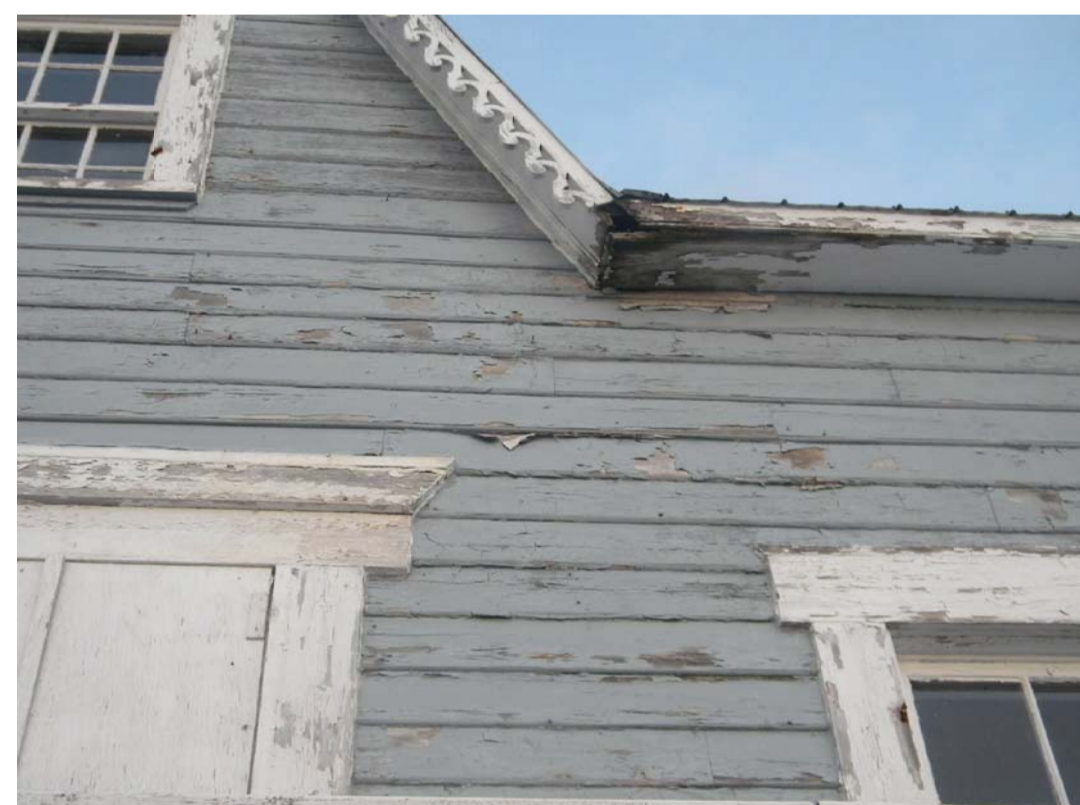
PHOTO 5 - FASCIA ET SOFFITE AVANT EXISTANT
