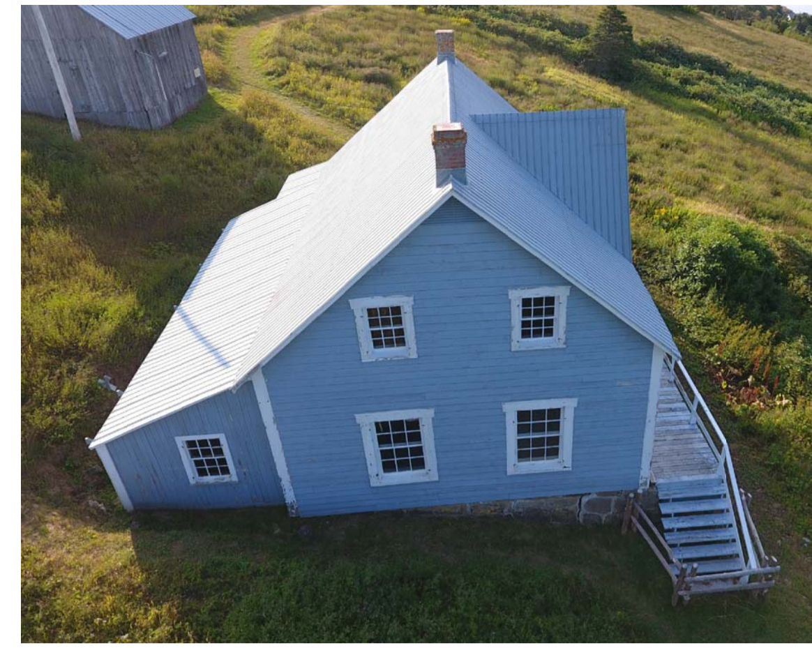
ÉLÉVATION GAUCHE EXISTANT - PHOTO
