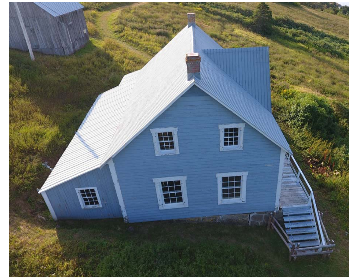
ÉLÉVATION GAUCHE EXISTANT - PHOTO
