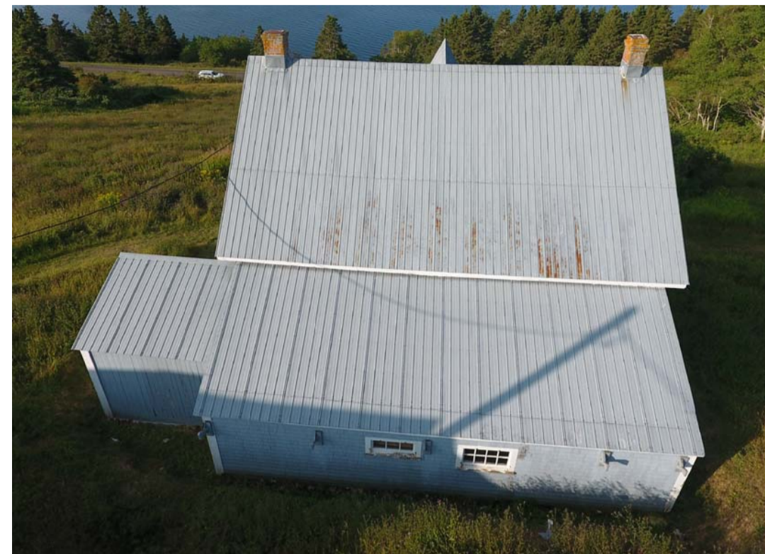
ÉLÉVATION ARRIÈRE EXISTANT - PHOTO ECH: AUCUNE
