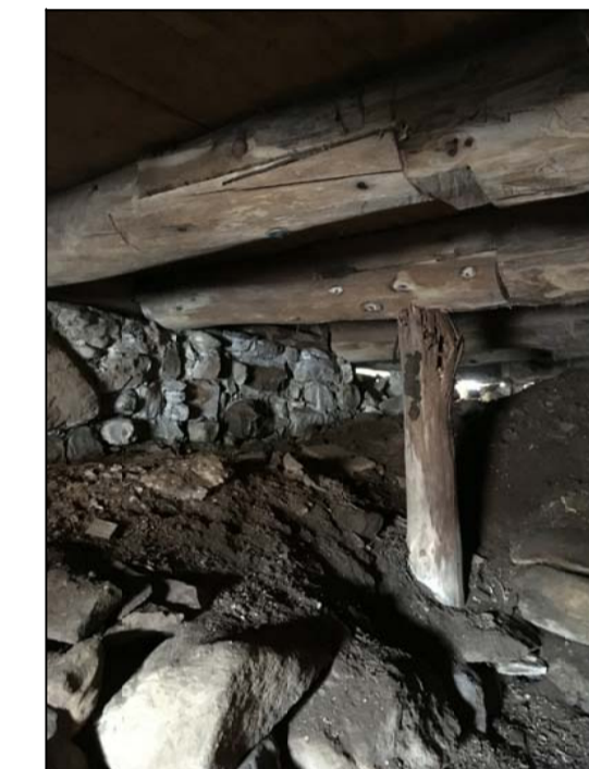
PHOTO 2 : SUPPORT DES POUTRES EXISTANTES
