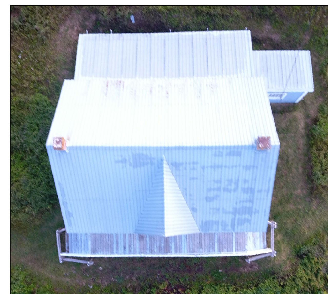
PHOTO 1 - VUE DU TOIT EXISTANT
