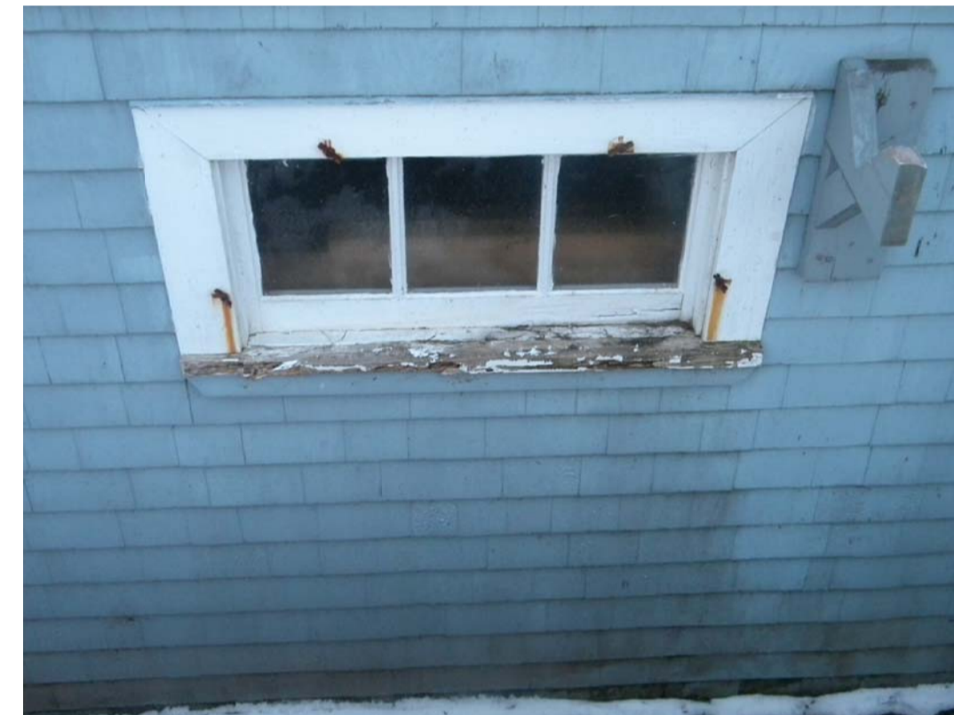
PHOTO 4 - ALLÈGE DE FENÊTRE EXISTANTE
