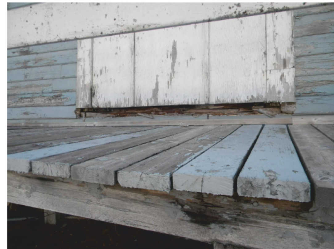
PHOTO 3 - EXISTING DOOR STEP
