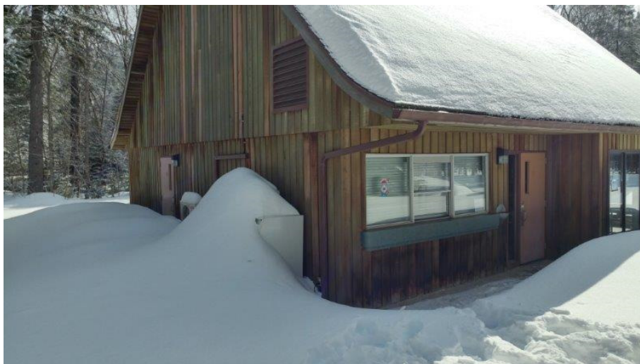
Photo 1 : Vue partielle de l'extérieur du bâtiment, partie avant.
