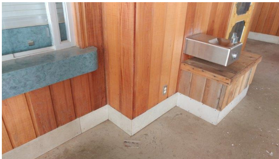
Photo 3 : Vue de deux types de panneaux de fibrociment ne contenant pas d'amiante (échantillons PM-Mur-PFC – 01 et PM-Mur-PFC – 04).
