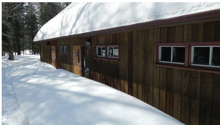
Photo 2 : Vue partielle de l'extérieur du bâtiment, partie arrière.
