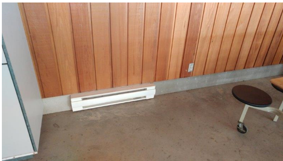
Photo 4 : Vue de deux types de panneaux de fibrociment ne contenant pas d'amiante (échantillons PM-Mur-PFC – 01 et PM-Mur-PFC – 02).
