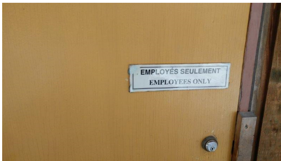
Photo 8 : Vue de la porte de bois du local mécanique où a été prélevé l'échantillon composé de peinture jaune avec sous-couche rosée pour l'analyse de la teneur en plomb totale (échantillon PM-EXT-PEINT-A).
