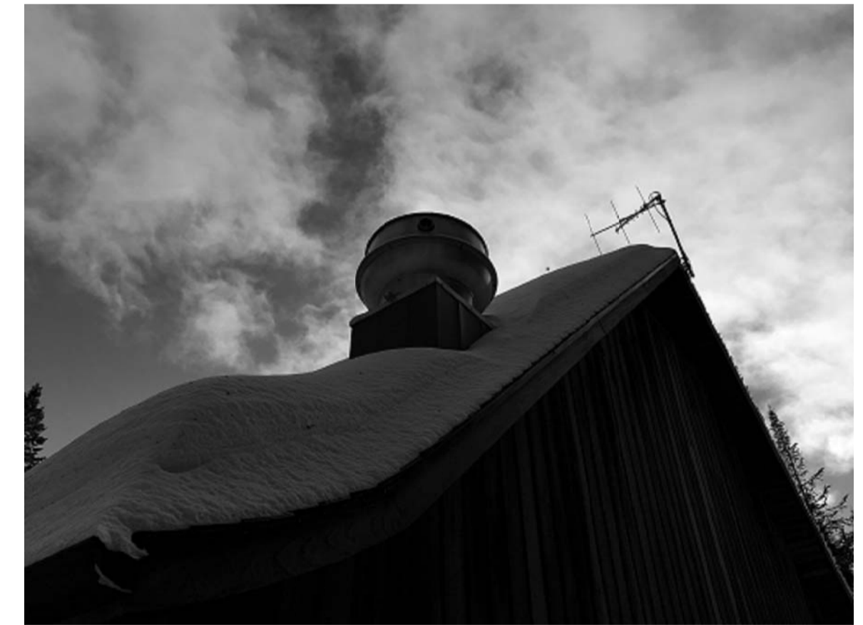
PHOTO B – VENTILATEUR 1-E ÉCHELLE : AUCUNE
