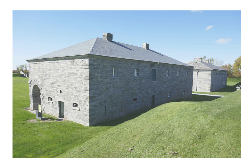
P7 CORPS DE GARDE COIN NORD-EST SANS ÉCHELLE - P1066660
