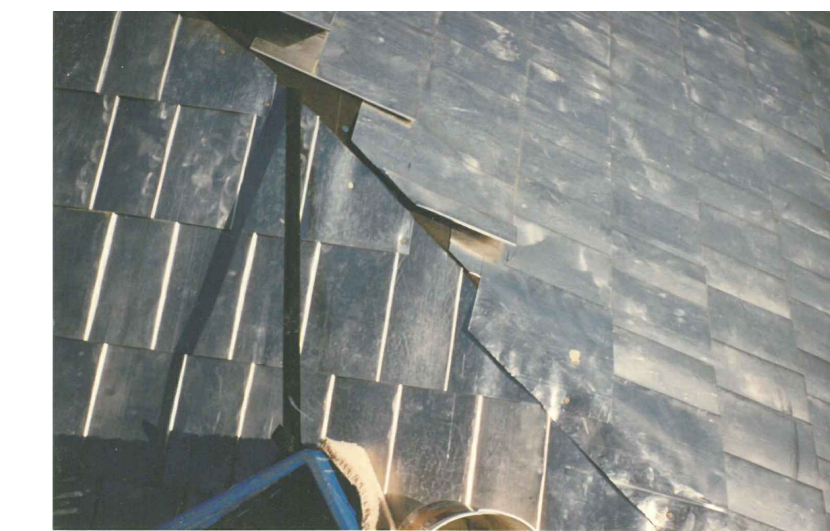
P5 MAGASIN NORD - ASSEMBLAGE COIN TYP. EXTRAIT DU VOLUME 4 - 23 AVRIL 1991 SANS ECHELLE - Toiture_1989_4
