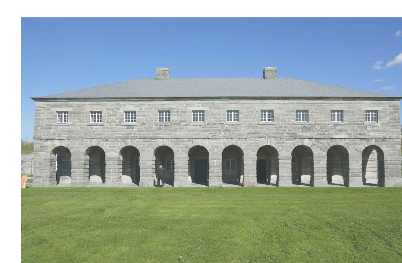
P9 CORPS DE GARDE FAÇADE SUD SANS ÉCHELLE - P1066787
