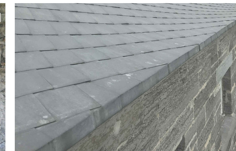
P5 CORPS DE GARDE CONDITION DU DÉBORD DE TOITURE TYP. SANS ÉCHELLE - MG_1358
