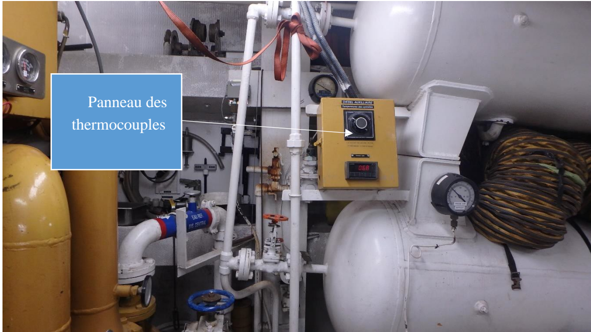
Photo no. 43 : panneau indicateur des températures des gaz d'échappement
