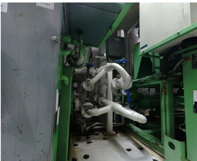
Figure 16: Vue de la connexion des tuyaux d'eau de refroidissement aux unités HVAC
