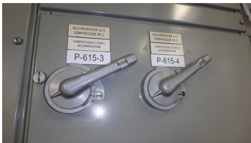
Figure 2: Disjoncteurs des compresseurs
