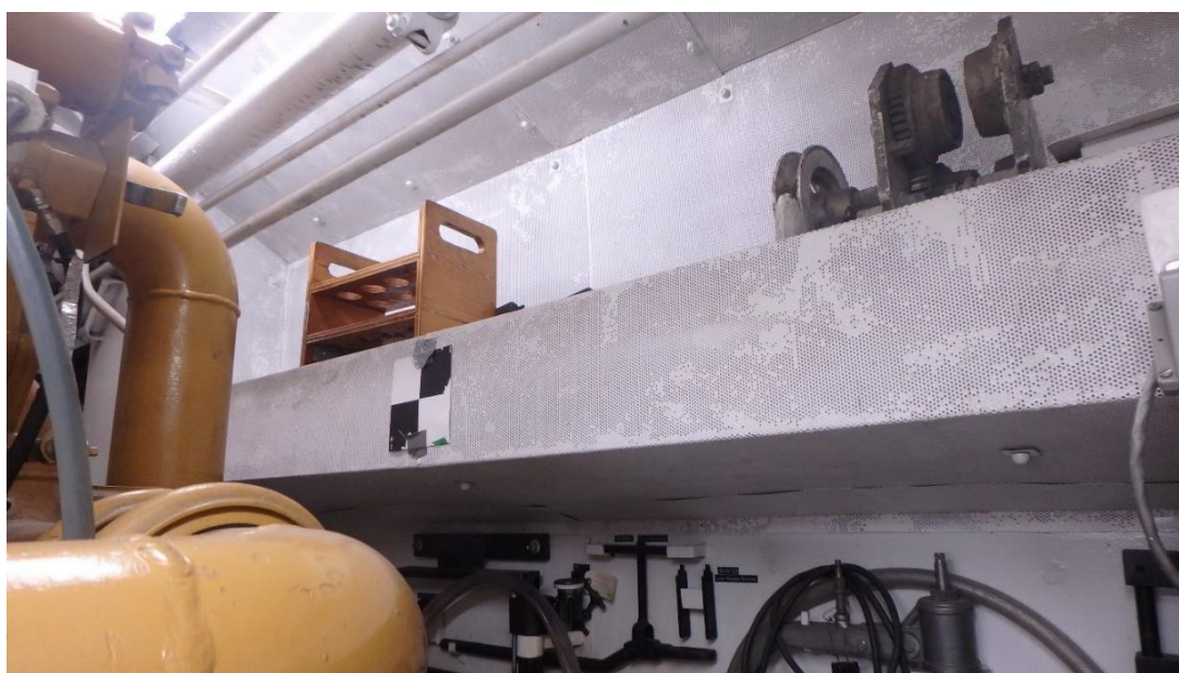
Photo no. 2 : isolation thermique + tôle de protection à enlever
