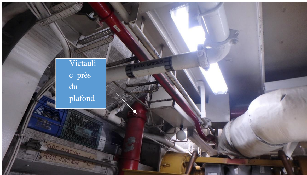
Photo no. 25 : tuyau 200mm pour canons à mousse, bordé tribord, regardant vers l'arrière
