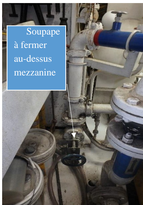
Photo no. 13 : refoulement d'eau de mer, en avant du moteur au pont mezzanine
