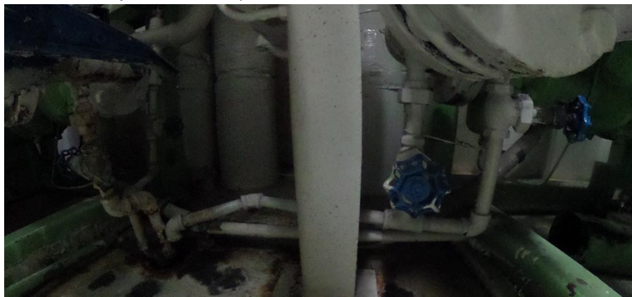
Figure 22: Vue des tuyaux de vidange de l'eau douce de refroidissement
