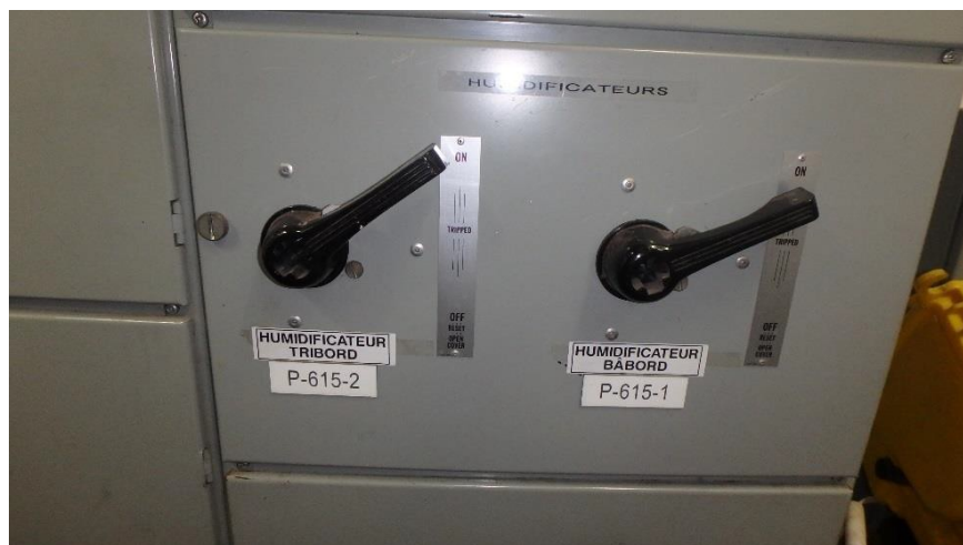
Figure 1 : Disjoncteurs des humidificateurs
