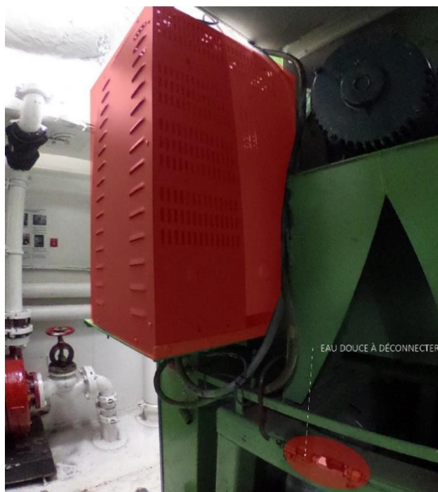
Figure 18: Humidificateur et son tuyau d'alimentation
