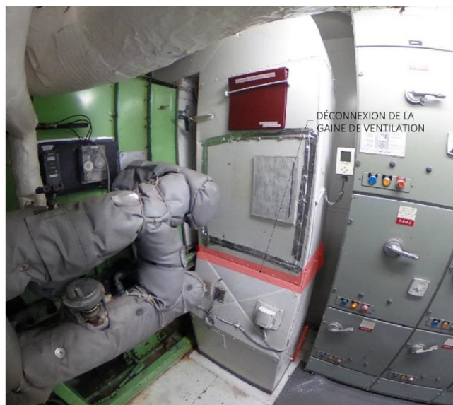
Figure 5: Vue de la gaine de ventilation bâbord
