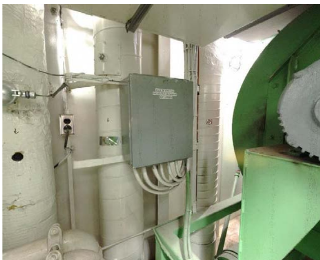
Figure 8: Boîte de jonction à déplacer
