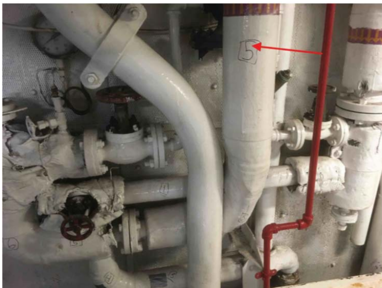
5 Tuvauterie Vapeur (alimentation) — Rectiligne — Canevas et magnésie — 6 po. — 36 m. lin. Salle des moteurs — 0 — N/A Chantal Souillard 2017-11-13 10:46
