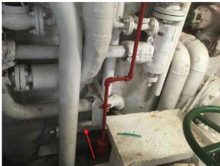
1 Tuvauterie Vapeur (alimentation) — Rectiligne — Canevas et magnésie — 2-3 po. — Chantal Souliard 2017-11-13 10:37
