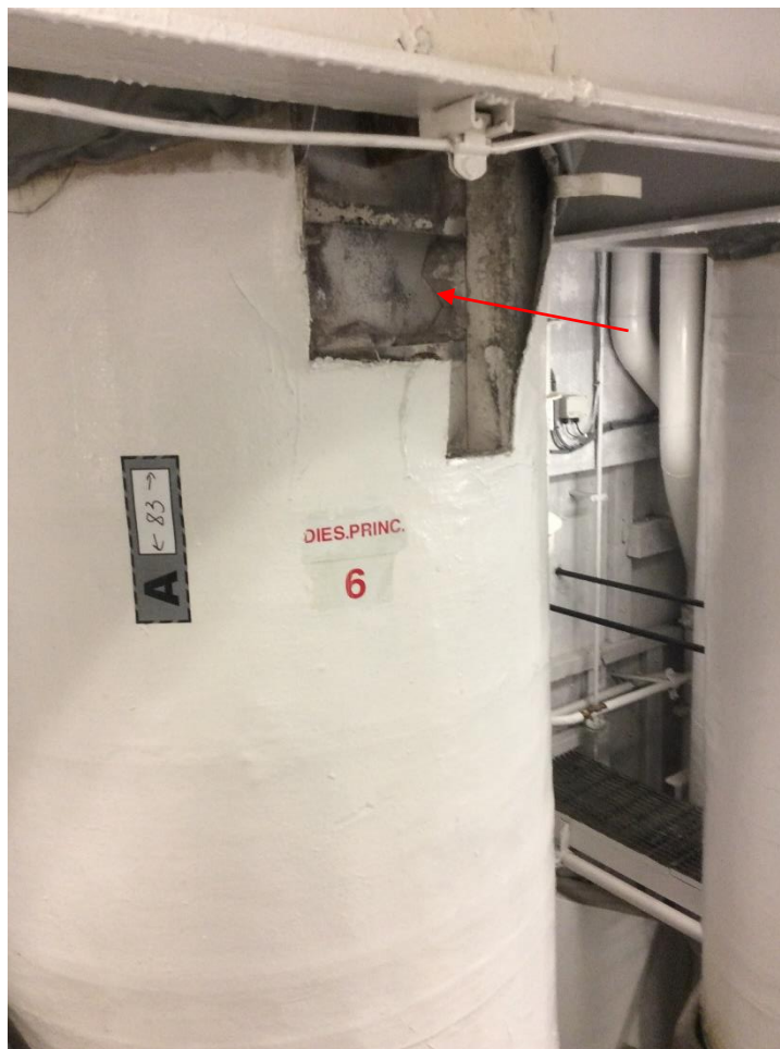
Photo 3. Calorifuge endommagé sur le système d'échappement du moteur DP6, dans la salle des machines, au niveau du pont supérieur.
