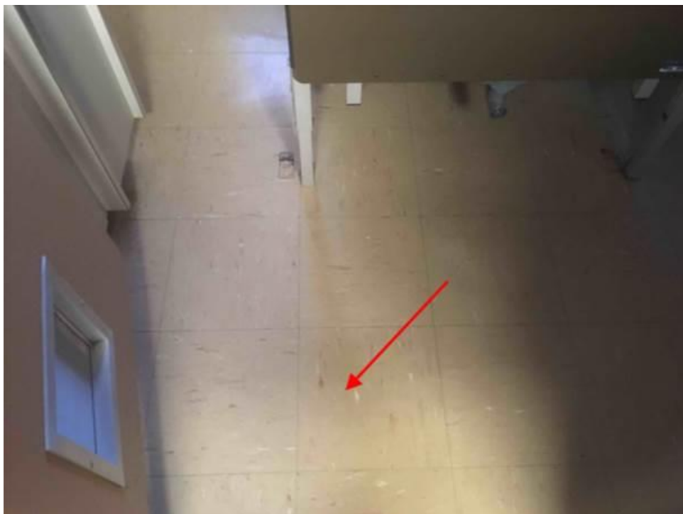
Photo 1. Tuile de plancher beige contenant de l'amiante, située à l'infirmerie du pont supérieur.
