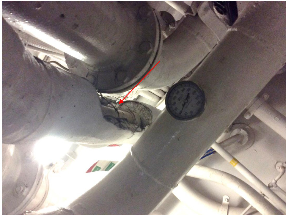
Photo 2. Calorifuge endommagé sur une conduite de 6 po, dans la salle des machines arrière, à tribord du moteur DP6.
