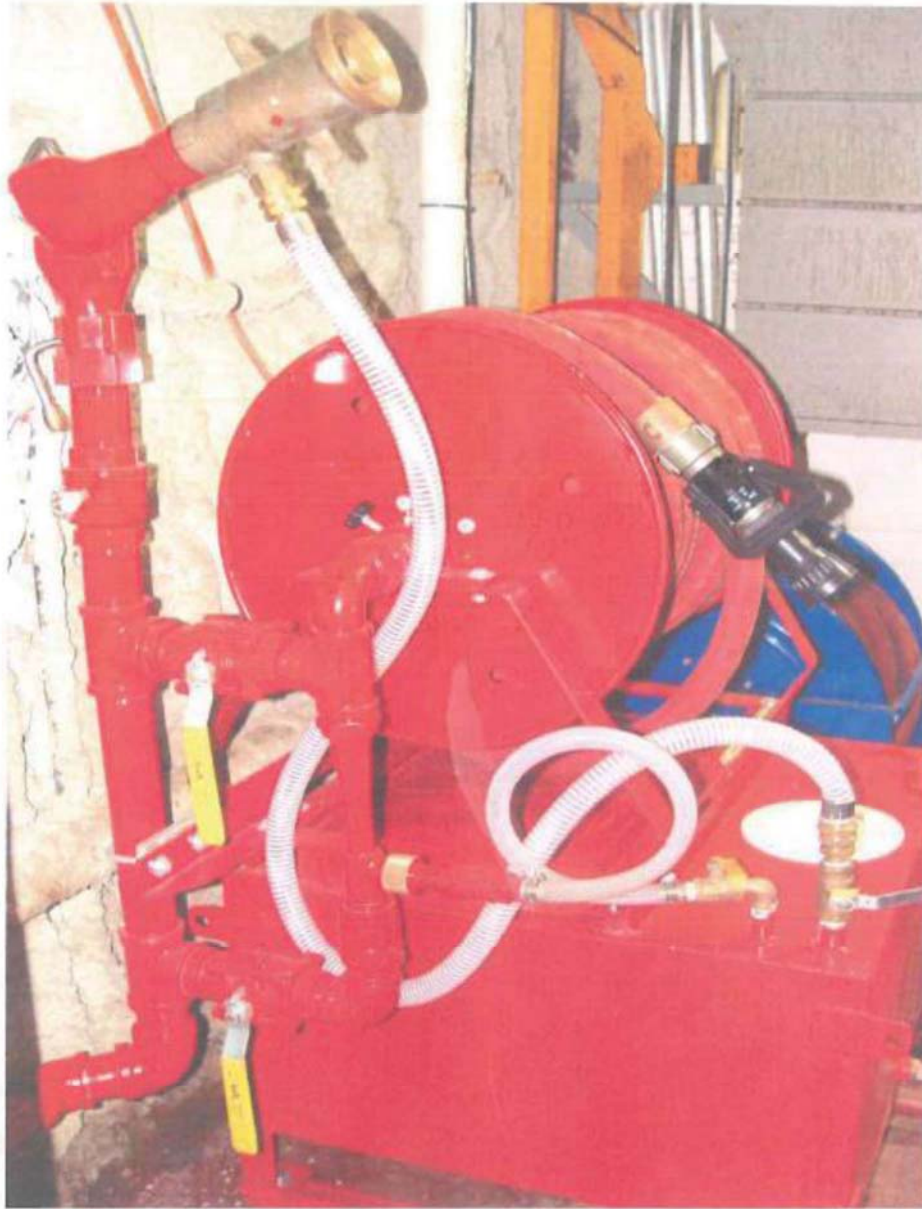
Système d'extinction hangar d'hélicoptère Minuteman II model 150
