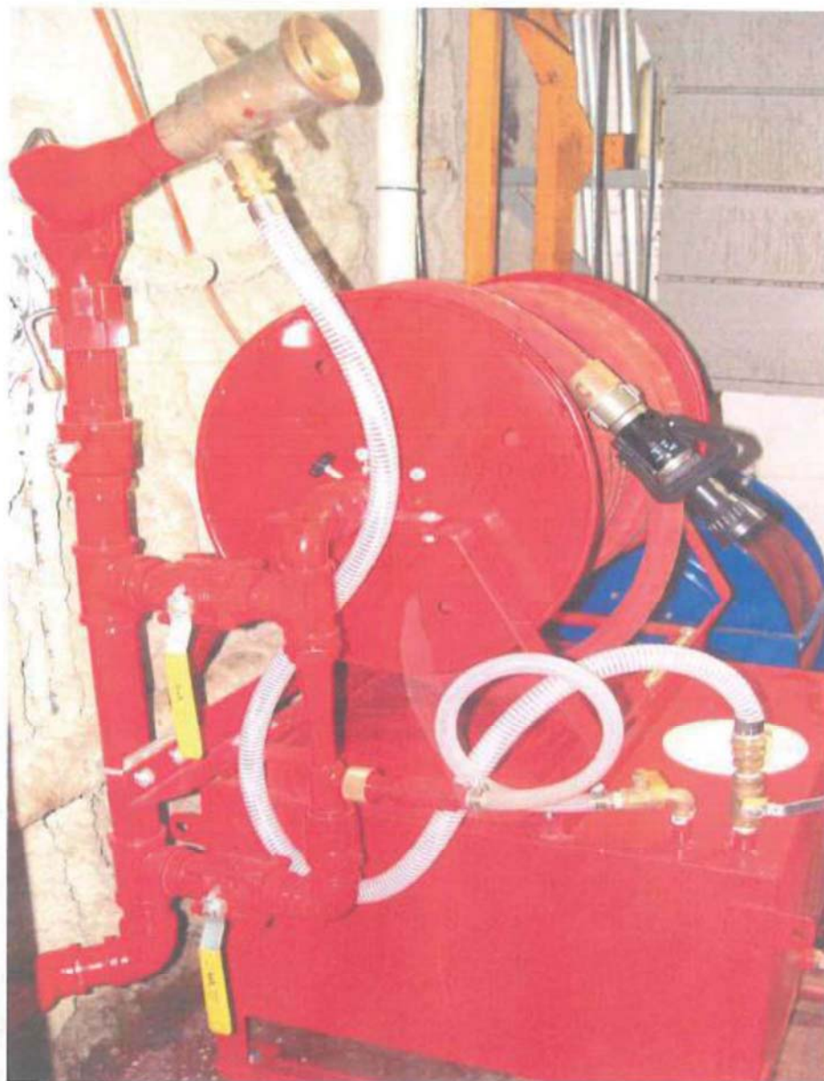
Système d'extinction hangar d'hélicoptère Minuteman II model 150
