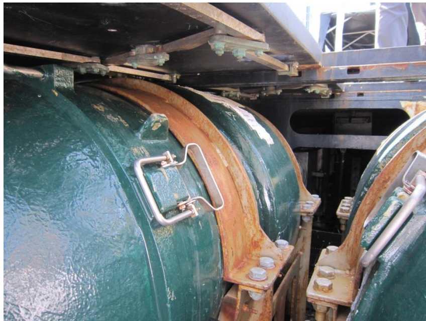
Figure 2 : Berceau et ancrages de plaque d'acier du RSPE
