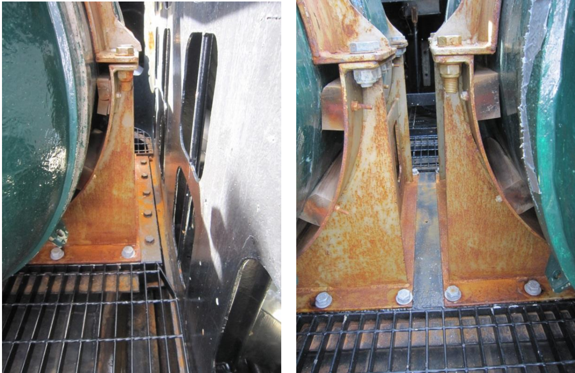
Figure 2 : Berceau et ancrages de plaque d'acier du RSPE
