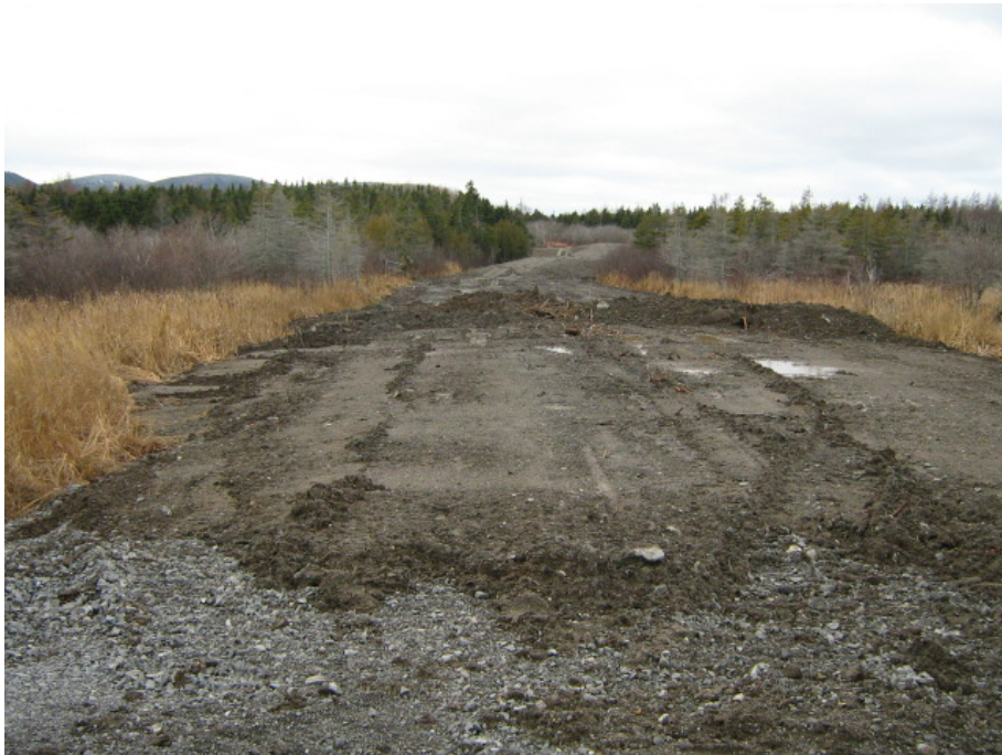
Vue vers l'ouest – Remblai à l'extrémité nord du tronçon no 1
