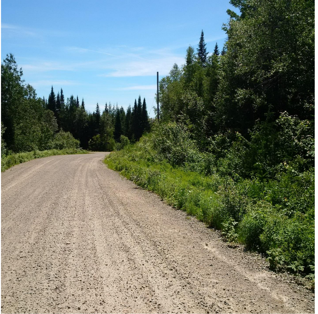
Projet : Contrôle de végétation en bordure de route
