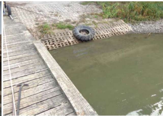
Figure 2 Vue de la rampe à réhabiliter
