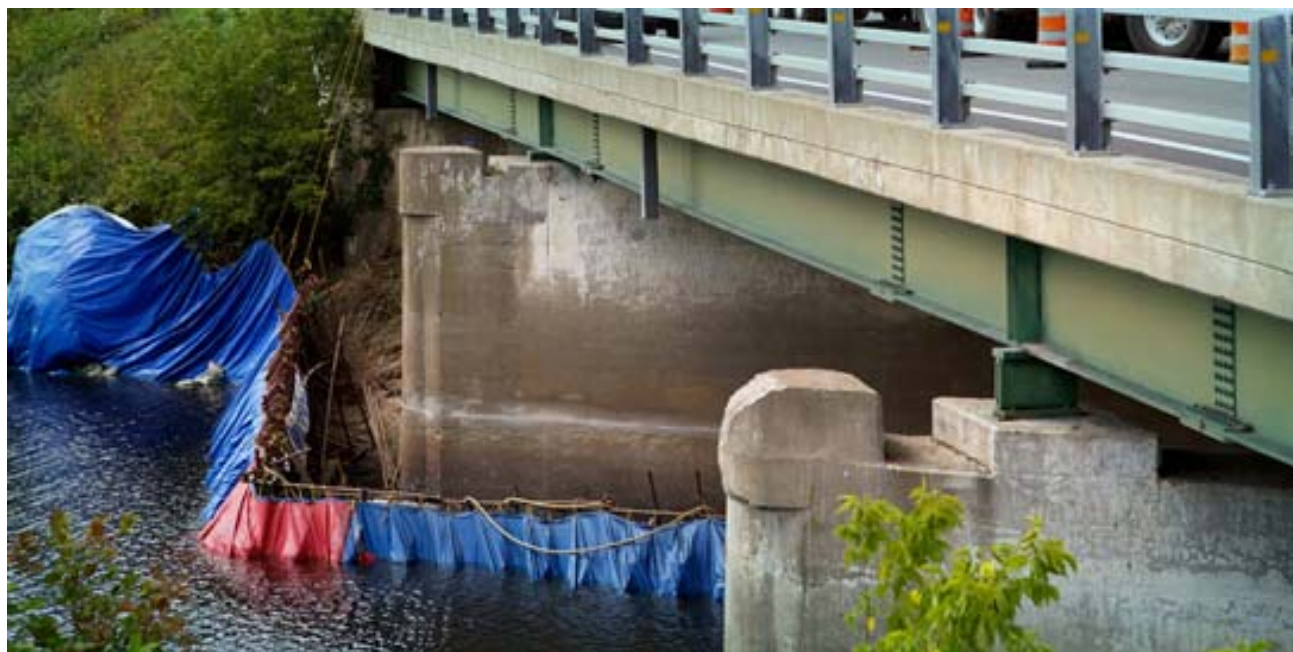
Figure 2 Utilisation d'une structure PORTADAM® en batardeau
