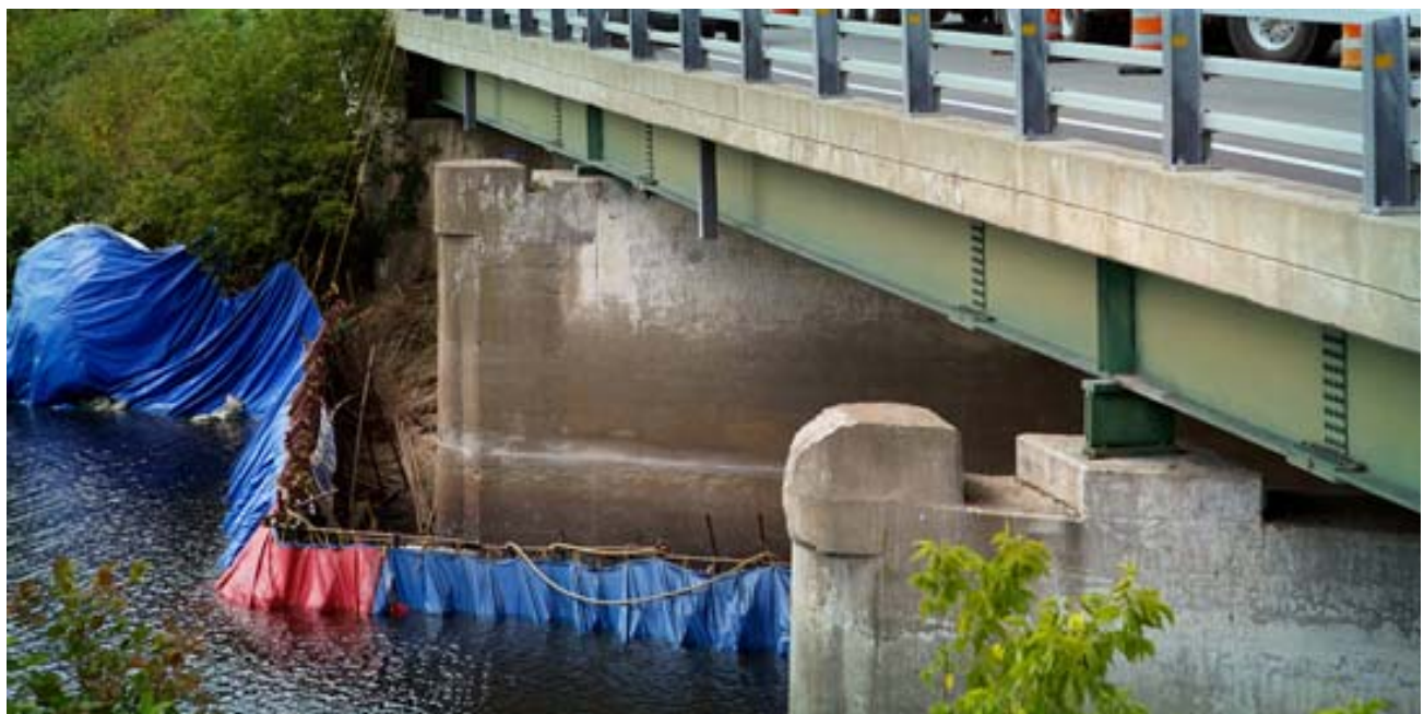
Figure 2 Utilisation d'une structure PORTADAM® en batardeau
