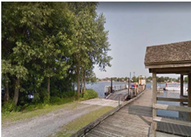
Figure 1 Vue d'ensemble du secteur du quai du débarcadère
