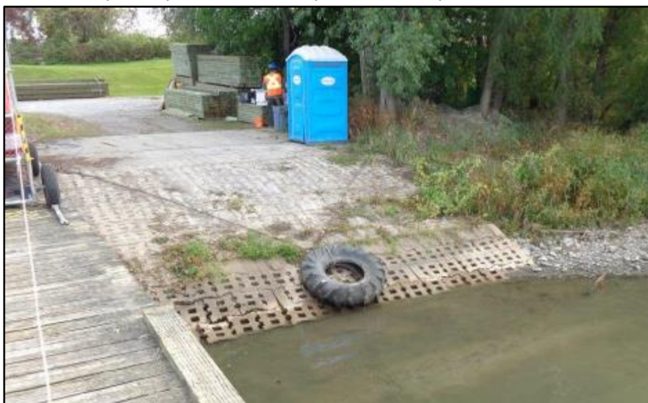
Figure 1 : Débarcadère de la barge au quai Ouest. Les excavations débuteront dans la zone en gravier et feront disparaître l'actuelle dalle de béton et le tapis anti-parafouille. (SNC-Lavalin 2016)
