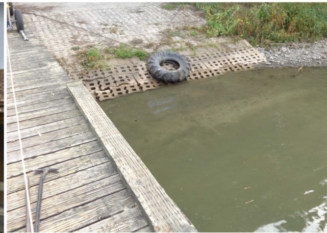
Figure 2 Vue de la rampe à réhabiliter
