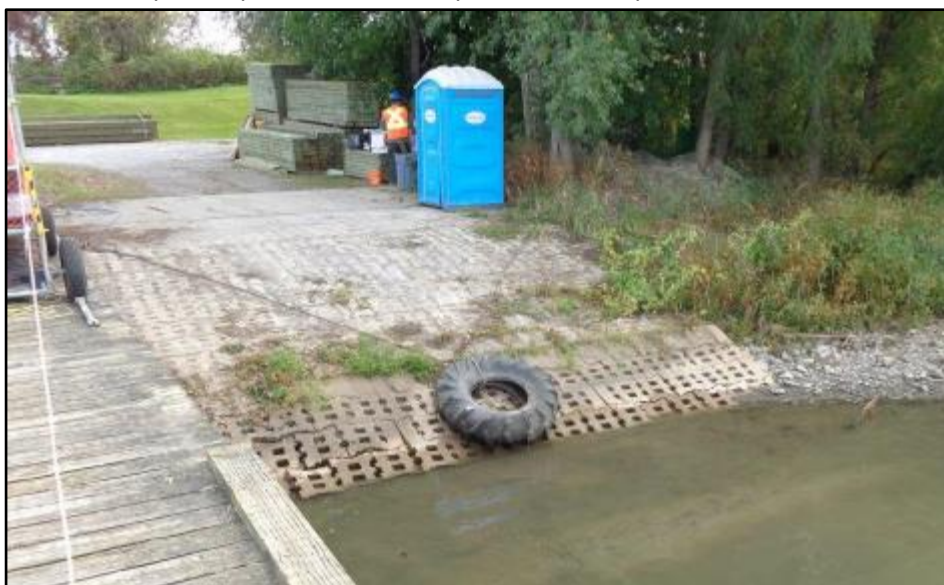
Figure 1 : Débarcadère de la barge au quai Ouest. Les excavations débuteront dans la zone en gravier et feront disparaître l'actuelle dalle de béton et le tapis anti-parafouille. (SNC-Lavalin 2016)
