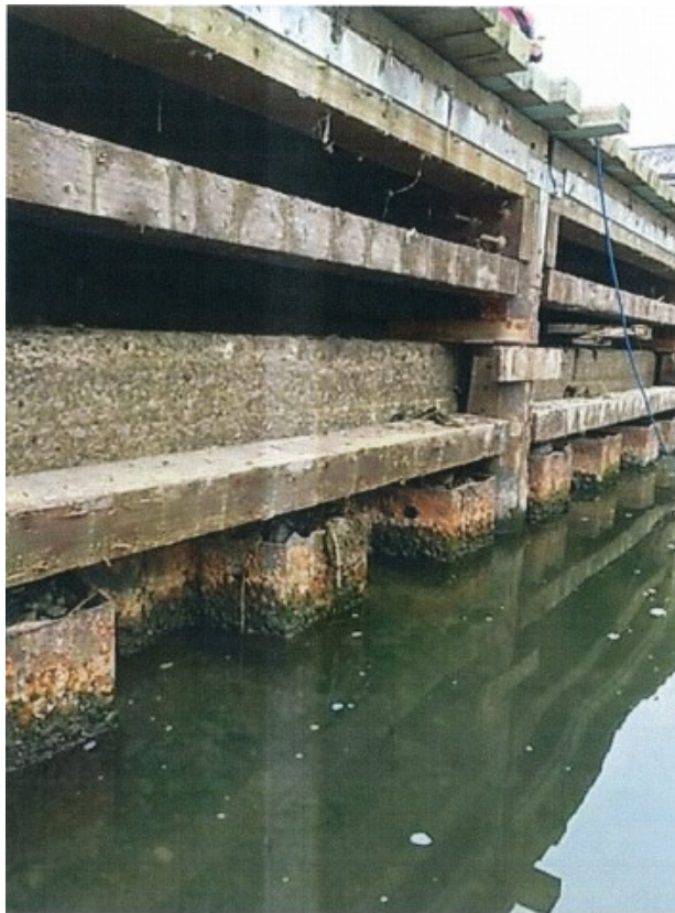
Figure 2: Palplanche sous le quai
