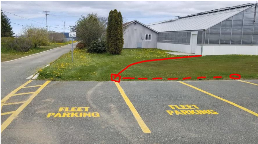
Excavation du conduit souterrain : zone gazonnée
