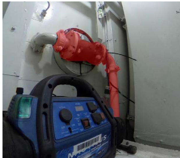
Figure 6: Tuyau incendie à démonter
