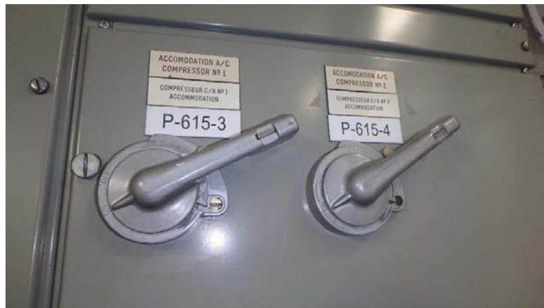
Figure 2: Disjoncteurs des compresseurs
