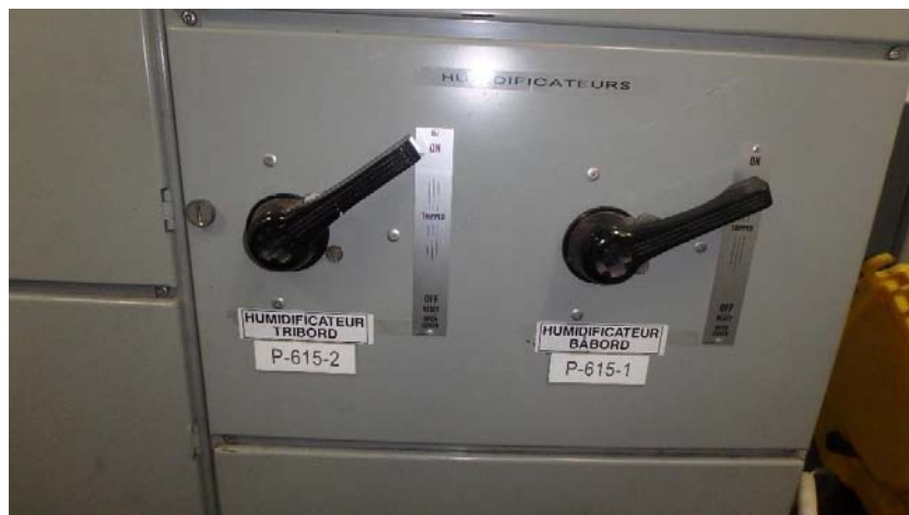
Figure 1 : Disjoncteurs des humidificateurs
