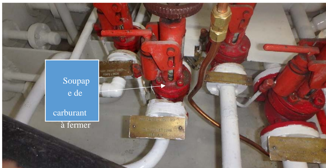
Photo no. 4 : soupape de refoulement à fermeture rapide vers groupe électrogène
