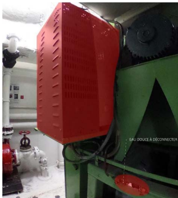
Figure 18: Humidificateur et son tuyau d'alimentation
