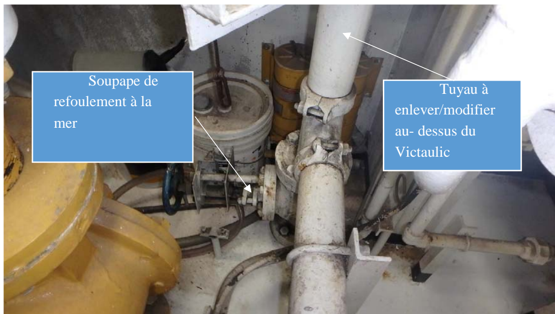
Photo no. 19 : soupape de refoulement à la mer, avec tuyau à enlever
