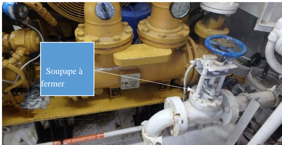
Photo no. 10 : soupape de refoulement d'eau de refroidissement au système de refroidissement central
