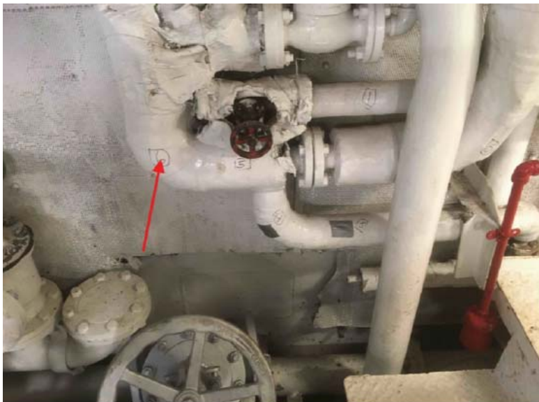
6 Tuvauterie Vapeur (alimentation) — Irrégulière — Canevas et magnésie — 6 po. — 18 unité Salle des moteurs 0 — N/A Chantal Souillard 2017-11-13 10:48
