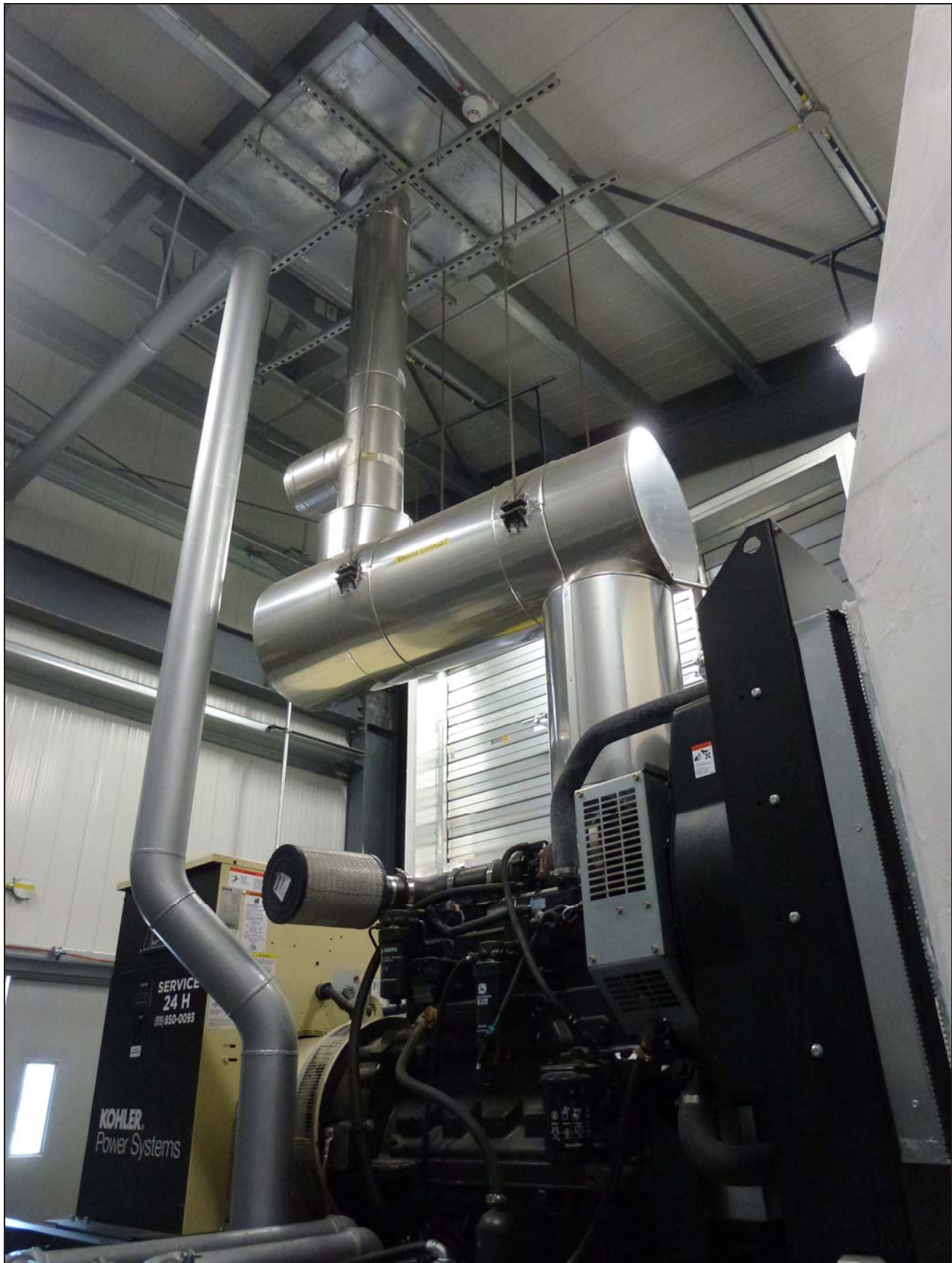
Figure 6 : Tuyauterie du système d'échappement.
