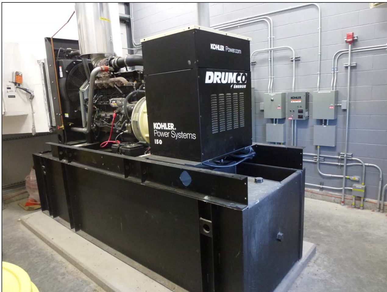
Figure 3 : Groupe électrogène diésel au barrage Latchford.
