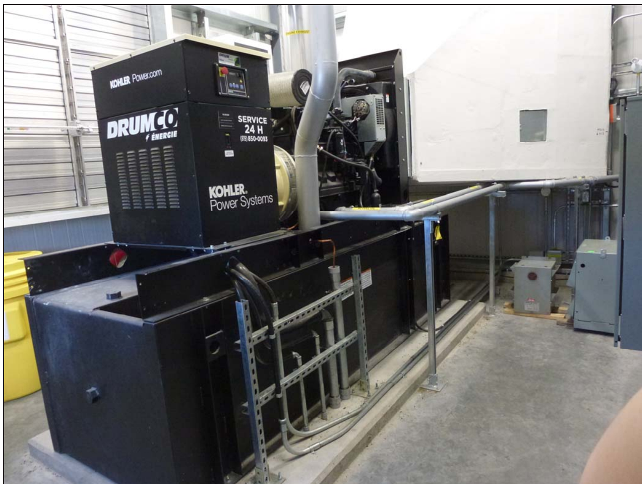
Figure 5 : Groupe électrogène diesel au barrage Latchford
