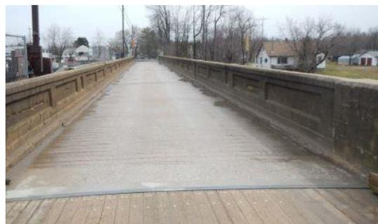
barrières intégrales d'une hauteur de 1,219 m ont été coulées en place de chaque côté du pont. Le pont fixe ne comprend aucun trottoir. Le tablier du pont est simplement soutenu par les piles du barrage, qui sont faites de béton de masse non armé d'une épaisseur de 1,83 m et qui reposent sur le substrat rocheux.
