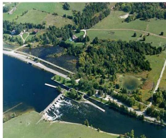
Portée : Le remplacement de la structure existante du barrage en entier, y compris le tablier, les piles, les culées, les poutrelles de vannage, les déversoirs, les musoirs en aval et en amont et les dalles d'approche est et ouest.
