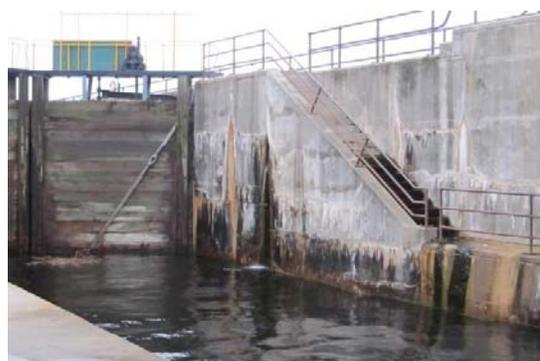
Portée : La réparation des fuites du mur commun de la pile 1 du barrage principal et de l'écluse est, et le remplacement de l'escalier inférieur du côté est de l'écluse. La réparation des fissures dans le béton, et des zones d'effritement et de délamination des murs d'approche en amont et en aval. Prolongement des murs d'accès d'entrée inférieurs et construction d'un système de barrières à dissipation d'énergie.
