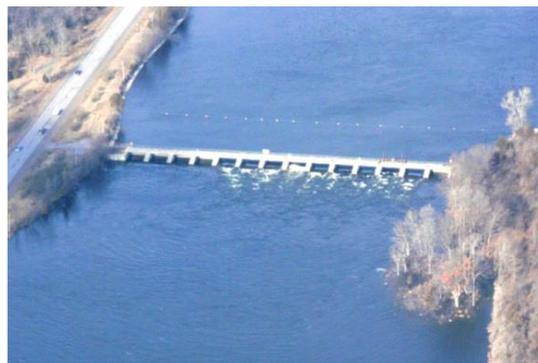
Portée : La démolition et le remplacement de la structure existante du barrage en entier, la restauration avec la construction d'une mesure d'atténuation pour le contrôle de l'érosion et le remblayage le long de la digue pour restaurer le profil d'origine.
