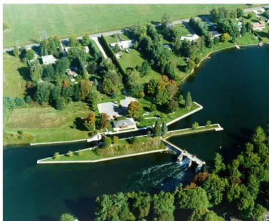
La cloison sud est attachée à la berge et la cloison nord est attachée au mur d'écluse dans la digue de terre entre le barrage et l'écluse. Au total, le barrage mesure environ 75 m de longueur. La hauteur du barrage est d'environ 8,1 m, contenant une profondeur de réservoir approximative de 7 m. Les poutrelles de vannage fonctionnent avec un ensemble de deux treuils à patins manuels.
