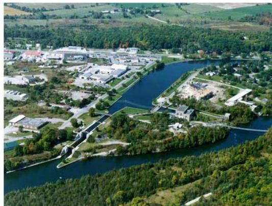
**Portée :** L'objectif principal est d'accroître la capacité du débit au barrage 10 de Ranney Falls afin de réduire le risque lié à la capacité hydraulique en apportant des modifications au tablier, aux vannes et aux seuils pour accroître la capacité; et en construisant une galerie de déviation. Options finales à déterminer après des travaux d'enquête supplémentaires et l'élaboration de la conception.
