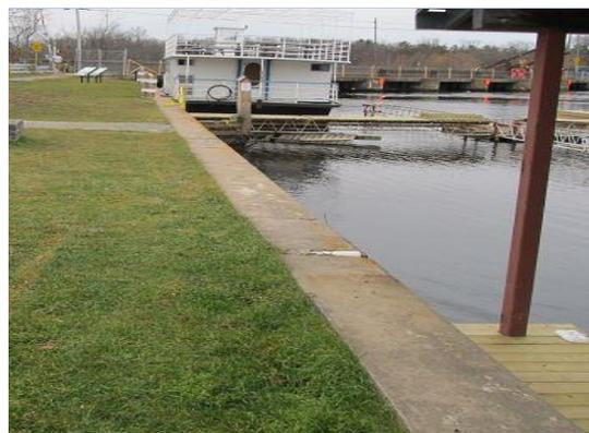
**Portée :** La réparation du béton le long de la majeure partie du mur, dans les zones d'effritement profond situées au niveau d'eau inférieur (ligne de congélation).
