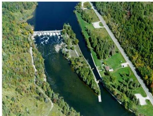
Portée : Le remplacement de la structure existante du barrage en entier, y compris le tablier, les piles, les culées, les poutrelles de vannage, les déversoirs, les musoirs en aval et en amont et les dalles d'approche est et ouest.
