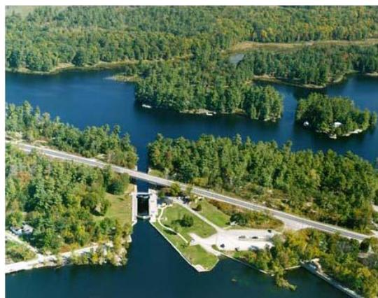
Portée : La restauration de la structure existante du barrage en entier à l'écluse 38, sous réserve des conditions et déterminations particulières en matière de conception, y compris le tablier, les piles, les culées, les déversoirs, le musoir sud et le musoir nord.
