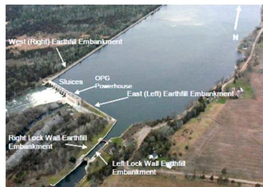
Portée : Amélioration de l'efficacité opérationnelle et des modifications visant à prévenir le débordement, réparation des seuils et piles, augmentation de l'élévation des murs d'approche ouest et est.
