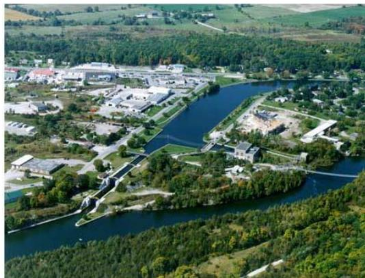
Portée : L'objectif principal est d'accroître la capacité du débit au barrage 10 de Ranney Falls afin de réduire le risque lié à la capacité hydraulique en apportant des modifications au tablier, aux vannes et aux seuils pour accroître la capacité; et en construisant une galerie de déviation. Options finales à déterminer après des travaux d'enquête supplémentaires et l'élaboration de la conception.
