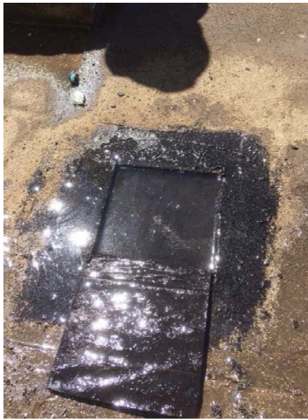
Accumulation d'eau sous la membrane monolithique
