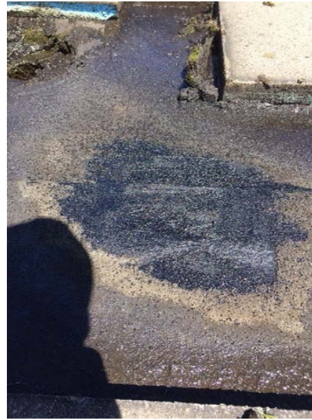
Accumulation d'eau sous la membrane monolithique
