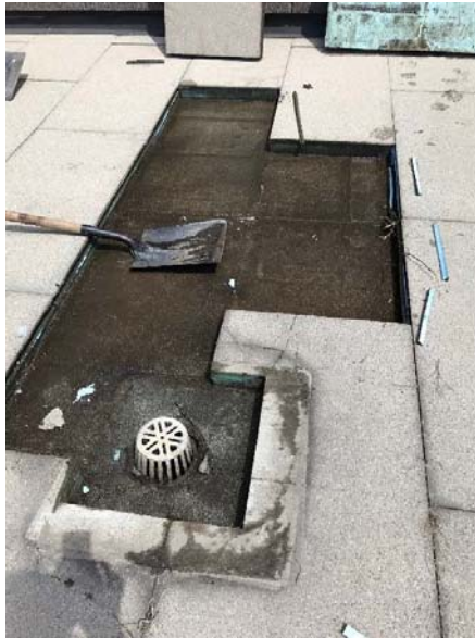
Enlèvement des panneaux isolés
