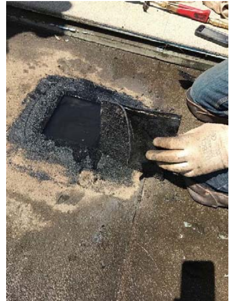
Infiltration d'eau sous la membrane monolithique
