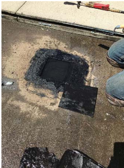
Infiltration d'eau sous la membrane monolithique
