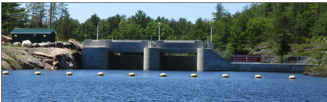
Figure 7 – Barrage Big Chaudière Nord, côté en amont. Le bâtiment vert à la gauche sur la photo abrite un groupe électrogène de réserve.
