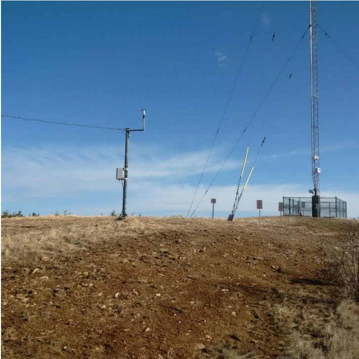
Anémomètre de la GCC, situé à gauche sur la photo. À droite, le pylône Rx à remplacer
