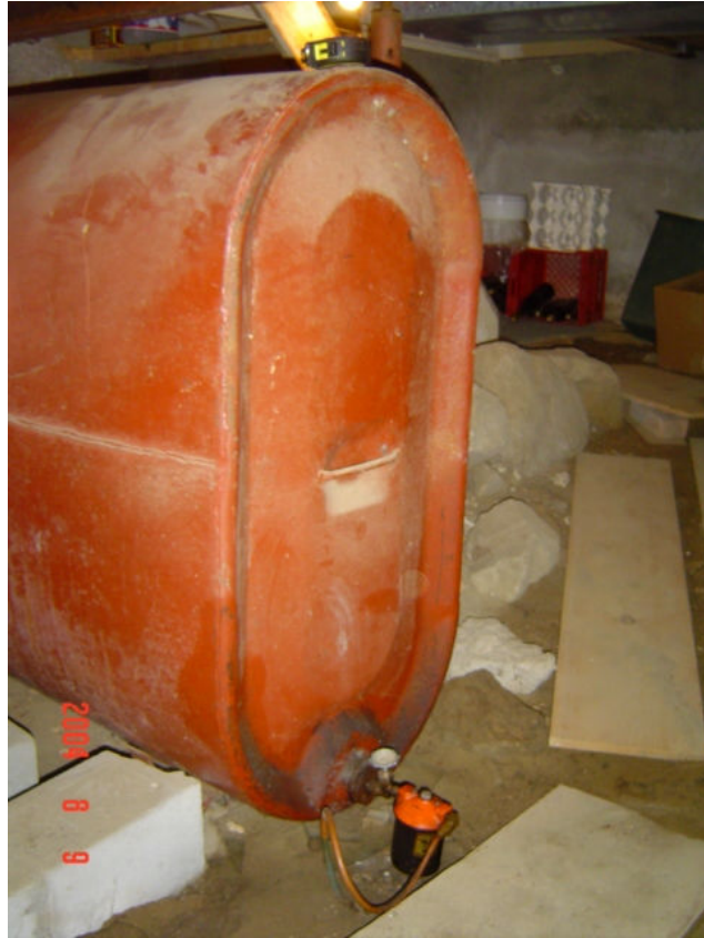
Photo 1: Vue du réservoir avec filtre. (727-01-08-2004.JPG)
