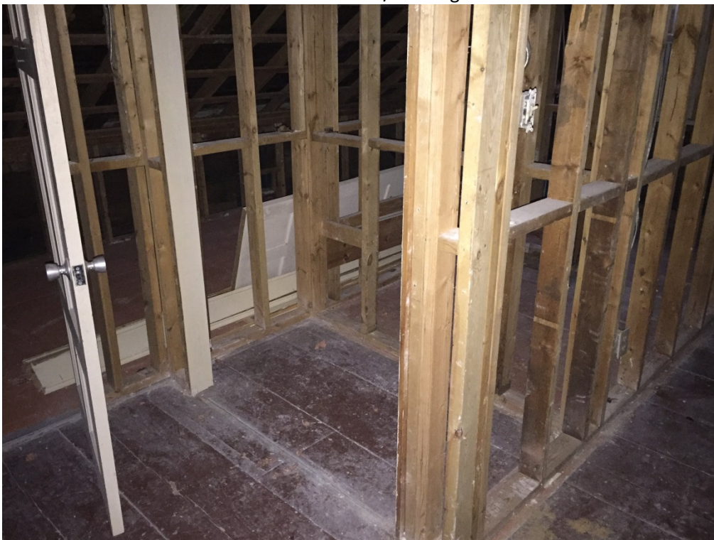
34. – First floor / 1 er étage
