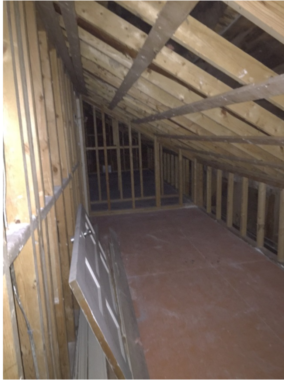
37. – First floor / 1 er étage
