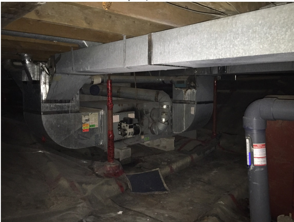
26. – Furnace crawl space / Fournaise sous-sol
