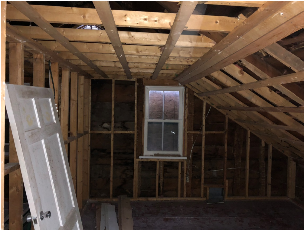
33. – First floor / 1 er étage
