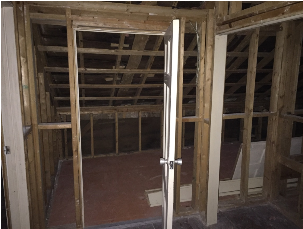
31. – First floor / 1 er étage
