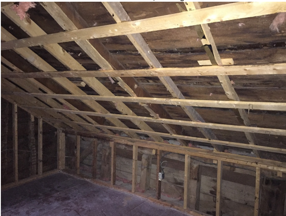
36. – First floor / 1 er étage
