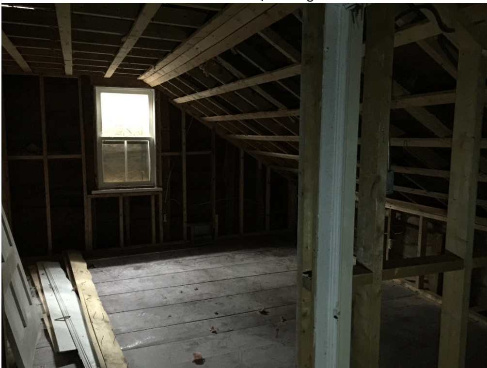
32. – First floor / 1 er étage
