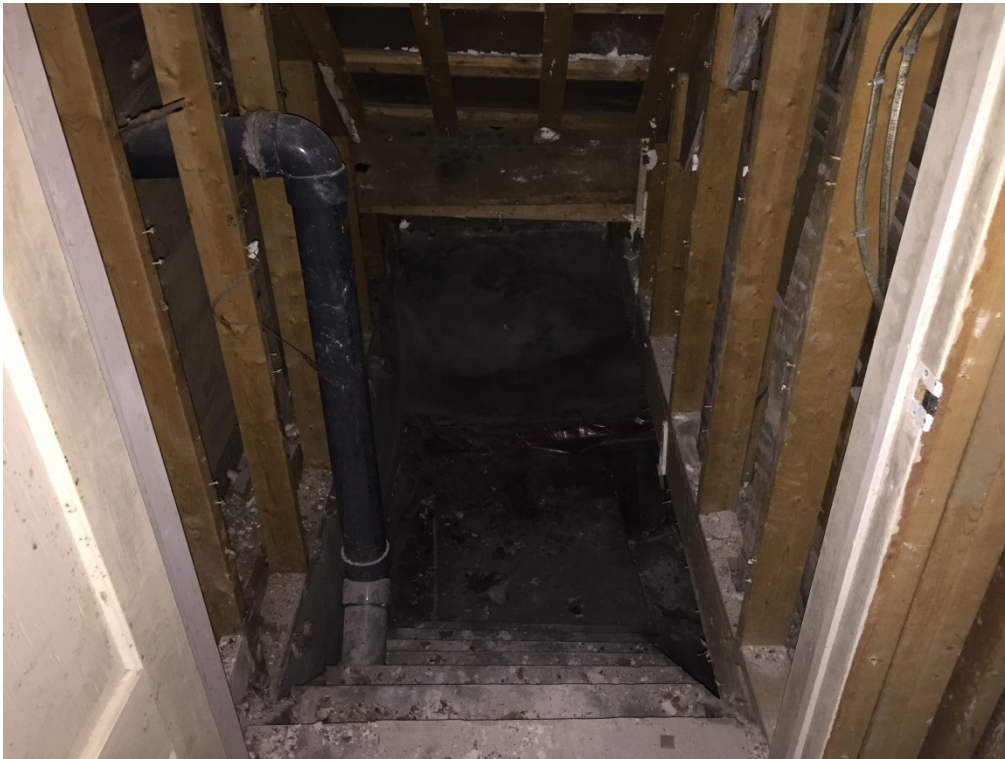
25. – Stairs crawl space / Escalier vers le sous-sol
