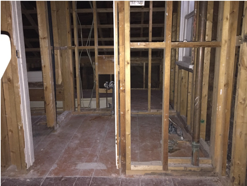
35. – First floor / 1 er étage
