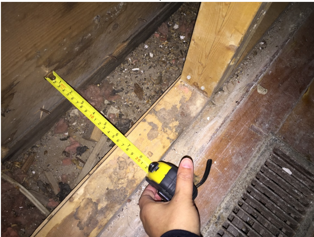
14. – Wall thickness / Épaisseur du mur
