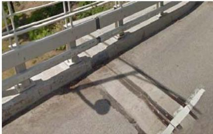
Fig. 3 : Fissure typique observée au niveau des joints d'expansion à sceller
