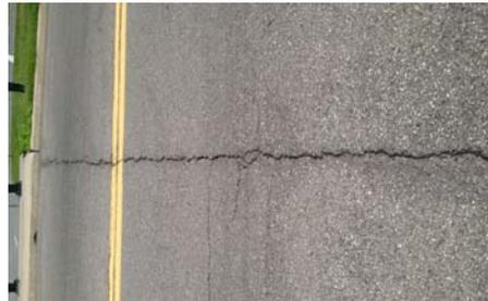
Fig. 4 : Fissures longitudinales et transversales de haute sévérité à sceller
