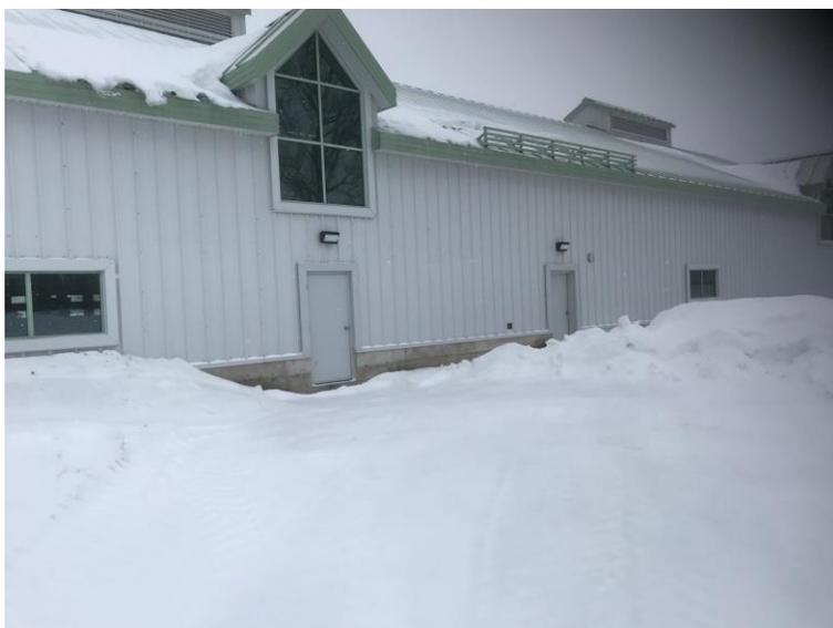
Le nouveau lecteur de carte sera installé sur le mur d'acier du côté droit des deux portes. Se référer au groupe de quincaillerie 03. Tous les conduits d'alimentation électrique devront être dissimulés derrière le revêtement métallique
