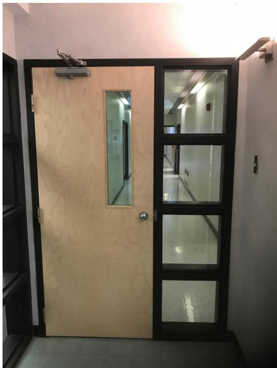
Le nouveau lecteur de carte sera installé sur le cadre à droite de la poignée. Se référer au groupe de quincaillerie 01. Tous les conduits d'alimentation électrique devront être dissimulés dans les murs. Réparer et repeinturer le mur au besoin.
