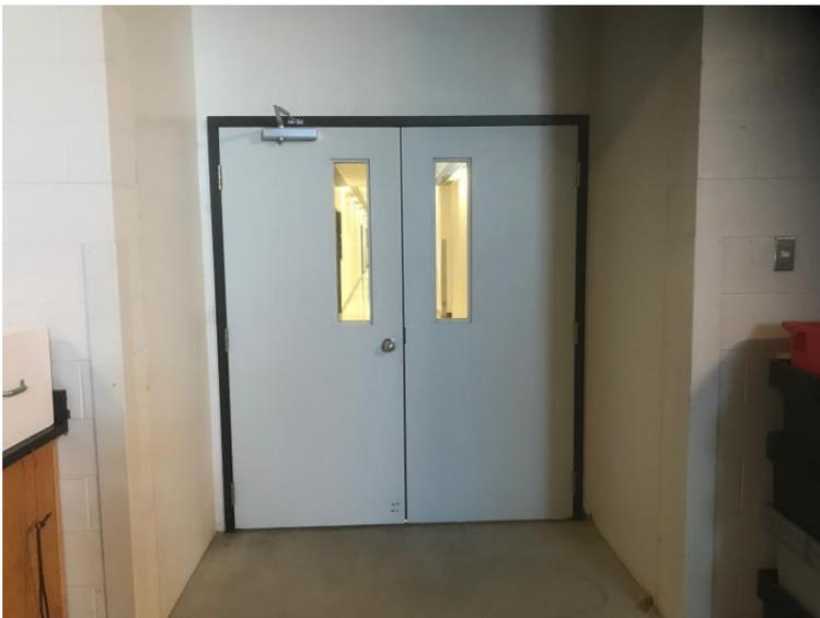
Le nouveau lecteur de carte sera installé sur le mur de gypse à droite de la porte. Se référer au groupe de quincaillerie 02. Tous les conduits d'alimentation électrique devront être dissimulés dans les murs. Réparer et repeindre les murs au besoin.
