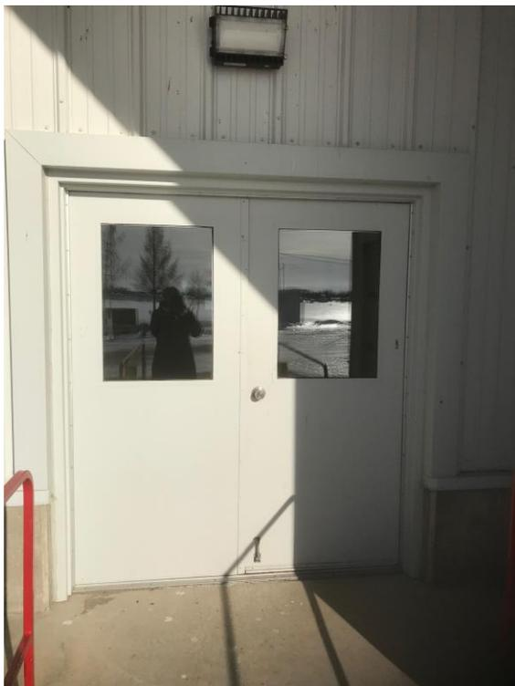
Le nouveau lecteur de carte sera installé sur le mur d'acier du côté gauche de la porte. Se référer au groupe de quincaillerie 02. Tous les conduits d'alimentation électrique devront être dissimulés derrière le revêtement métallique.
