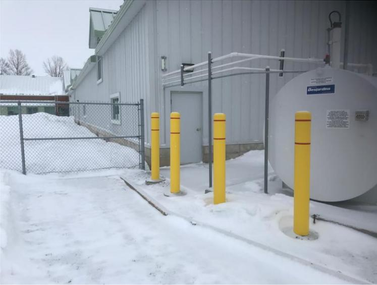
Le nouveau lecteur de carte sera installé sur le mur d'acier du côté droit de la porte. Se référer au groupe de quincaillerie 03. Tous les conduits d'alimentation électrique devront être dissimulés derrière le revêtement métallique
