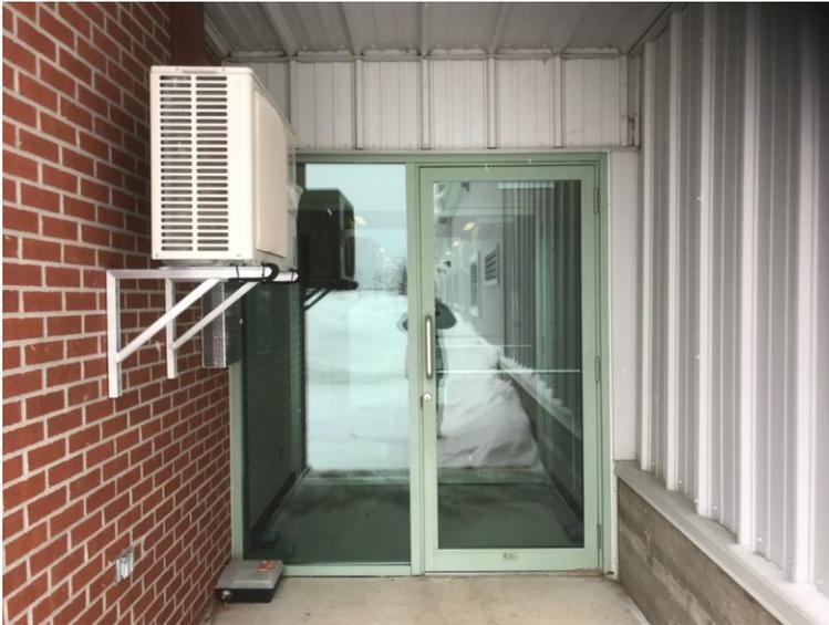
Le nouveau lecteur de carte sera installé sur le bout de mur métallique à droite de la porte. Se référer au groupe de quincaillerie 03B. Tous les conduits d'alimentation électrique devront être dissimulés derrière le revêtement métallique.
