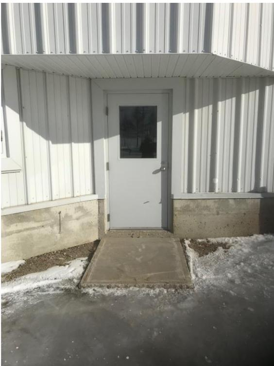
Le nouveau lecteur de carte sera installé sur le mur d'acier du côté droit de la porte. Se référer au groupe de quincaillerie 03. Tous les conduits d'alimentation électrique devront être dissimulés derrière le revêtement métallique.
