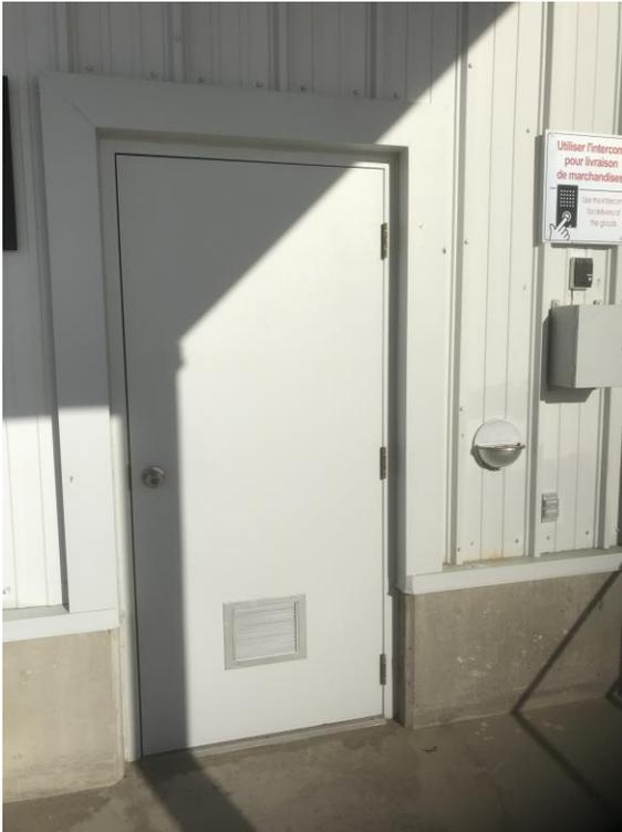
Le nouveau lecteur de carte sera installé sur le mur d'acier du côté gauche de la porte. Se référer au groupe de quincaillerie 03. Tous les conduits d'alimentation électrique devront être dissimulés derrière le revêtement métallique.
