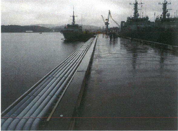
③ 6 x 100 mm ELECTRICAL CONDUITS ON CABLE TRAY
