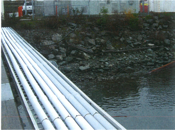
④ 6 x 100 mm ELECTRICAL CONDUITS ON CABLE TRAY
