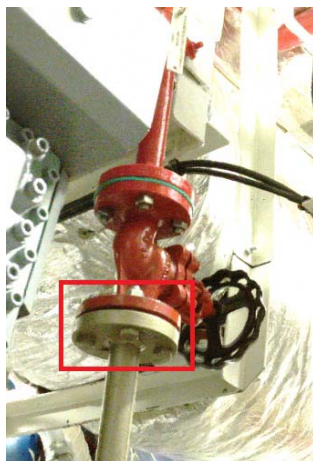
Figure 2 : Raccordement du collecteur d'incendie au système de la cale (valve V555027)
