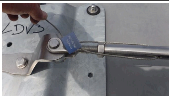
Plomb du fabricant suite à l'installation.
