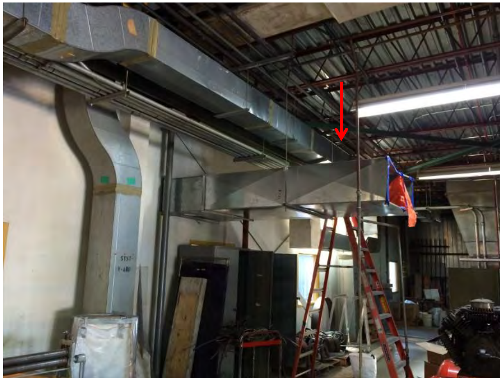
Photos 15 et 16 : Frottis de surface effectué sur un équipement – Exemple de prélèvement sur un conduit de ventilation (éch.# E-6 et E-7, C > 11 µg/100 cm 2 )
