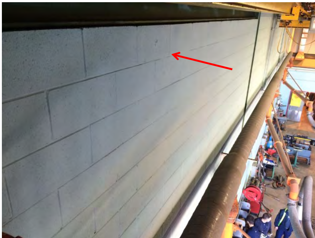
Photos 5 et 6 : Exemple de frottis de surface effectué sur le mur 3 – Échantillon prélevé en hauteur dans la portion de gauche (éch.# M3-1)
