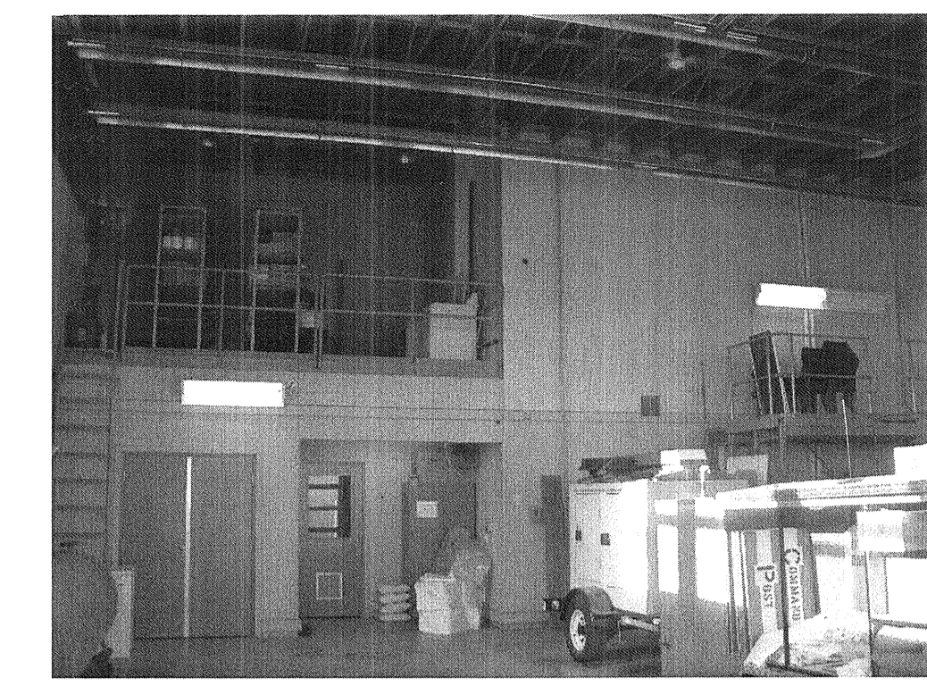
C FIRE HALL E304
