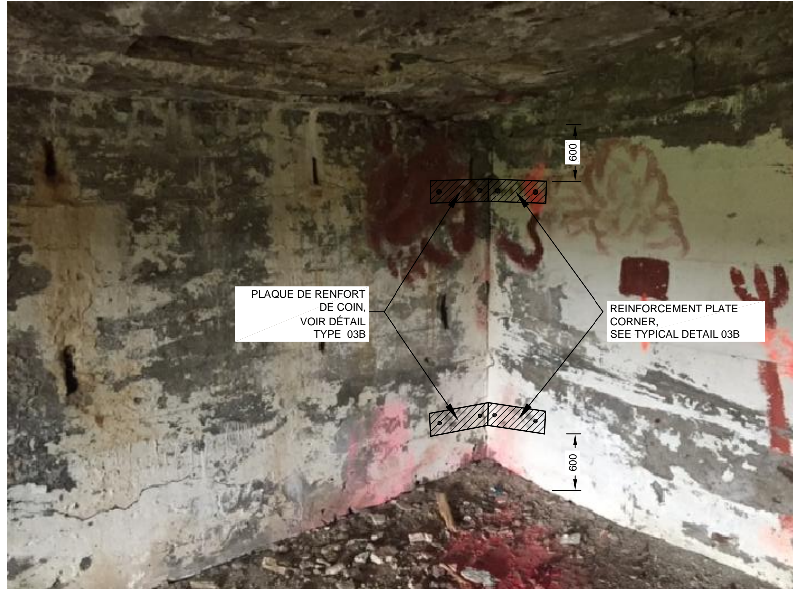
PHOTO 2 - PLAQUE DE RENFORT MURS INTÉRIEURS / REINFORCEMENT PLATE INTERIOR WALLS
