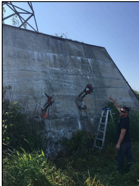
Positionnement du carottier pour le forage F7 sur le mur nord-ouest
