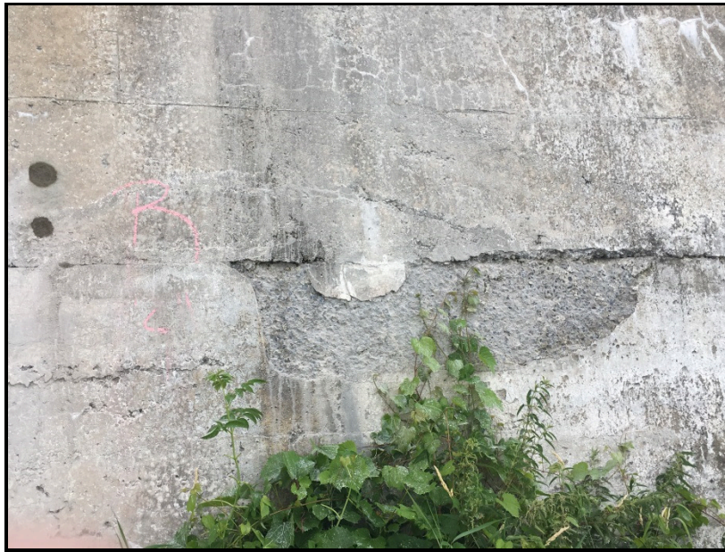
Béton délaminé et localisation de carottes supplémentaires
