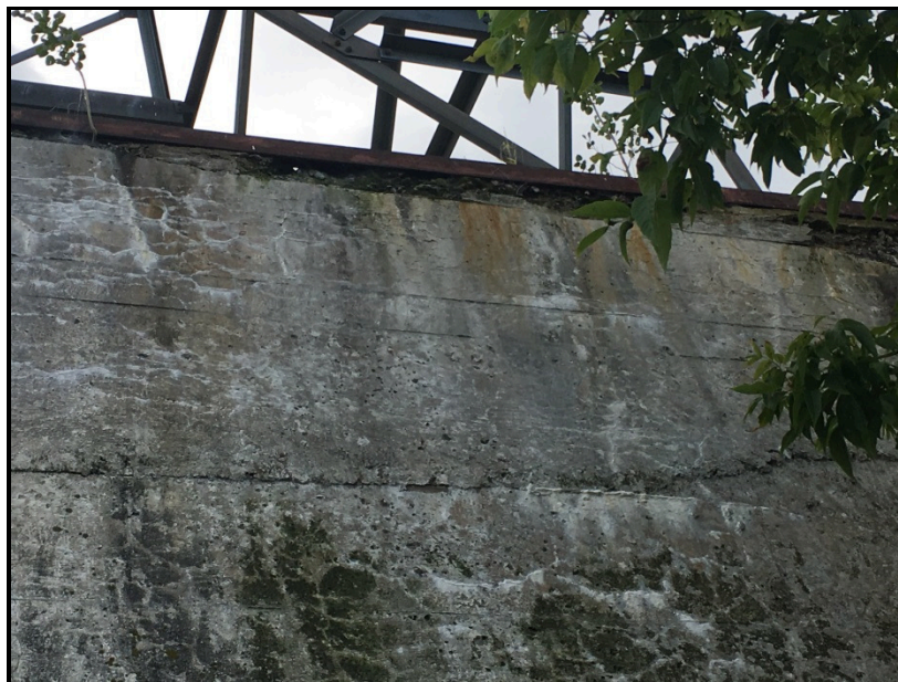
Fissuration type causée par réaction alcalis-granulats
