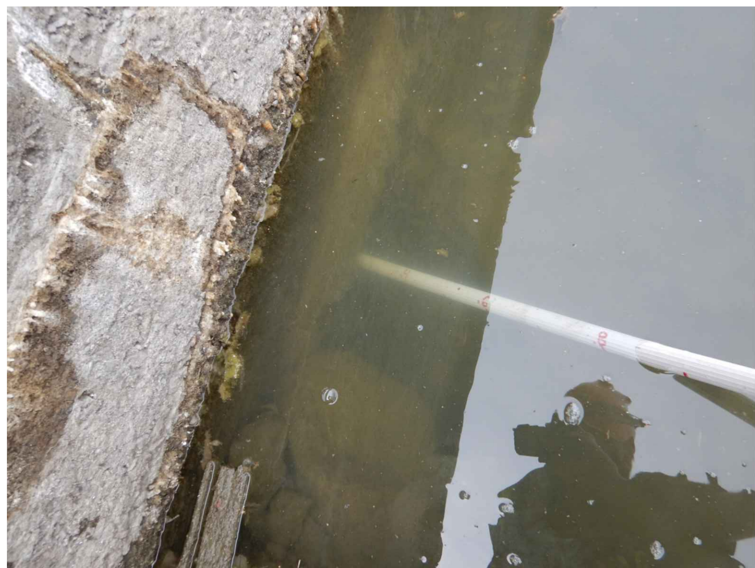
PHOTO 15-9024 MUR GAUCHE - AVAL PICTURE LEFT WALL - DOWNSTREAM
