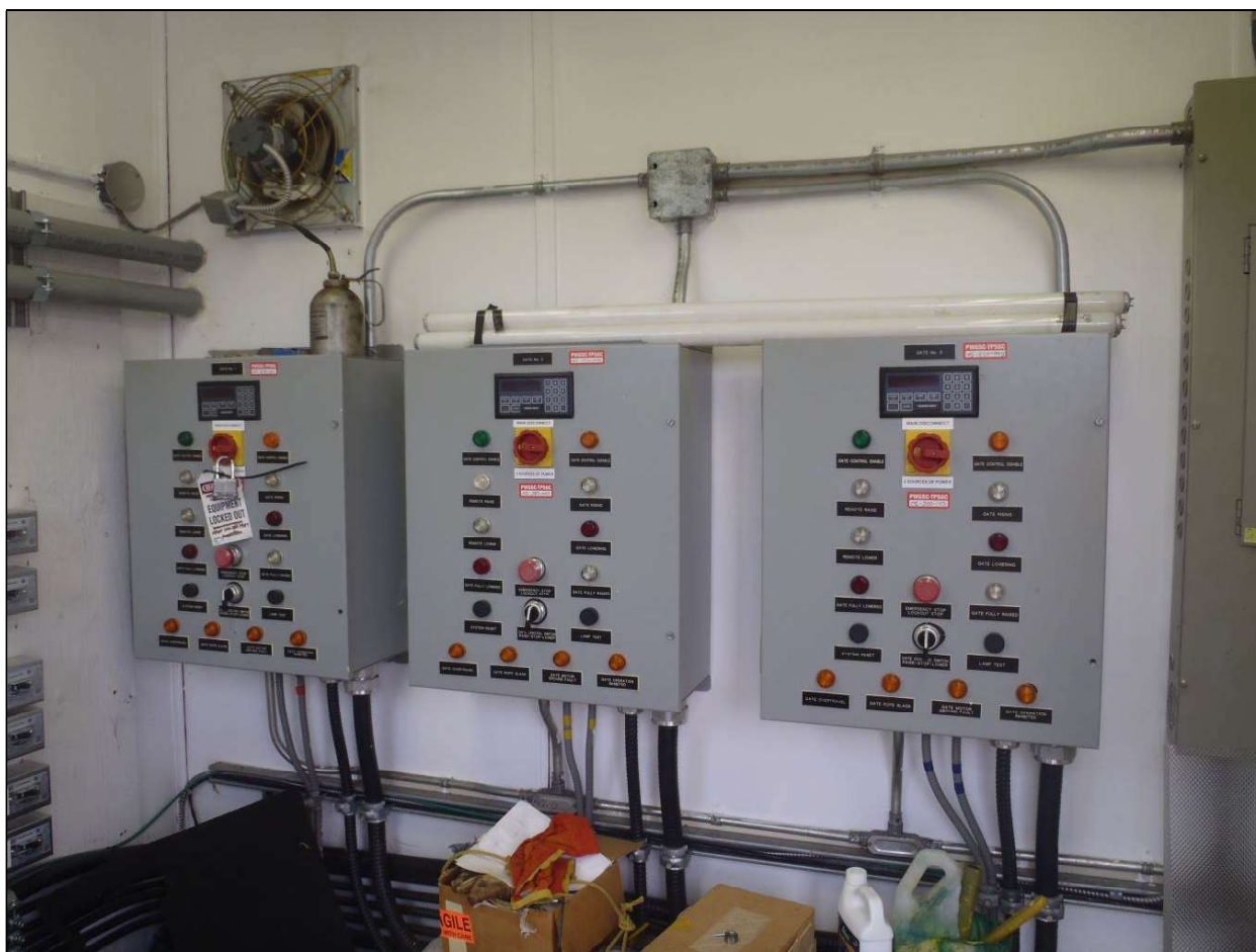
Figure 14 - Tableaux de commande des trois vannes à l'intérieur de l'édifice électrique. Le tableau de la vanne apparaît en position verrouillée sur cette photo (il n'est présentement pas verrouillé).
