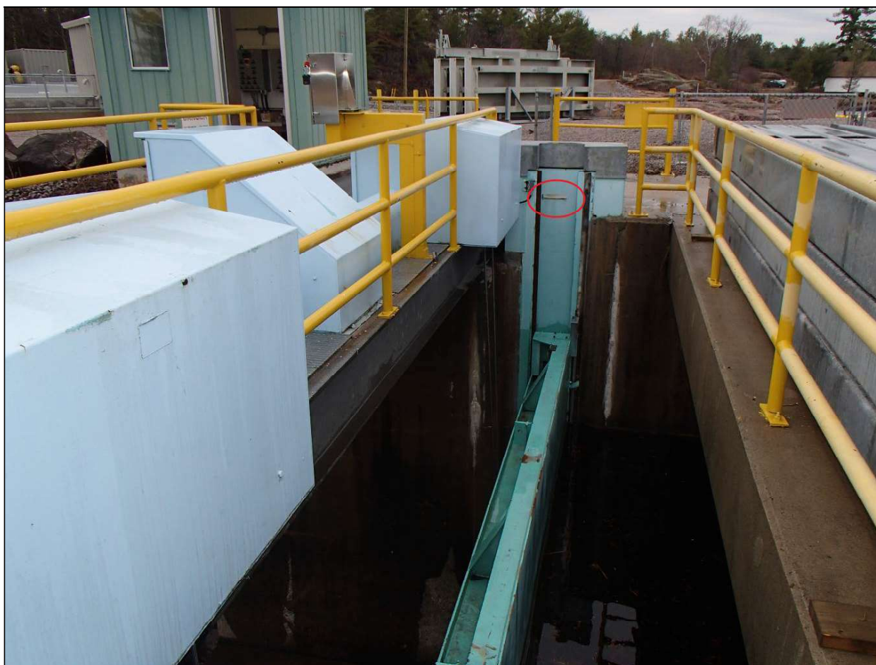
Figure 12 - Vanne n° 1. Le cercle correspond à l'emplacement de la fente de blocage à l'intérieur de la rainure.
