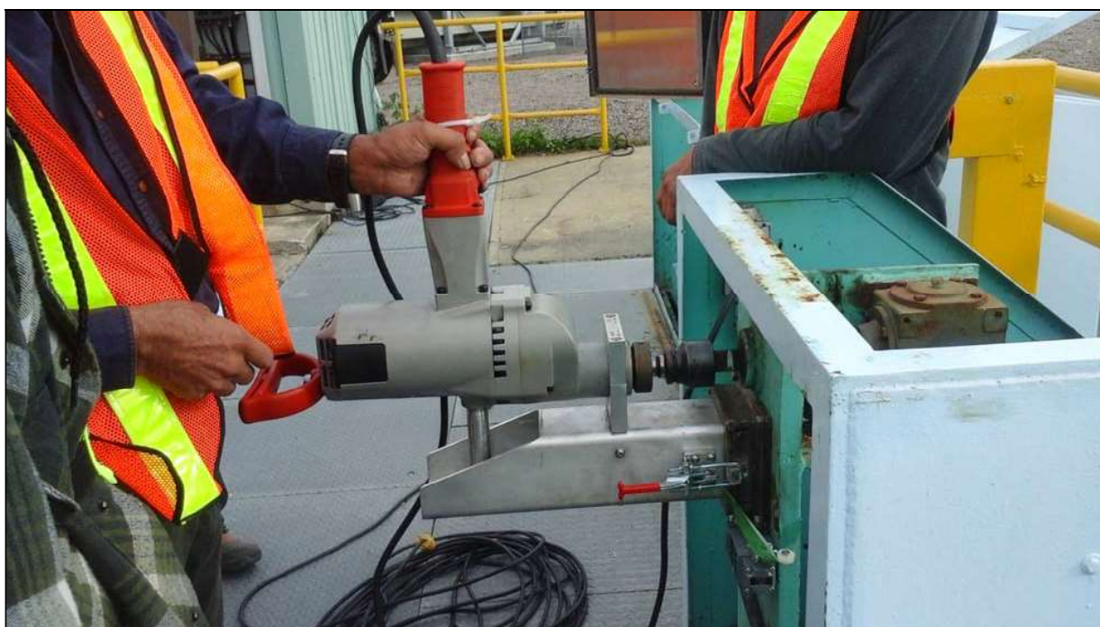
Figure 28 - Fonctionnement de la vanne n° 1 par l'entremise de la boîte de renvoi d'angle Hub City avec perceuse et sabot adapté
