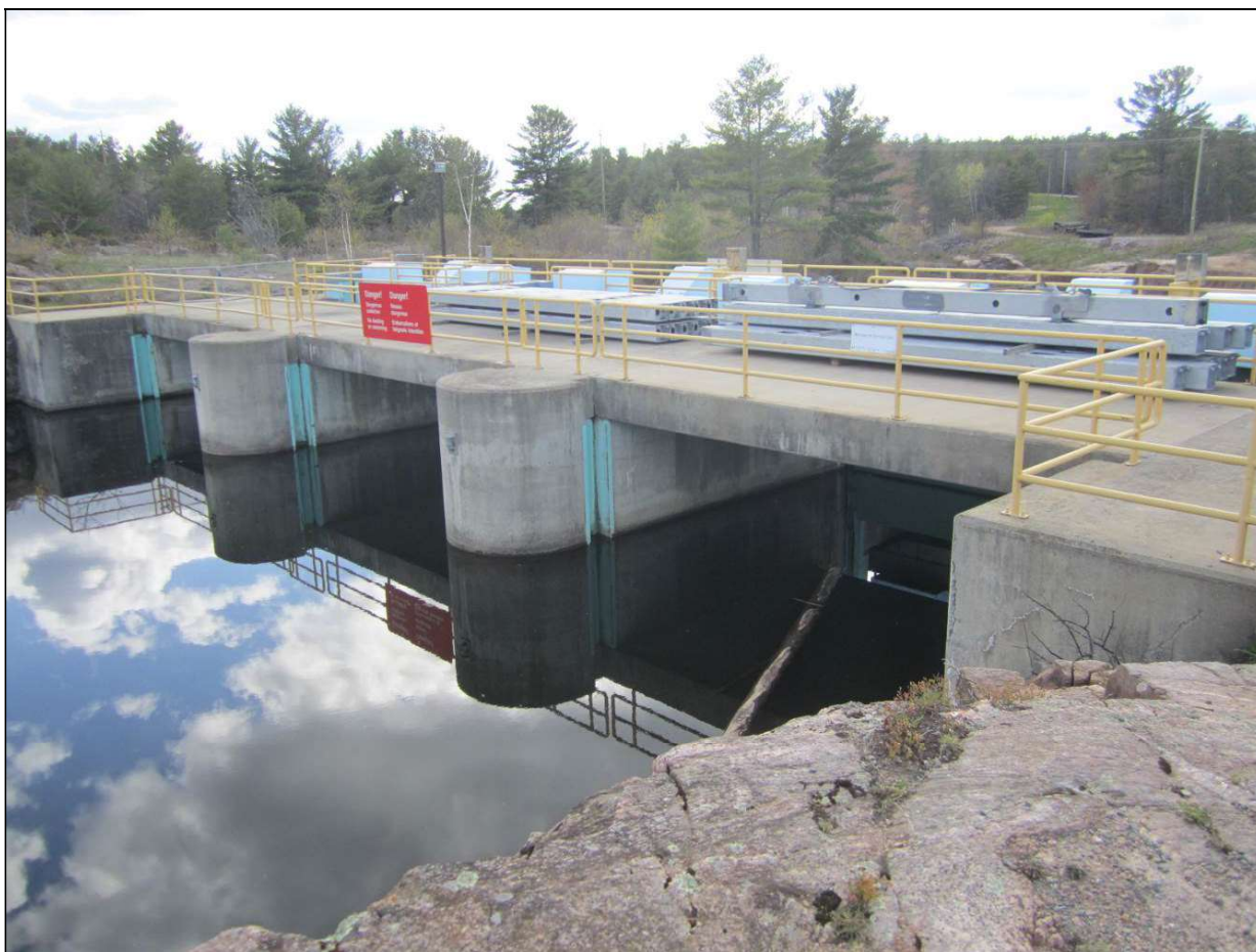
Figure 9 - Vue générale du barrage de Portage depuis la rive droite en amont. Vanne n° 1 en avant-plan.
