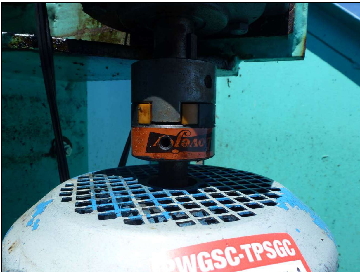
Figure 26 - Raccord flexible Lovejoy entre la boîte de renvoi d'angle Hub City et le moteur.
