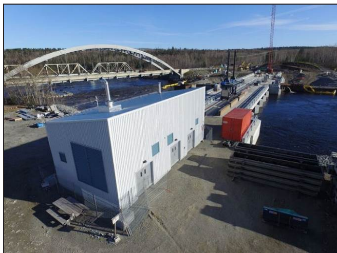
Figure 2 : Bâtiment technique au barrage Latchford. Le groupe électrogène est dans le local à l'avant-plan. Le local central est le local principal des installations électriques.
