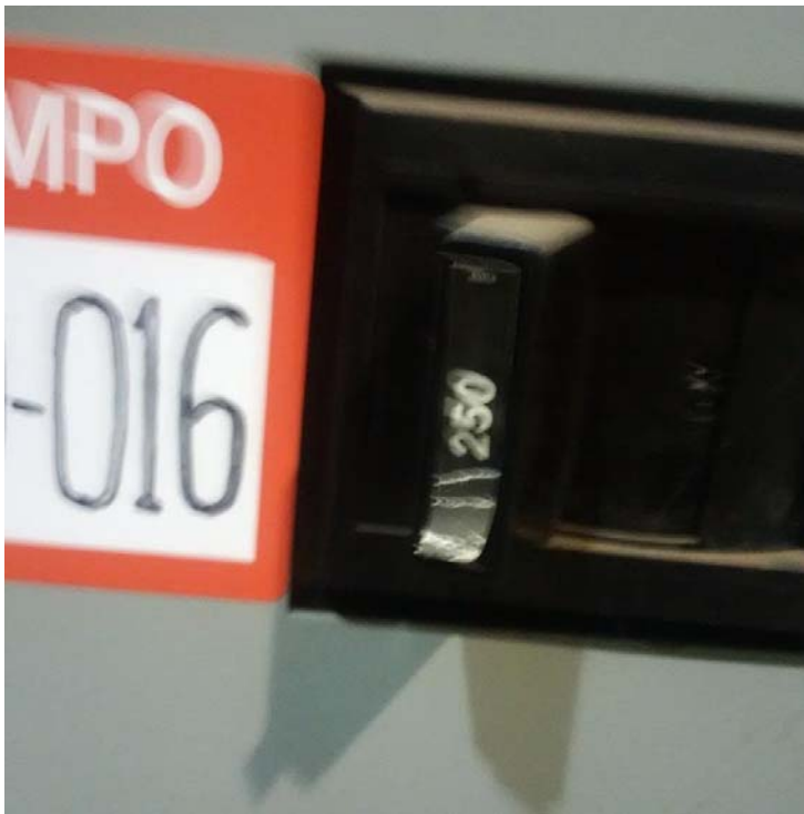
Figure 3: Disjoncteur existant pour le compresseur
