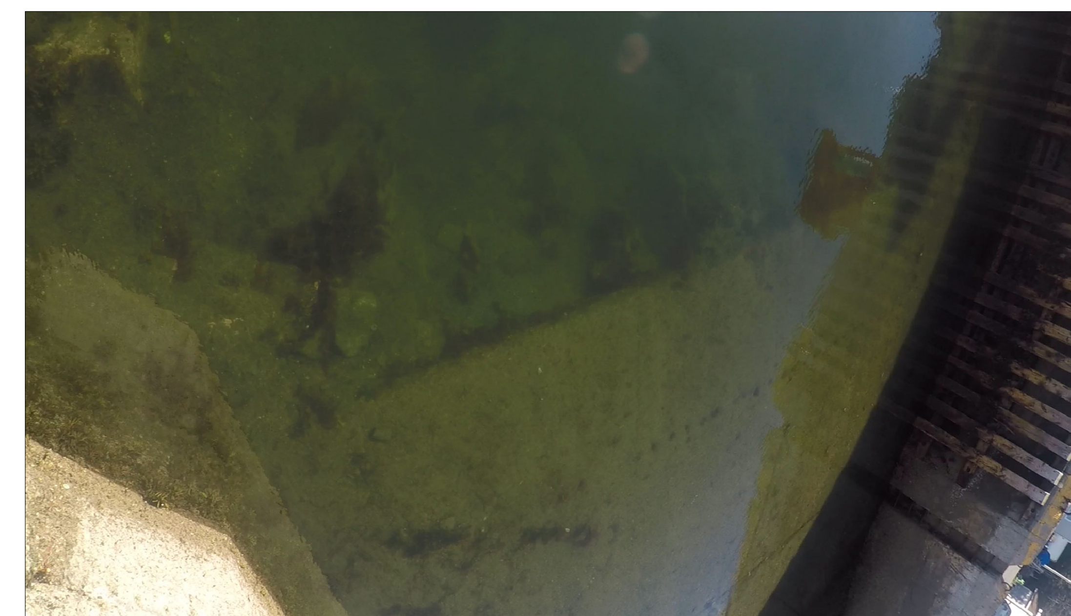
PHOTO 2 - RAMPE DE MISE À L'EAU
