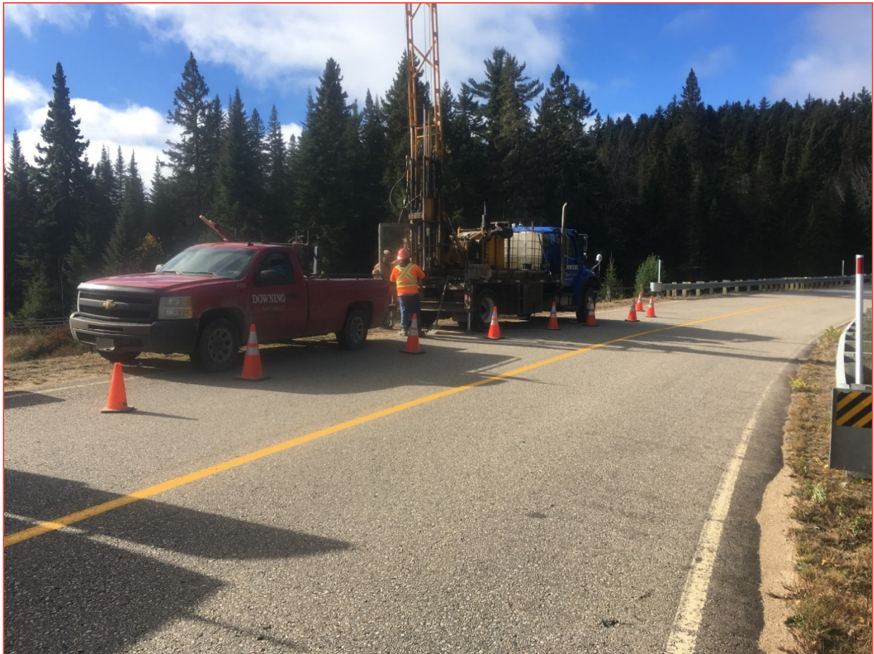
Figure 2-1 État des lieux lors des travaux de chantier, le 19 octobre 2018
