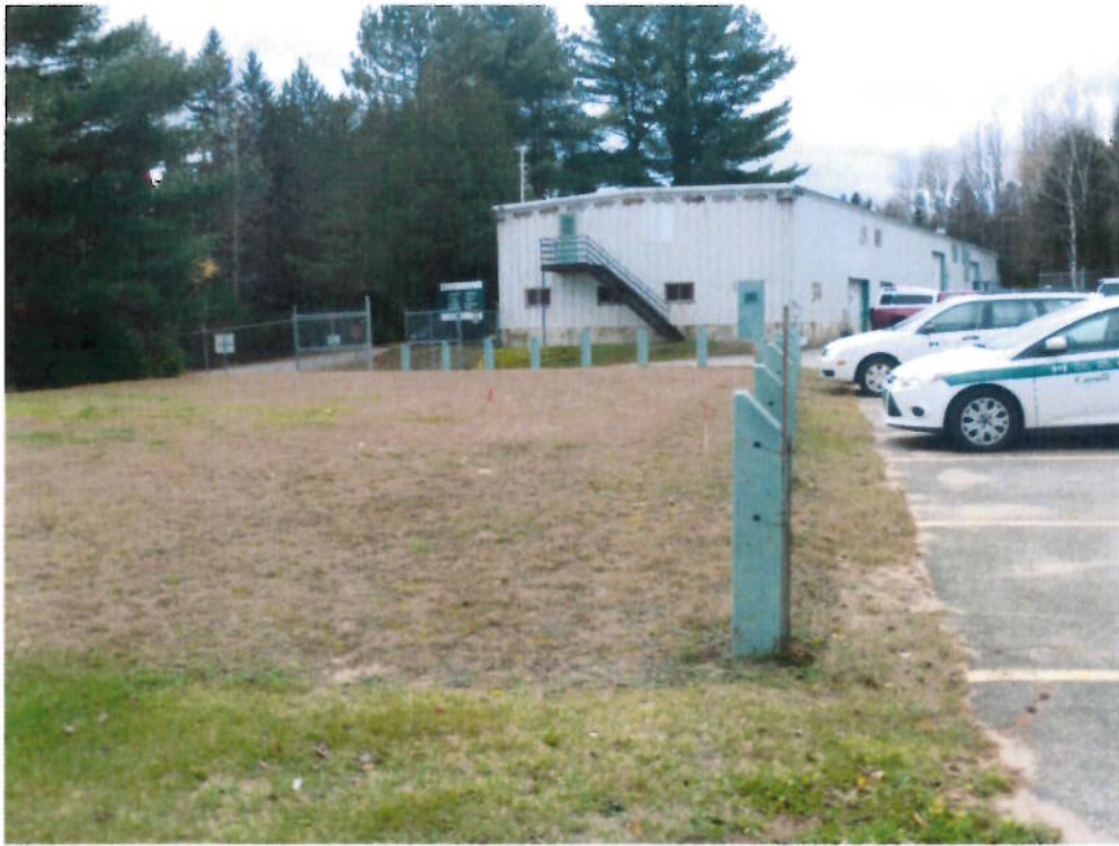
Position de l'élément épurateur existant
