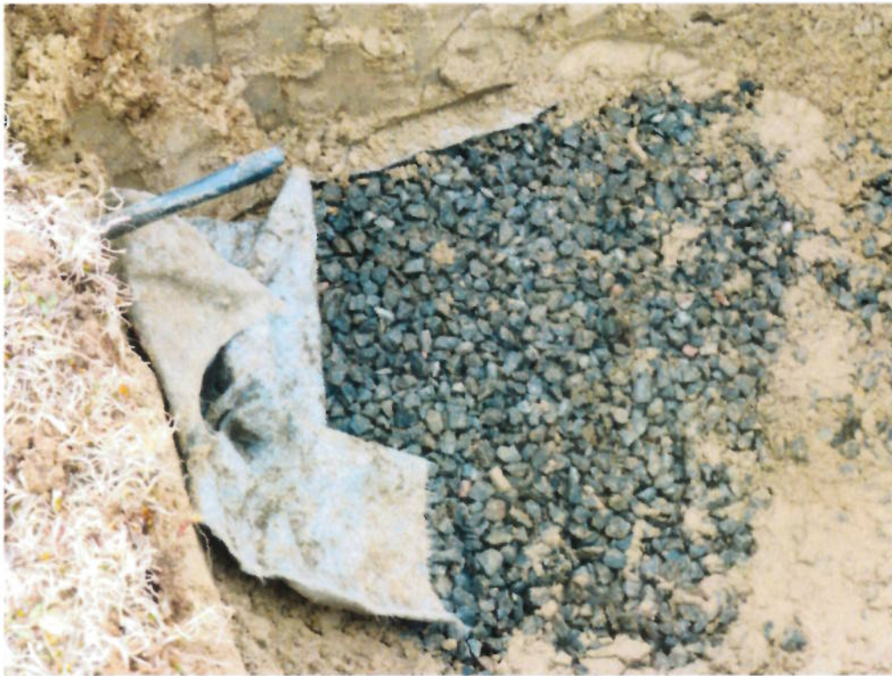
Sondage sur l'élément épurateur existant
