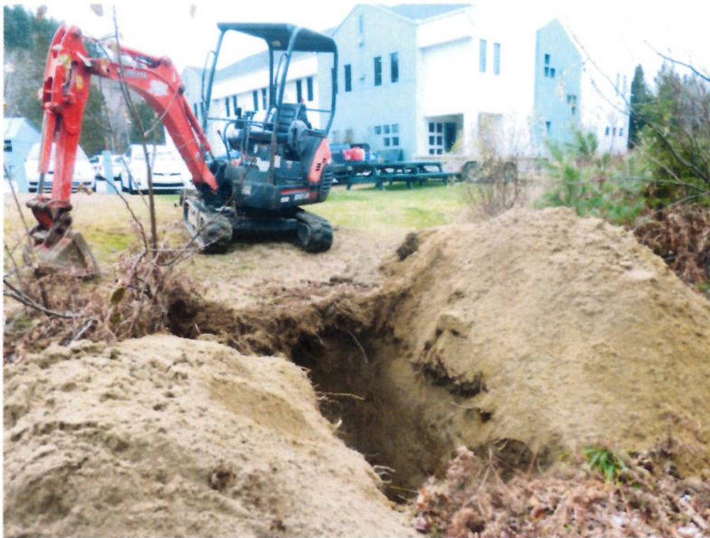
Position du sondage S-4
