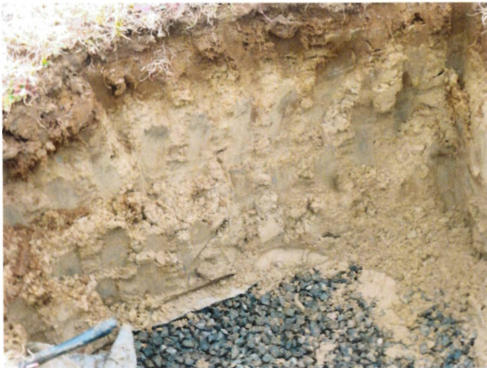
Sondage sur l'élément épurateur existant
