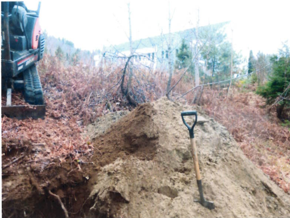
Position du sondage S-6
