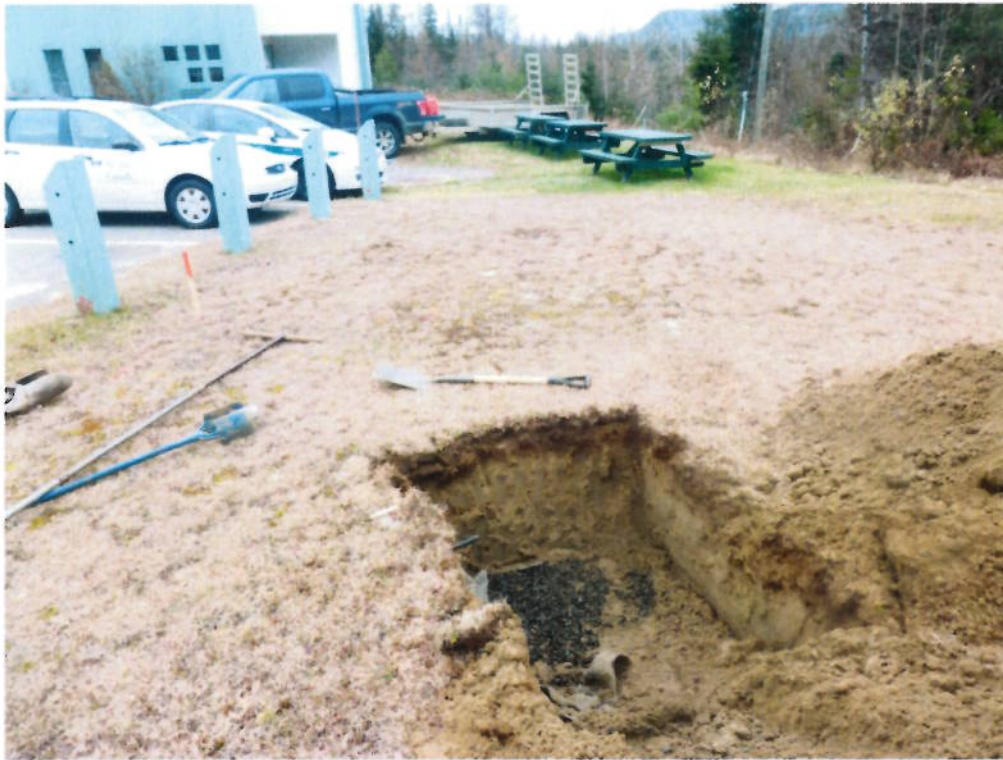
Position du sondage S-1
