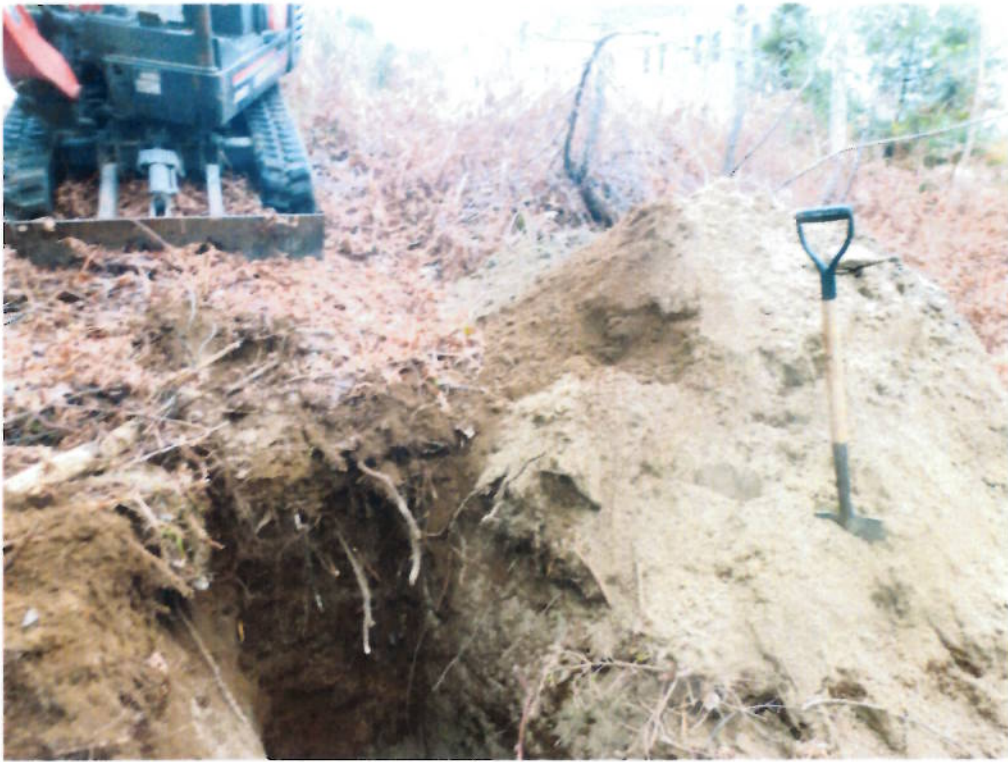
Position du sondage S-6
