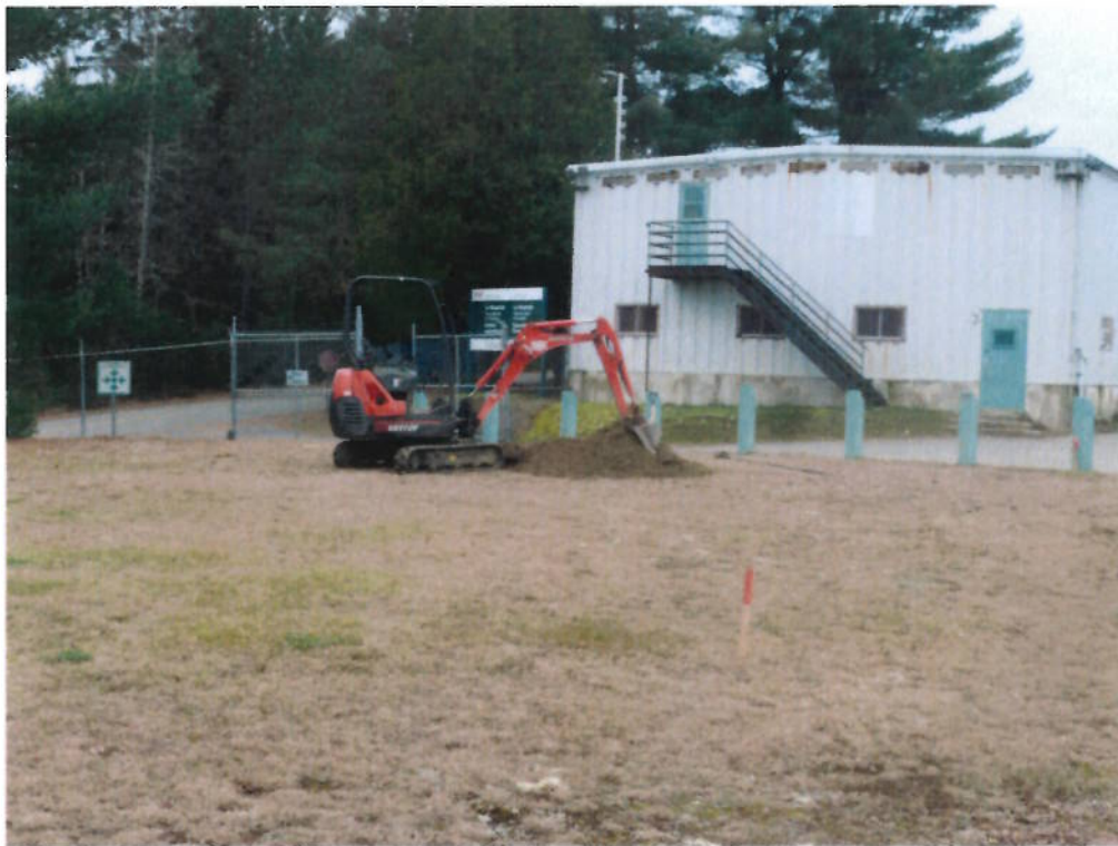
Position du sondage S-2
