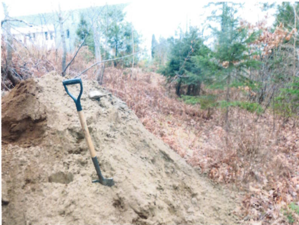
Vue du terrain en bas du talus
