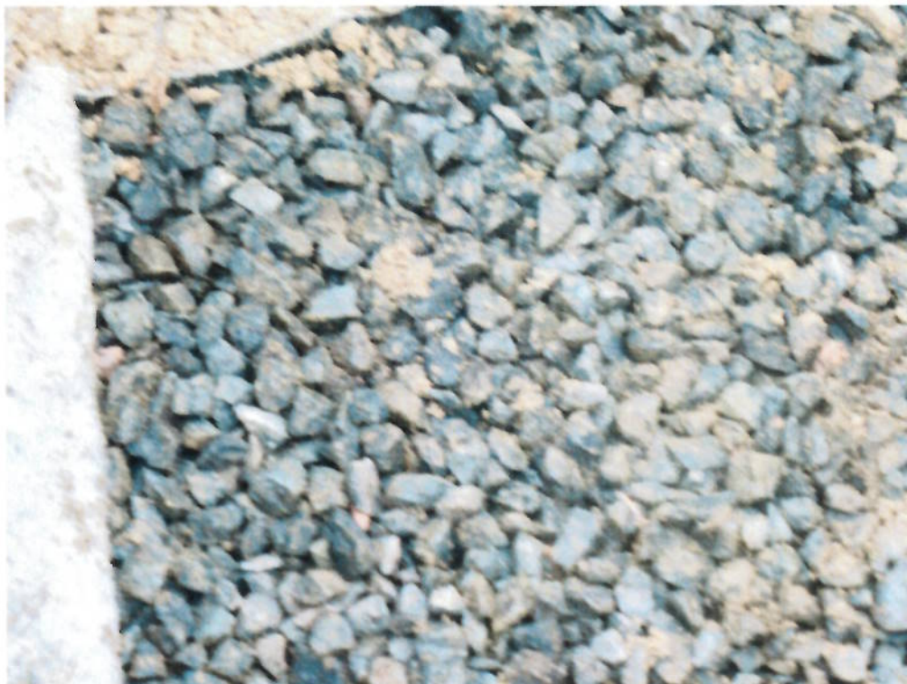
Sondage sur l'élément épurateur existant
