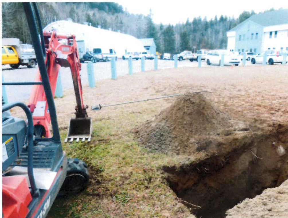
Position du sondage S-5
