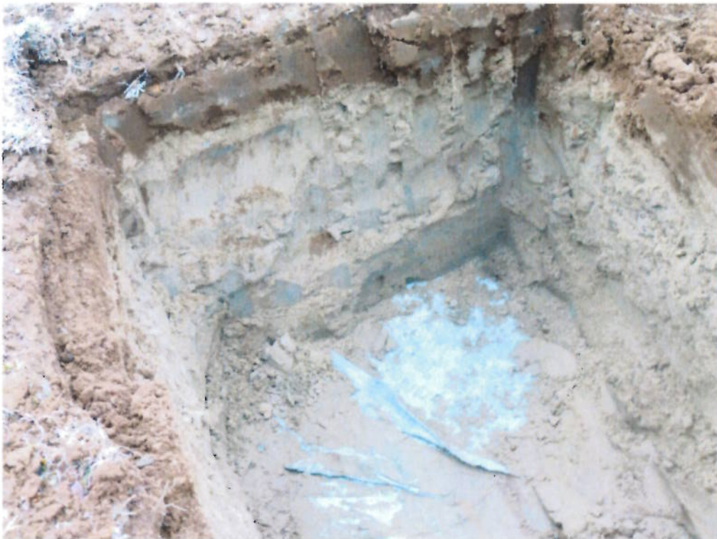
Position du sondage S-2 dans l'élément épurateur existant
