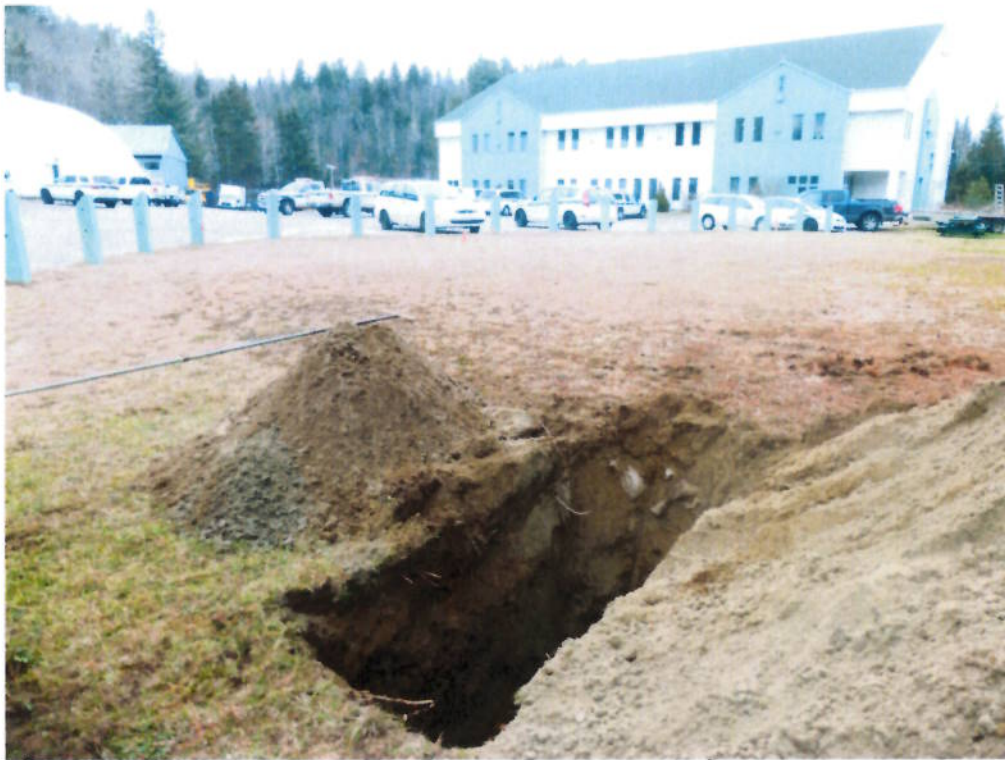
Position du sondage S-5
