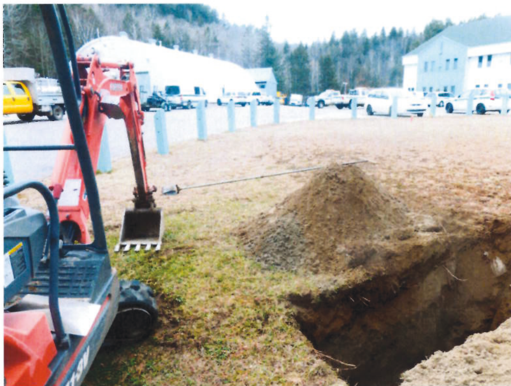
Position du sondage S-5
