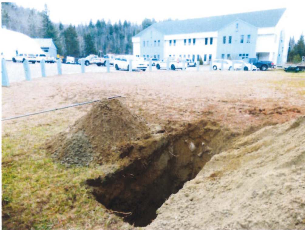
Position du sondage S-5
