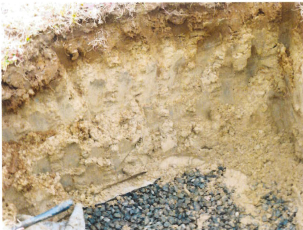
Sondage sur l'élément épurateur existant
