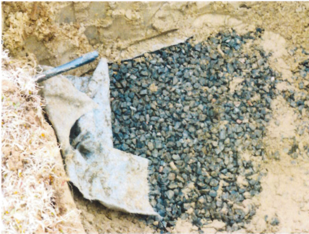
Sondage sur l'élément épurateur existant
