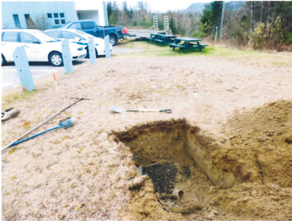
Position du sondage S-1
