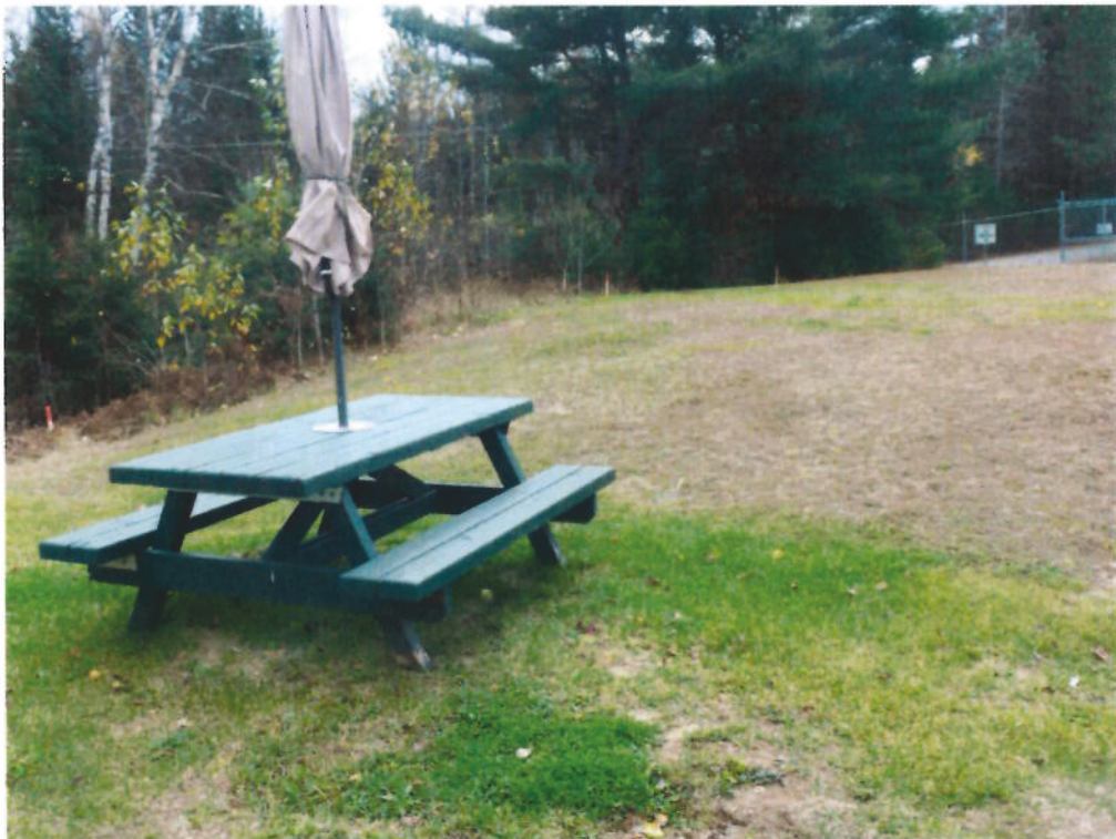
Position de l'élément épurateur existant
