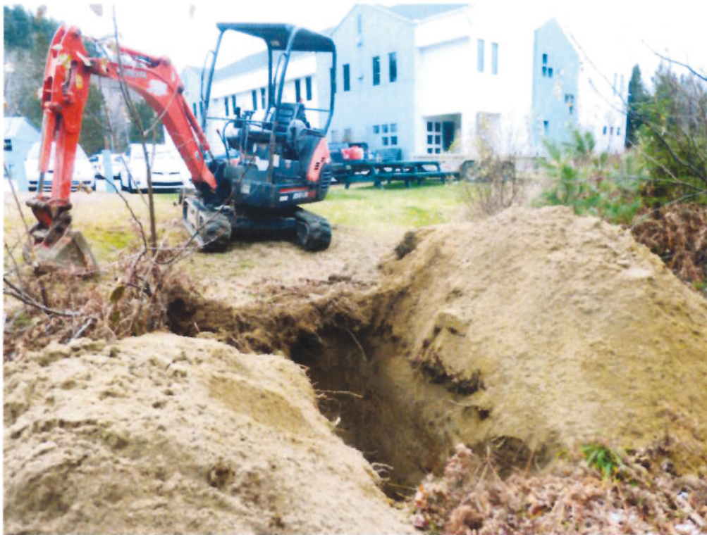
Position du sondage S-4
