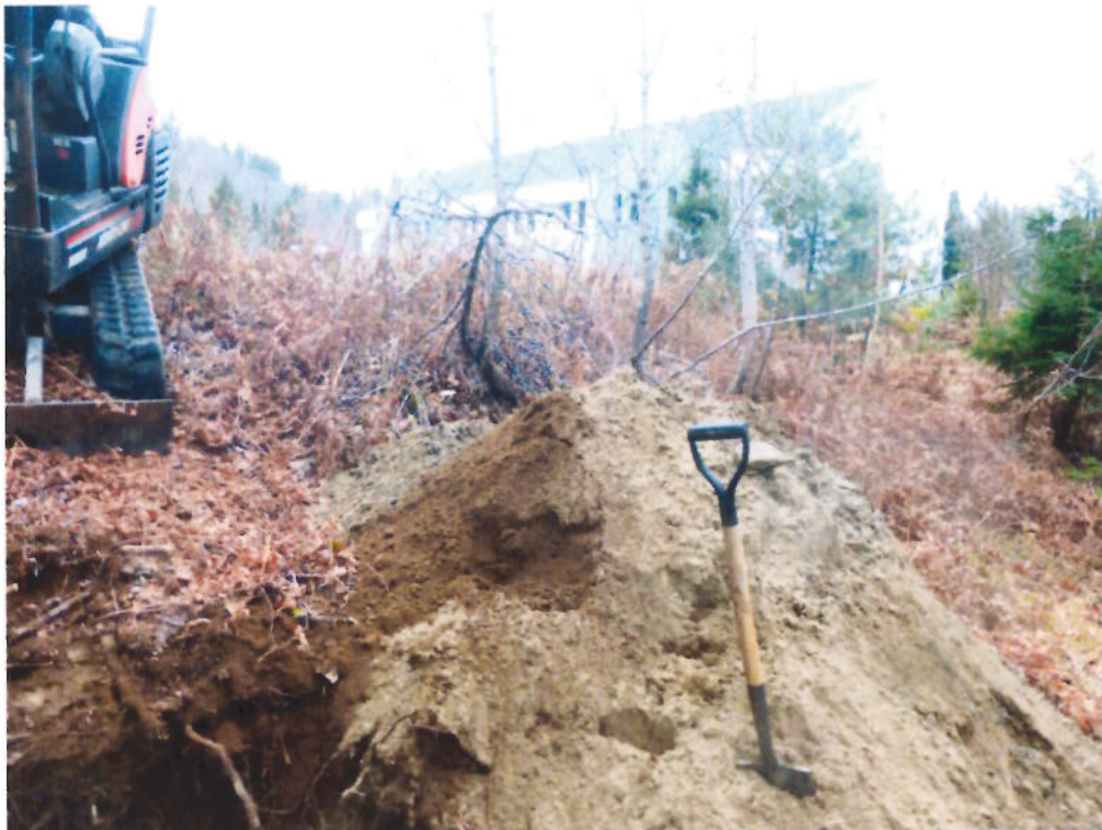
Position du sondage S-6
