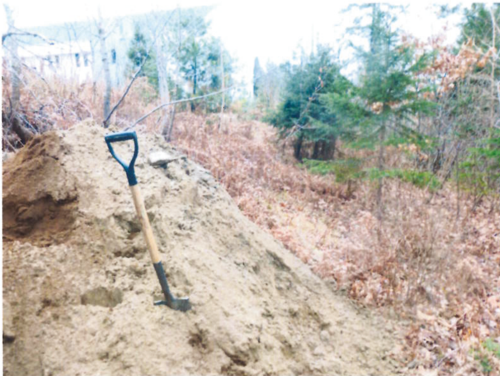
Vue du terrain en bas du talus
