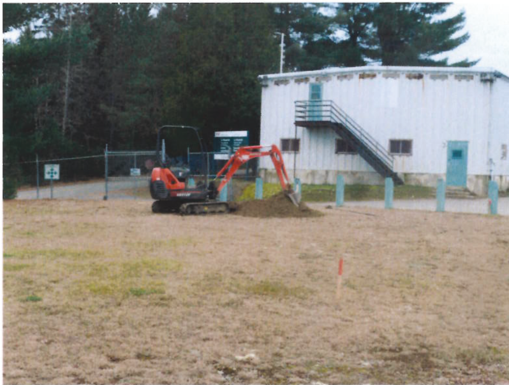
Position du sondage S-2
