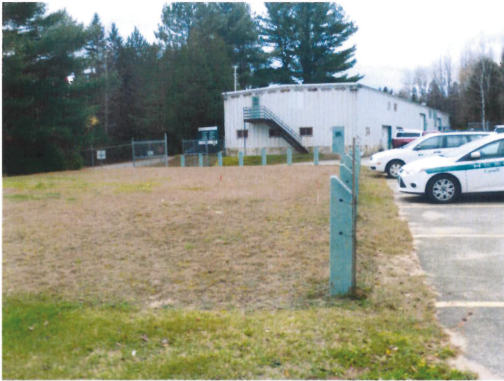
Position de l'élément épurateur existant
