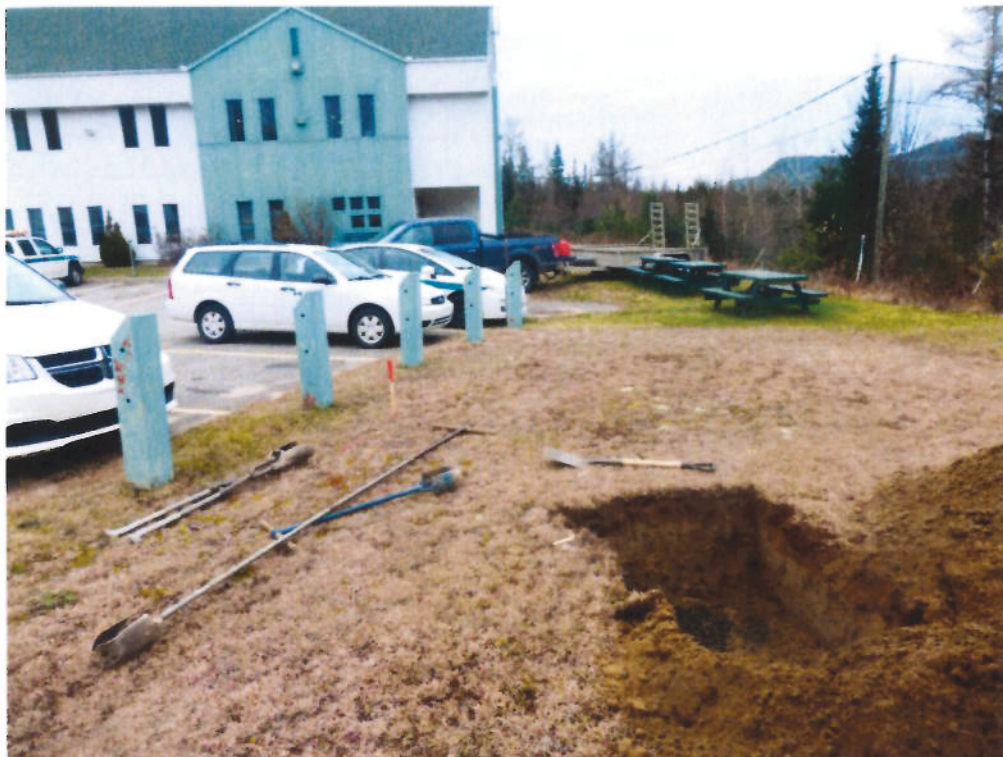
Position du sondage S-1
