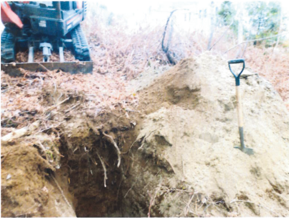
Position du sondage S-6
