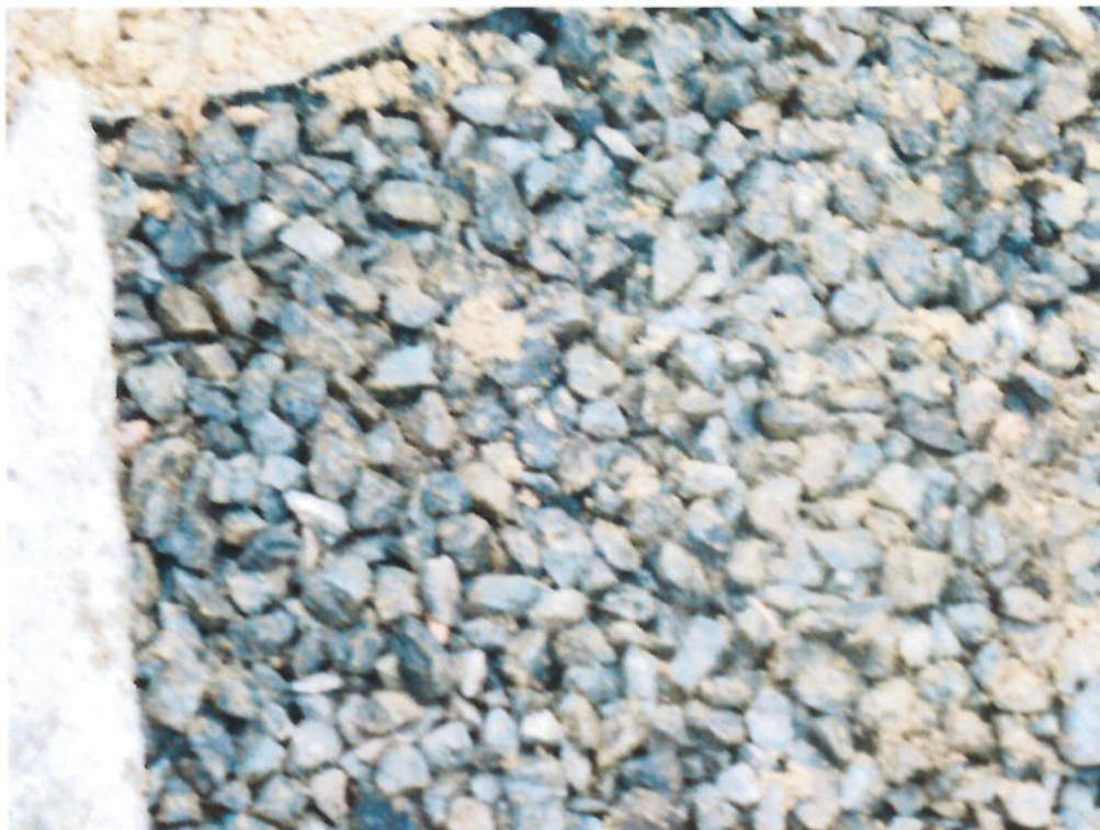
Sondage sur l'élément épurateur existant
